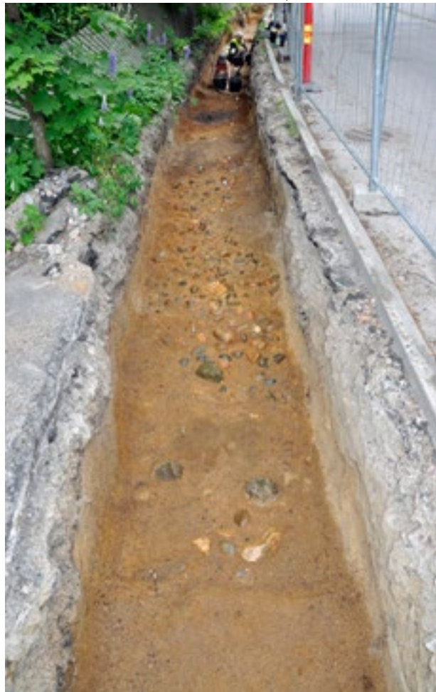
Kaukolämpökaivannon yhteydessä tehtiin arkeologisia kaivauksia Stenkullanmäen ja Keravanjoen välisellä alueella kesäkuussa 2013. Esiin tuli muinaista rantakivikkoa.
