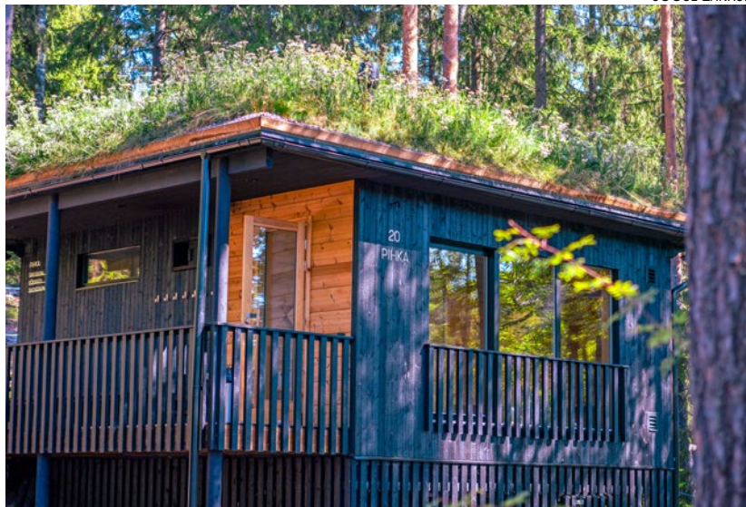
De nya träbyggnadernas ytterbeklädnad har behandlats med en förkolningsteknik som skyddar träet och ger det en mörk färg.
