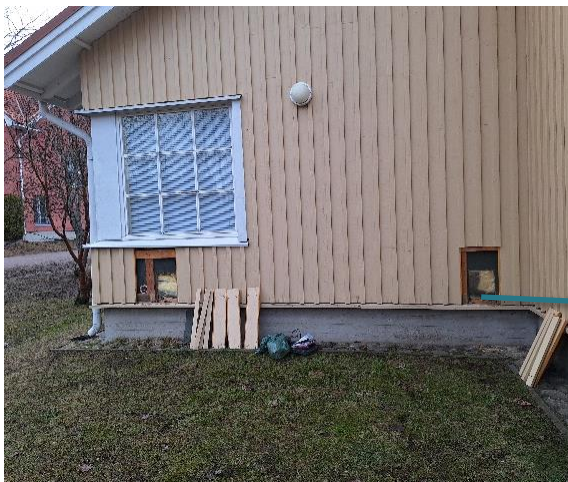
Kuva 71 US12 ja US4 rakennuksen länsipäädyssä.
