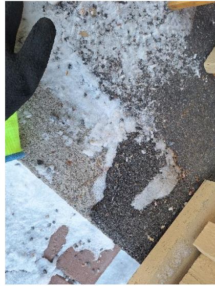
Kuva 34 US5, asfaltin alapuolella on betonia. Lomalaudoituksen vaakalauta on luiskan päällä.
