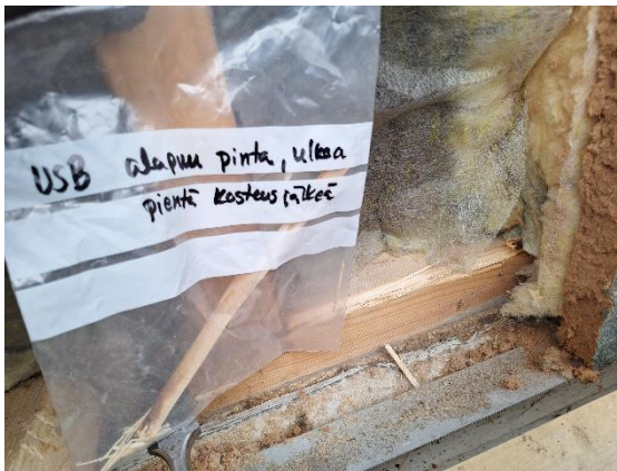
Kuva 17 US3B. Puunäyte alaohjauspuun ulkopinnasta.
