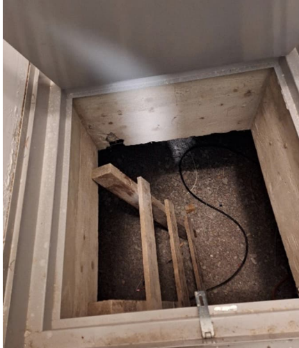
Kuva 16 Kulkuluukku alapohjatilaan on varastotilassa 115.
