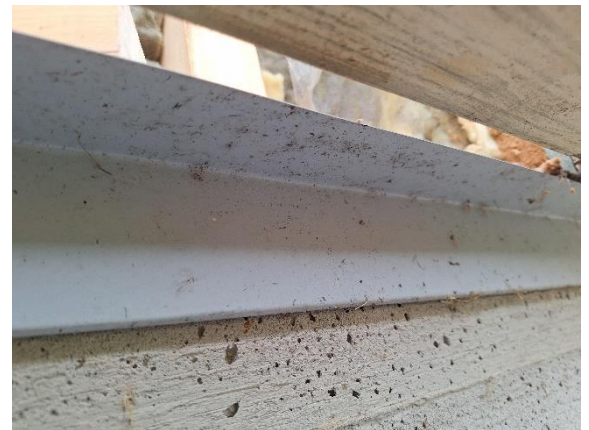
Kuva 18 US3B. Julkisivun vaakapuun ja pelttilistan väliin jäävä tuuletusväli on 20 mm.
