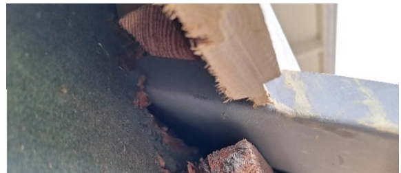
Kuva 37 Tuuletusväli on pellityksen alla.
