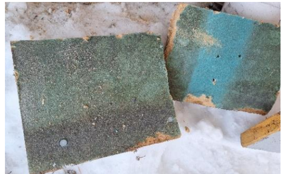
Kuva 56 US9. Tuulensuojalevyn ulkopinta on tummunutta, mikä on normaalia.
