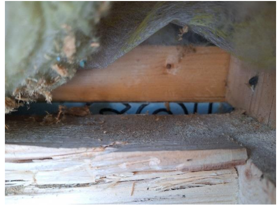
Kuva 54 US9. Sisemmän koolauspuun alla on sinistä polyuretaanilevyä.
