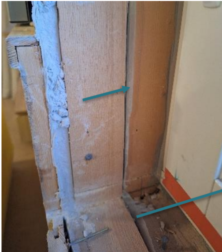
Kuva 81 US13. Höyrynsulkumuovi on ikkunarakenteen puukoolausten välissä.
