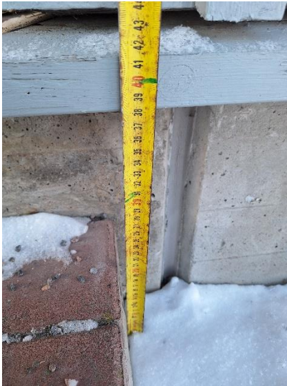
Kuva 33 US5, betoniluiskan korkeus maanpinnan tasosta.
