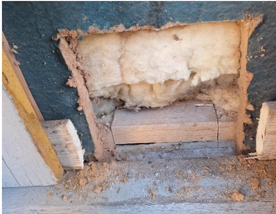
Kuva 43 US7, alaohjauspuussa ei ole valuma- jälkiä.
