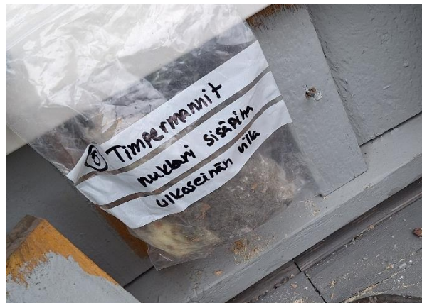
Kuva 4 US1. Avauksesta otettiin mikrobinäyte MN5, jossa oli selvä viite mikrobivauriosta.
