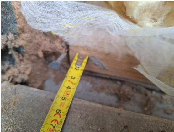
Kuva 65 US11. Alaohjauspuun ja vaakalaudoituksen väli on noin 50 mm.
