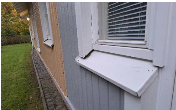
Kuva 36 Ikkunapellin kaato on hyvä.
