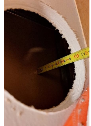
Kuva 81 Avaus VS4 verstaan väliseinään, lähelle ulkoseinää. Avauksessa ei ollut eristeitä.
