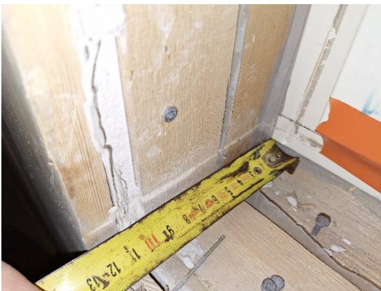
Kuva 85 US13. Sisäpuolinen eristekerros on noin 50 mm.
