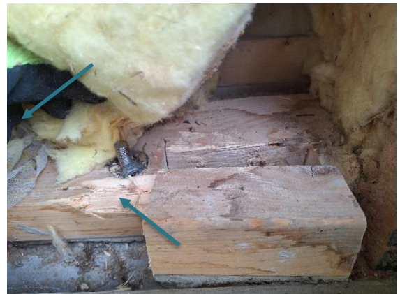
Kuva 68 US11. Alaohjauspuun näytekohdat.
