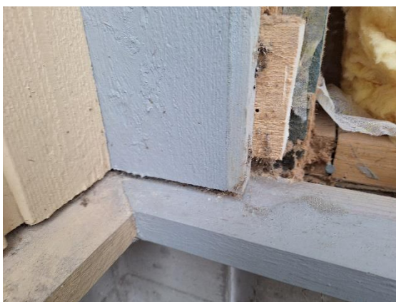
Kuva 69 US11. Sisäkulman rakennetta.
