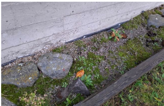
Kuva 10 Länsipäädyssä on nähtävissä patolevy sokkelin maanvastaisissa osissa. Nurmi alueen ja kiveyksen välissä on lauta.
