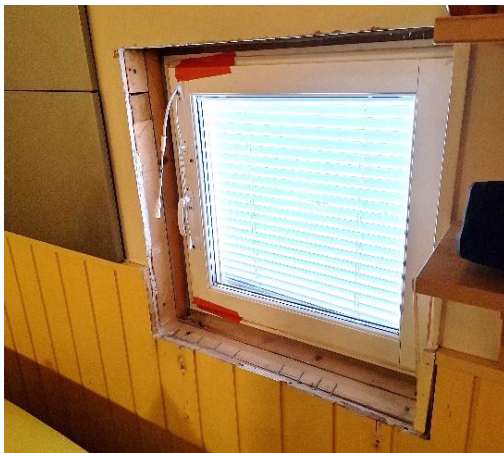
Kuva 79 US13. Ikkunan ja ulkoseinän rakenneliittymän tiiveyden tarkistus.
