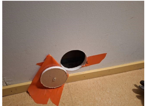
Kuva 79 Vaatehuollon väliseinään tehty avaus VS5.
