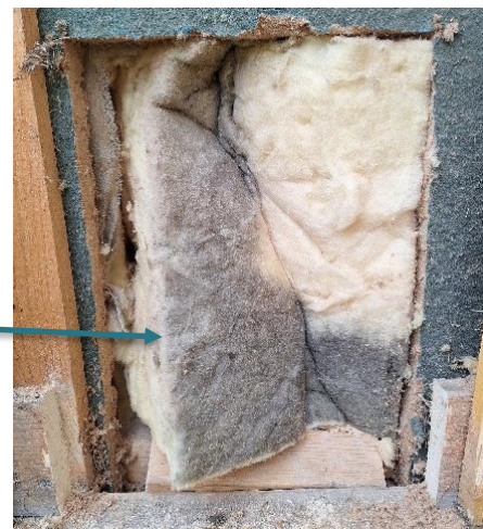
Kuva 72 US12. Eriste on ulkopinnastaan tummunutta.
