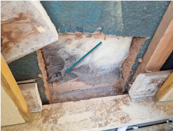
Kuva 48 US8, näyte LN11 otettiin villan tummuudesta ulkopinnasta.
