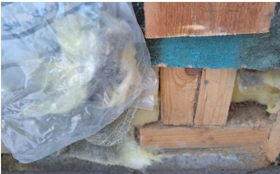
Kuva 55 US9. Näyte LN7 otettiin villan tummuneesta ulkopinnasta, ja näyte LN8 alaohjauspuun yläpinnasta.
