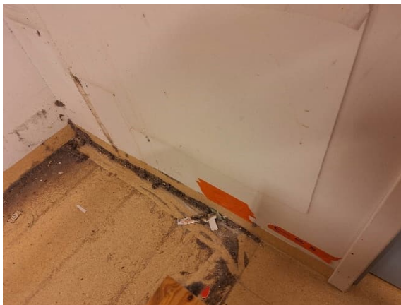
Kuva 82 Portaiden viereen tehty avauskohta VS3, luukun alapuolelle.
