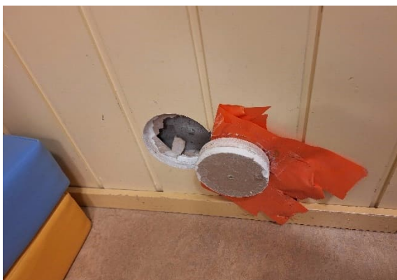
Kuva 84 Avaus VS1 tilan 141 väliseinään, jonka takana on keittiön kylmähuoneet.
