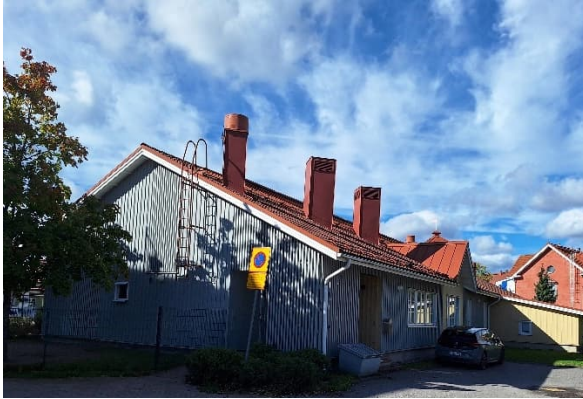
Kuva 4 Yleiskuva julkisivusta, parkkipaikalta katsottuna.
