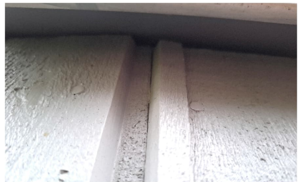
Kuva 37 Tuuletusväli on pellityksen alla.
