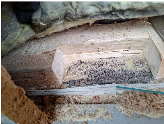
Kuva 19 US3B. Alaohjauspuun alla on bitumi-huopa.
