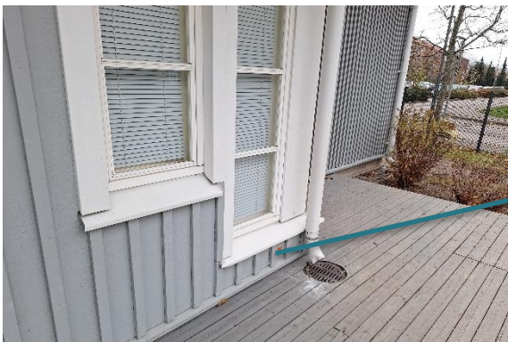
Kuva 1 US1. Rakenneavaus nukkumatilán 141 ikkunan alapuolelle, lähelle sadevesisyöksyä.
