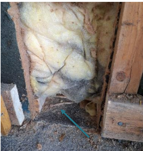
Kuva 35 US5. Alaohjauspuu on betonilaiturin tasolla. Puun rakennekosteus on normaali: 7,5 p-%.
