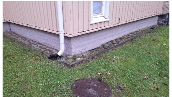
Kuva 9 Länsipäädyn salaojan tarkastuskaivo sekä sokkelin vierustan kiveystä.
