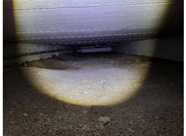
Kuva 17 Yleiskuva tuulettuvasta alapohjatilasta.
