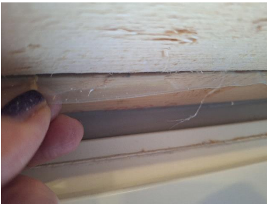
Kuva 83 US13. Höyrynsulkumuovia ikkunan yläpuolella.
