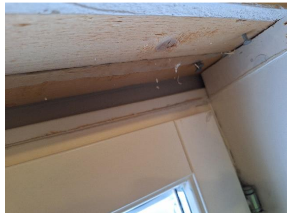
Kuva 84 US13. Ikkunan ympäri on vedetty harmaa tiivistysmassa
