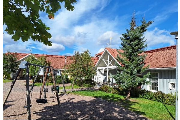
Kuva 5 Yleiskuva julkisivusta, sisäpihalta päin.
