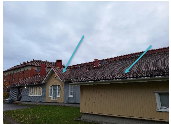
Kuva 101 Jyrkemmällä osalla on peltikatetta. Väestösuojan katto on tasaisempi (edessä).
