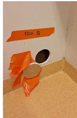
Kuva 81 Avaus VS4 verstaan väliseinään, lähelle ulkoseinää. Avauksessa ei ollut eristeitä.
