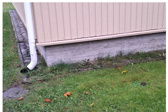
Kuva 13 Syöksyt ovat tarpeeksi pitkät eikä roiskevesistä johtuvia kosteusjälkiä näkynyt sokkelin pinnassa.
