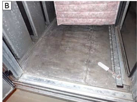
Kuva 117 a-b. Ulkoilmapellit sulkeutuivat tarkastetuilla iv-koneilla. Suodatinsuodattimet ovat silmämääräisesti tiiviitä ja niiden tiivistykset ehjiä. Suodatinkammioiden pohjilla on paikoin kalkkihärmää, sekä jälkiä seisoneesta vedestä. Kuvissa on iv-kone TK09.
