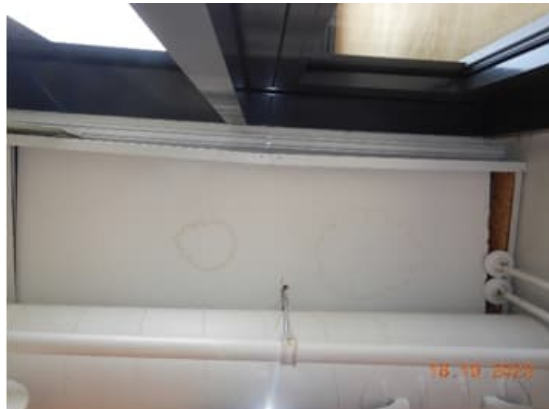
Kuva 56 a-b. Solun G2 Luokahuoneessa 2030 on ikkunoiden edustalla alakatossa vuotojälkiä. Jälkien kohdalla ei havaittu alakatossa aktiivisia kosteuslähteitä. Vuotojälkien kohdalla on jäähdytysputket, joissa on pistesyöpymän paikkausjälki, joka on todennäköisin vuotojälkien aiheuttaja.
