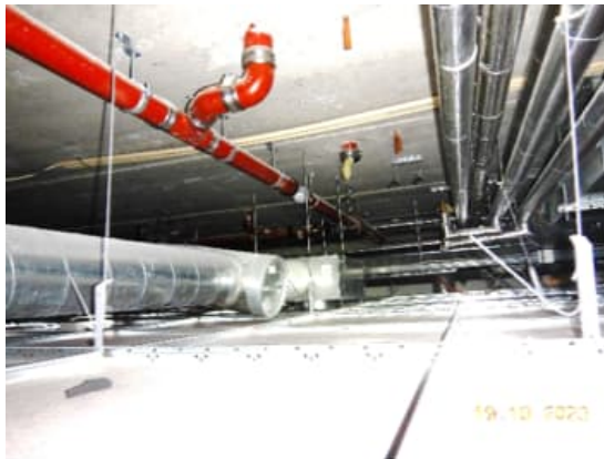
Kuva 58 a-b. Alakattojen sisällä havaittiin useassa paikassa käytöstä poistettuja viemäri- ja vesijohtoputkia. Osa putkista on tulpattu muovitulpilla ja osaa putkista ei ole tulpattu ollenkaan.
