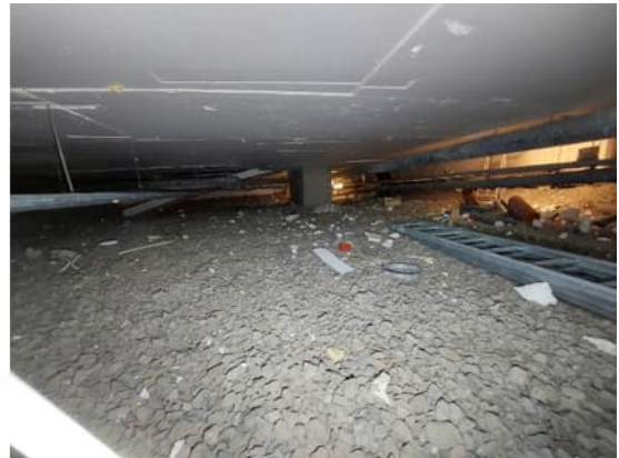
Kuva 18 a-b. Ryömintätila on tehtyjen havaintojen mukaan kokonaan yhtenäistä tilaa, eikä siinä ole erillisiä osastoiteja. Ryömintätilassa ilma oli kohtalaisen raikas, eikä irtovettä havaittu.
