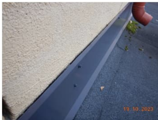
Kuva 100 a-b. [redacted] kermikaton seinällenostojen pellitykset eivät ole vesitiiviisti asennettu seinäpintaan. Pellityksen alla
