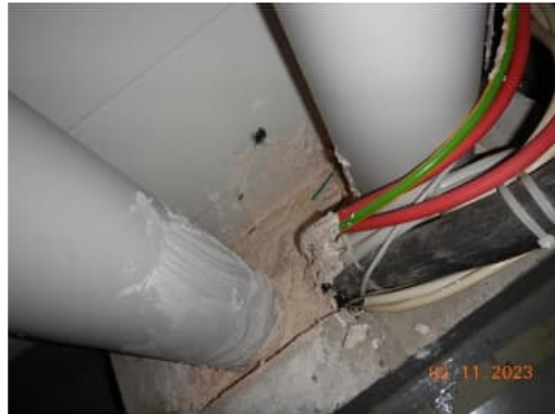
Kuva 109 a-b. IV-konehuoneissa läpiviennit on tiivistetty lattian epoksinnoitteella sekä palokatkomassalla.
