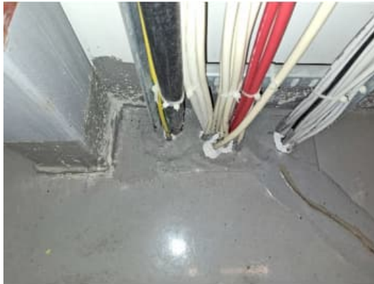
Kuva 109 a-b. IV-konehuoneissa läpiviennit on tiivistetty lattian epoksinnoitteella sekä palokatkomassalla.
