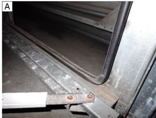
Kuva 117 a-b. Ulkoilmapellit sulkeutuivat tarkastetuilla iv-koneilla. Suodatinsuodattimet ovat silmämääräisesti tiiviitä ja niiden tiivistykset ehjiä. Suodatinkammioiden pohjilla on paikoin kalkkihärmää, sekä jälkiä seisoneesta vedestä. Kuvissa on iv-kone TK09.
