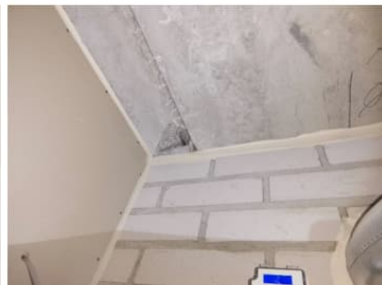
Kuva 89 a-d, Hissin 1134 ympärillä olevien tekniikkakuilujen liittymät alakattojen sisällä eivät ole ilmatiiviitä. Kuilun yläpäässä yläpohjan vastaisessa liittymässä on reilu yhden tiilen kokoinen aukko (kuva a, ympyröity punaisella). Myös muilta osin kuiluista on ilmayhteyksiä mm.
