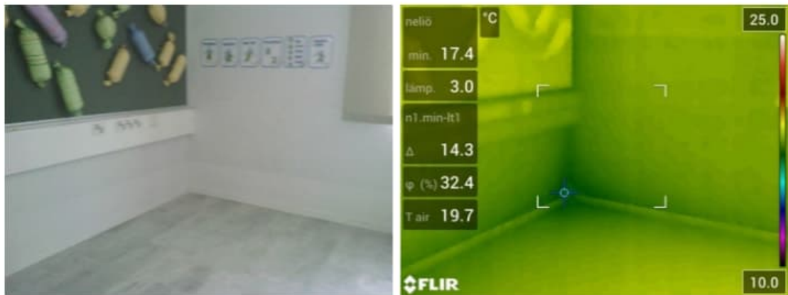
Kuva 36 a-b. Esimerkkikuva lämpökameralla tehdystä katselmuksesta. Alapohja-ulkoseinäliittymissä ei havaittu ilmavuotoja.
