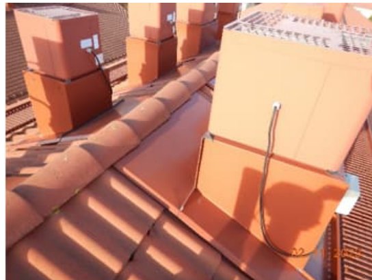
Kuva 97 a-b. Tarkastetuilta osin vesikatteen läpiviennit vaikuttivat hyvin tehdyiltä ja tarkoituksenmukaisilta. Huippuimurit on sijoitettu lähelle harjaa ja pellitys viety harjatiilen alle. Viemärintuuletusputkien ja yläpohjan alipainetuulettimien läpiviennit on tehty tiilikattoon soveltuvalla valmisläpivientikappaleella.
