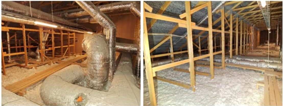
Kuva 101 a-b. Yleiskuvat ullakkotiloista. Ullakkotiloissa on asianmukaiset kulkusillat ja valaistus. Yleisilmeeltään ullakot ovat hyvässä kunnossa.
