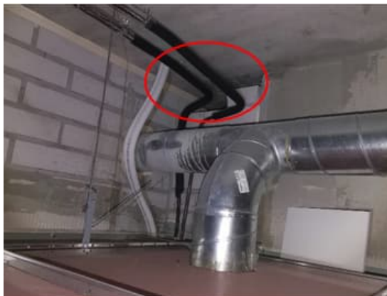
Kuva 88 a-b. F2 Karuna 2117, tekniikkakuiluun tehtiin rakenneporaus, jonka tarkastettiin kuilun sisäpuoli. Kuilussa ei havaittu sinne kuulumatonta jätettä. IV-kanavan läpivienti välipohjaan oli valettu.
