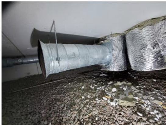
Kuva 19 a-b. Ryömintätilan ilmanvaihto on toteutettu rakennusosien päädyissä olevien poistoilmapäätelaitteiden sekä sokkelin vierustaa pitkin kulkevien tuloilmapäätelaitteiden avulla. Tarkastetulla alueella päätelaitteet toimivat ja ilmavirtaus oli oikeansuuntainen, ryömintätilasta kanavaan päin.
