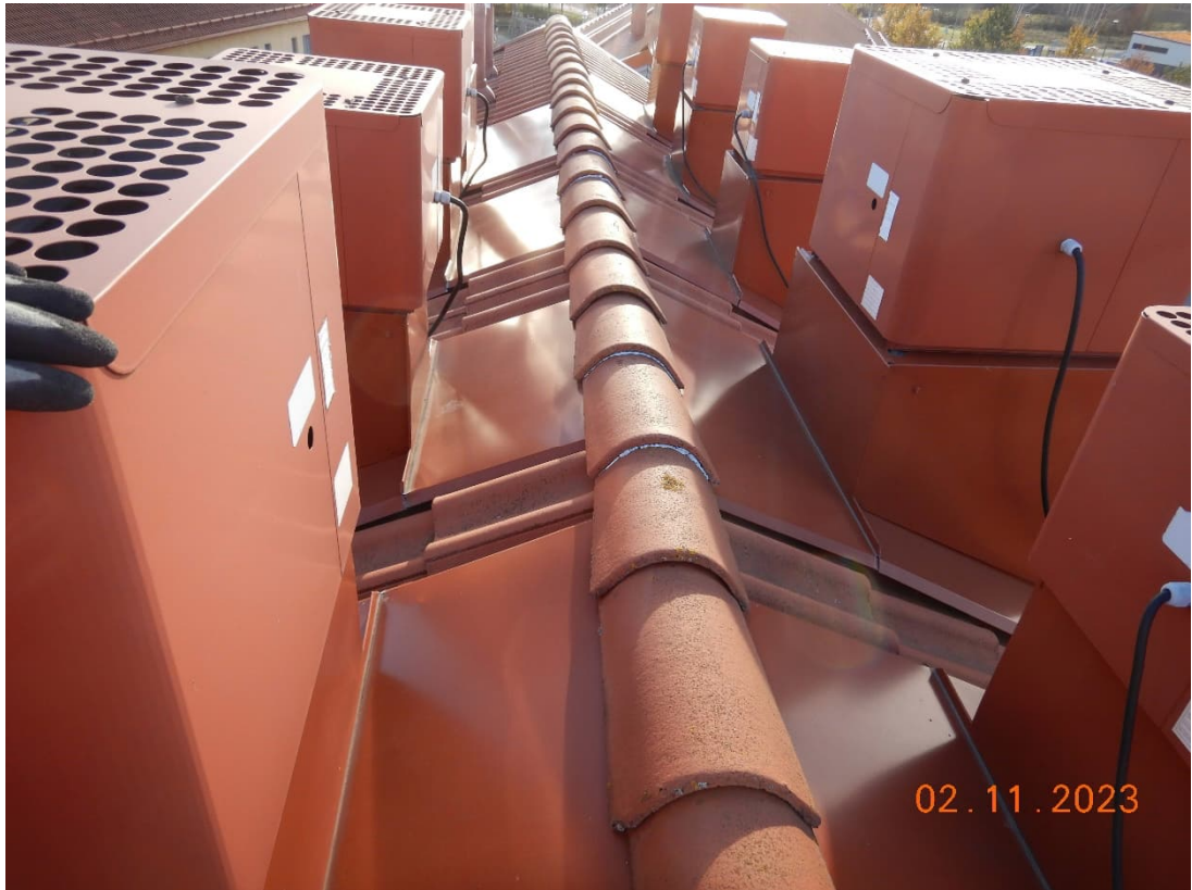
Kuva 98. H-osan vesikatolla on lähekkäin runsaasti huippuimureita ja läpivientejä. Toteutus vaikutta toimivalta, eikä puutteita havaittu. Harjatiiliä on tiivistetty valkoisella tiivistysmassalla.
