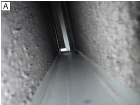
Kuva 118 a-b. Poistoilmapuolen äänenvaimentimet ovat yleisesti likaisia.
