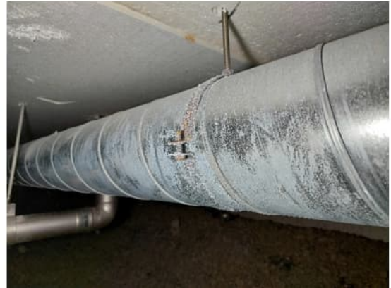
Kuva 24 a-b. Kuvat Solu C1 / Ruukki keittiön alta. Ryömintätilan ilmanvaihdon kanavan kannakointi on hapettunut.
