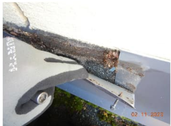
Kuva 100 a-b. [redacted] kermikaton seinällenostojen pellitykset eivät ole vesitiiviisti asennettu seinäpintaan. Pellityksen alla
