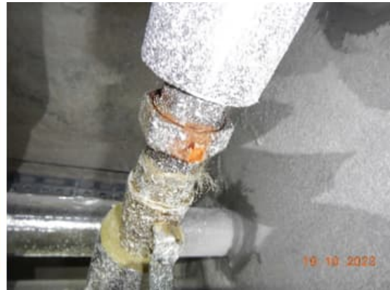
Kuva 57 a- b. Solun G1 Käytävällä 2062, E1 oven kohdalla on alakatossa vuotojälkiä. Vuotojälkien kohdalla vesiputkessa on vuotojälki. Vuoto ei ollut aktiivinen tarkasteluhetkellä.
