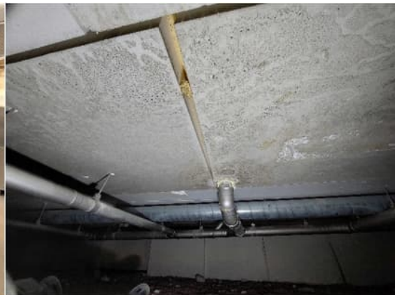
Kuva 25 a-b. Solu C1 / Ruukki, astianpesutilan 1084 lattiakaivo vuotaa ryömintätilaan. Tällä kohtaa ryömintätilassa EPS-levyjen alapintaan on muodostunut kasvustoa. Maassa oli kastumisen aiheuttamaa jälkeä.
