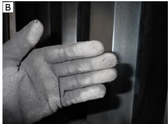
Kuva 118 a-b. Poistoilmapuolen äänenvaimentimet ovat yleisesti likaisia.
