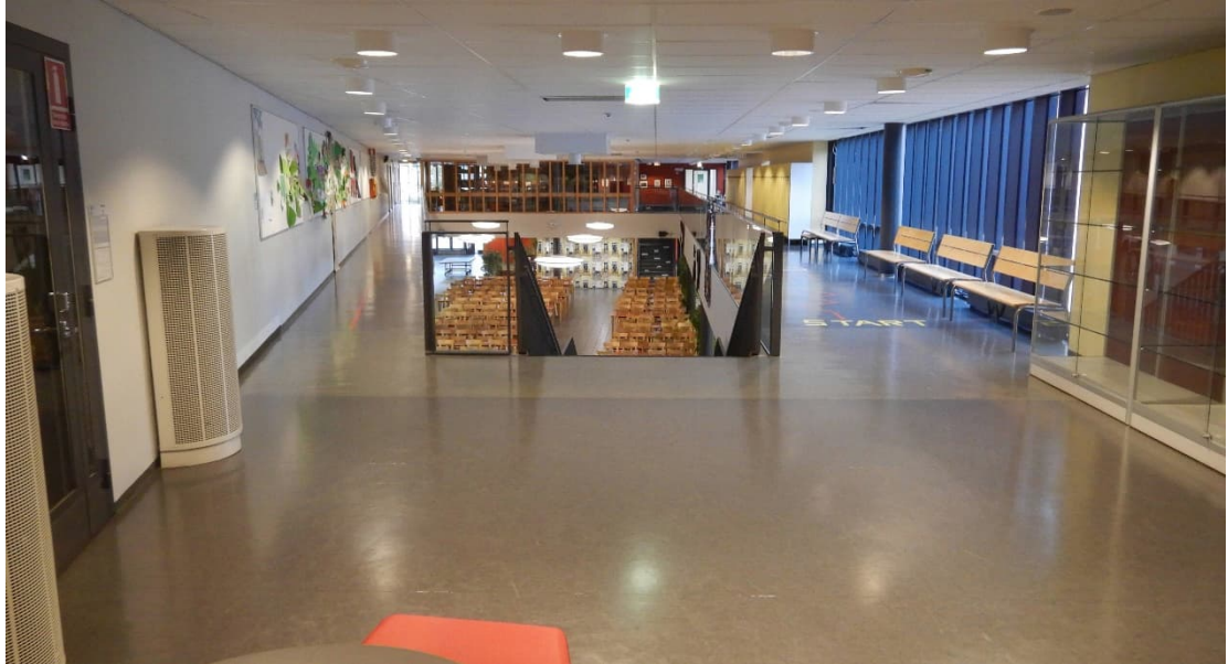
Kuva 41. Yleiskuva G2 aulan välipohjan linoleumimattopinnasta.
