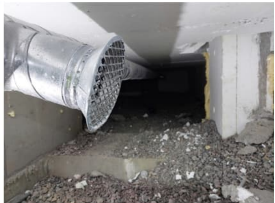
Kuva 19 a-b. Ryömintätilan ilmanvaihto on toteutettu rakennusosien päädyissä olevien poistoilmapäätelaitteiden sekä sokkelin vierustaa pitkin kulkevien tuloilmapäätelaitteiden avulla. Tarkastetulla alueella päätelaitteet toimivat ja ilmavirtaus oli oikeansuuntainen, ryömintätilasta kanavaan päin.
