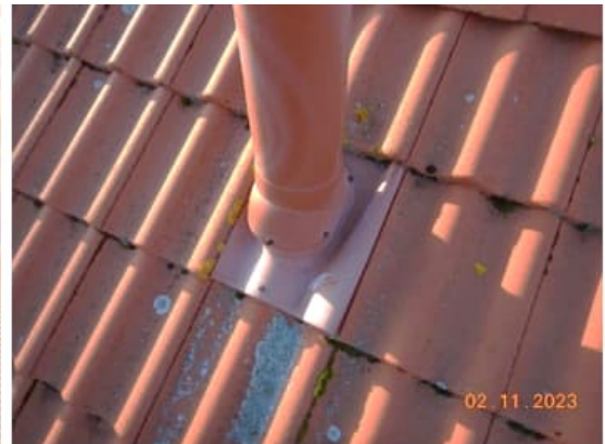
Kuva 97 a-b. Tarkastetuilta osin vesikatteen läpiviennit vaikuttivat hyvin tehdyiltä ja tarkoituksenmukaisilta. Huippuimurit on sijoitettu lähelle harjaa ja pellitys viety harjatiilen alle. Viemärintuuletusputkien ja yläpohjan alipainetuulettimien läpiviennit on tehty tiilikattoon soveltuvalla valmisläpivientikappaleella.
