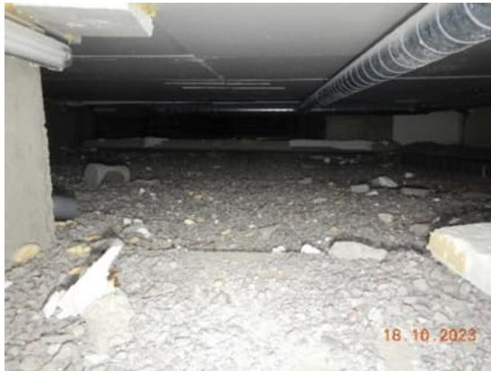
Kuva 18 a-b. Ryömintätila on tehtyjen havaintojen mukaan kokonaan yhtenäistä tilaa, eikä siinä ole erillisiä osastoiteja. Ryömintätilassa ilma oli kohtalaisen raikas, eikä irtovettä havaittu.
