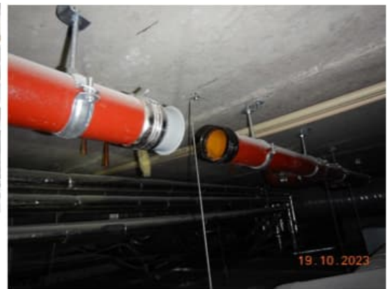
Kuva 58 a-b. Alakattojen sisällä havaittiin useassa paikassa käytöstä poistettuja viemäri- ja vesijohtoputkia. Osa putkista on tulpattu muovitulpilla ja osaa putkista ei ole tulpattu ollenkaan.
