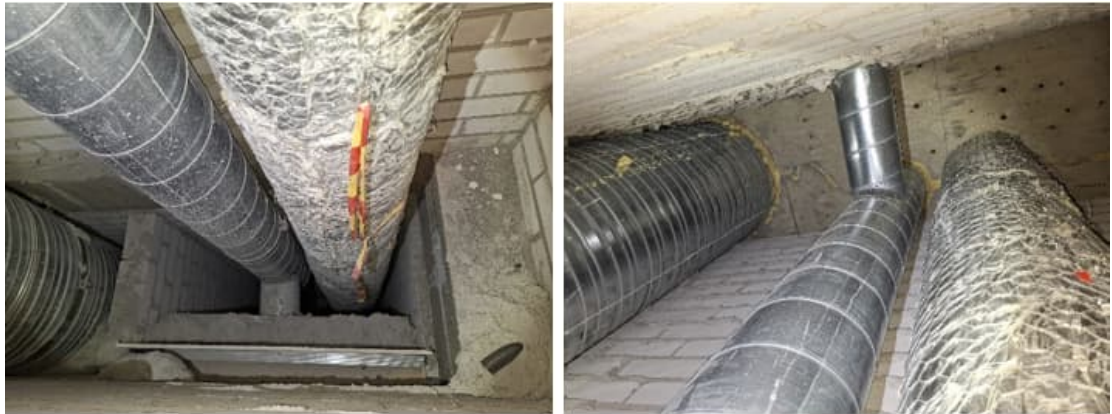
Kuva 86 a-b. D2 Kuitia, wc-tila 2077. Tarkastusluukusta katselmoitu hormi. Tekniikkakuilussa ei havaittu sinne kuulumatonta rakennusjätettä. Kuilun tasanteisiin on kertynyt rakennuspölyä.
