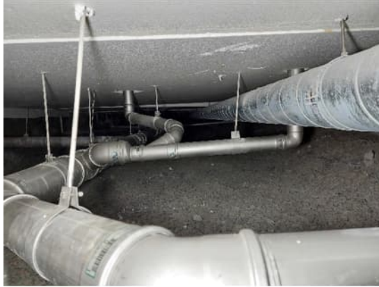
Kuva 24 a-b. Kuvat Solu C1 / Ruukki keittiön alta. Ryömintätilan ilmanvaihdon kanavan kannakointi on hapettunut.
