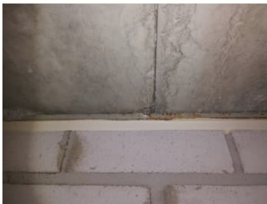
Kuva 89 a-d, Hissin 1134 ympärillä olevien tekniikkakuilujen liittymät alakattojen sisällä eivät ole ilmatiiviitä. Kuilun yläpäässä yläpohjan vastaisessa liittymässä on reilu yhden tiilen kokoinen aukko (kuva a, ympyröity punaisella). Myös muilta osin kuiluista on ilmayhteyksiä mm.
