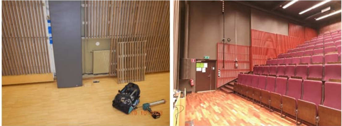
Kuva 62 a-b. Yleiskuvat auditorion ja liikuntasalin puuritiäpintaisista ulkoseinistä. Verhoilun takana on akustiikkalevy.
