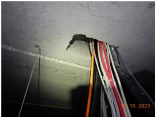
Kuva 110 a-b. IV-konehuoneiden puolella läpiviennit ovat tiiviitä vaikka alapuolelta tarkasteltuna ne vaikuttavat huonosti toteutetuilta. Läpivienteihin on laitettu valun alustaksi mm. mineraalivillaa sekä uretaanivaahtoa.
