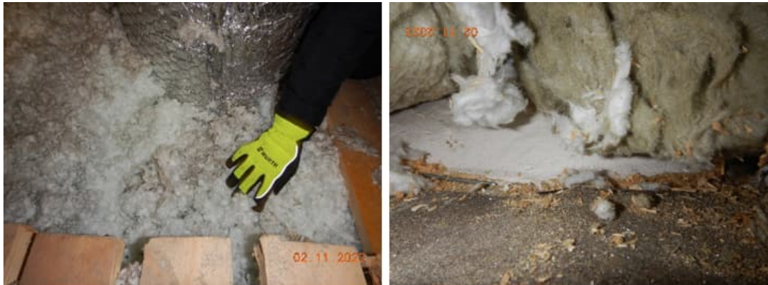
Kuva 108 a-b. Yläpohjan läpiviennin toteutus tarkastettiin eristeiden alta. IV-kanavan läpivienti yläpohjan läpi on valettu umpeen kipsitäytöllä.
