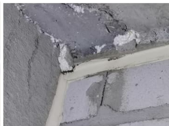
Kuva 88 a-b. F2 Karuna 2117, tekniikkakuiluun tehtiin rakenneporaus, jonka tarkastettiin kuilun sisäpuoli. Kuilussa ei havaittu sinne kuulumatonta jätettä. IV-kanavan läpivienti välipohjaan oli valettu.
