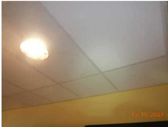
Kuva 57 a- b. Solun G1 Käytävällä 2062, E1 oven kohdalla on alakatossa vuotojälkiä. Vuotojälkien kohdalla vesiputkessa on vuotojälki. Vuoto ei ollut aktiivinen tarkasteluhetkellä.
