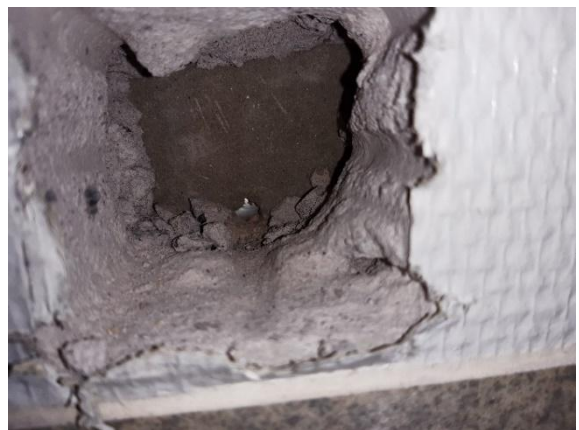
Kuva 43. RA-VS6. Keittiön ja vaatehuoltotilan väliseinä on kevytbetonirunkoinen.
