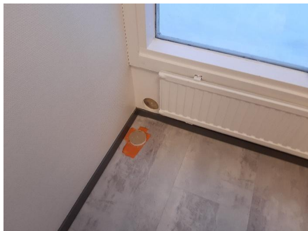
Kuva 1. Rakenneavaus tehtiin ulkoseinän alanurkkaan.
