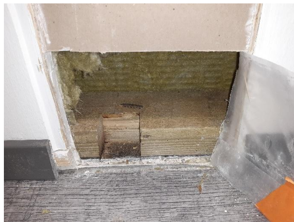
Kuva 2. Alasidepuun alapuolella on bitumikermi.
