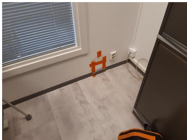
Kuva 1. Rakenneavaus tehtiin väliseinän alareunaan.
