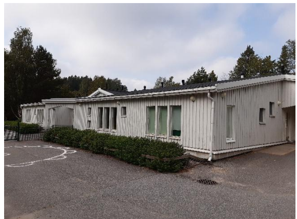
Kuva 18. Julkisivuna on maalattu pysty- laudoitus.
