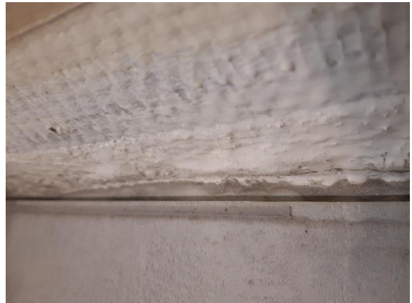
Kuva 15. Alapohjan ja ulkoseinän liitoskohta on tiivistetty liimamassalla.
