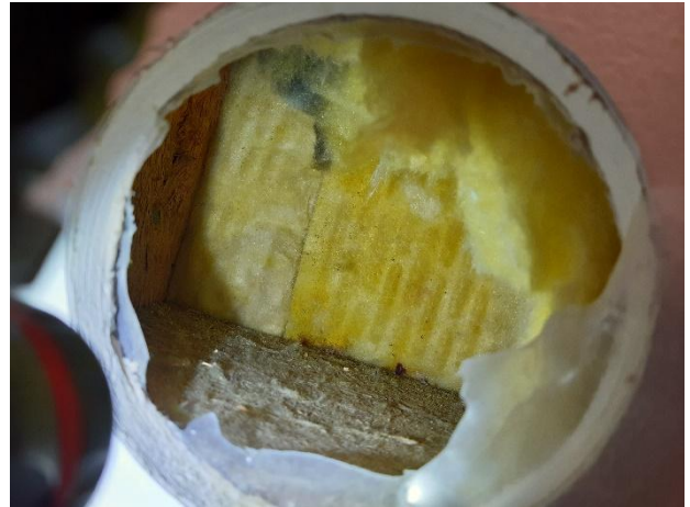
Kuva 4. Puurungossa ei havaittu kosteusjälkiä.
