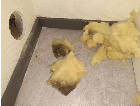
Kuva 29. RA-US7. Mineraalivilla on alareunasta tummentunutta.
