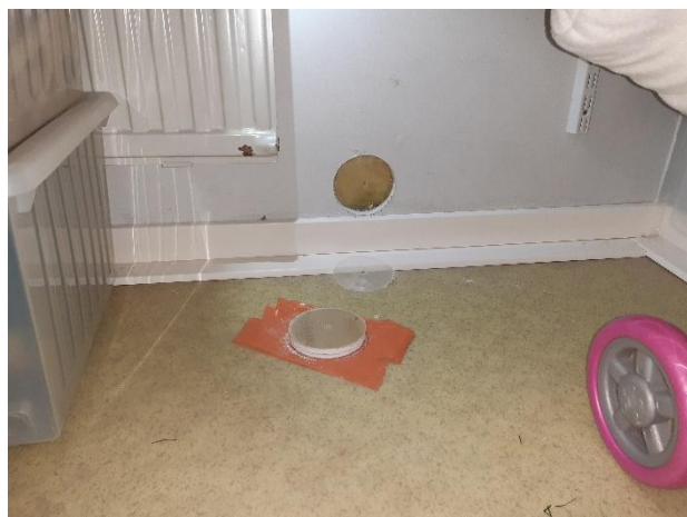
Kuva 1. Rakenneavaus tehtiin ulkoseinän alareunaan.
