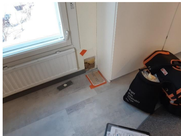
Kuva 1. Rakenneavaus tehtiin ulkoseinän alareunaan.
