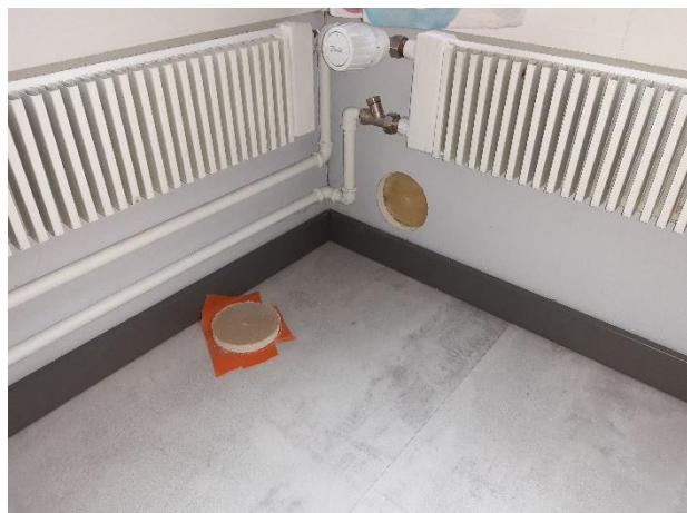
Kuva 1. Rakenneavaus tehtiin ulkoseinän alanurkkaan.
