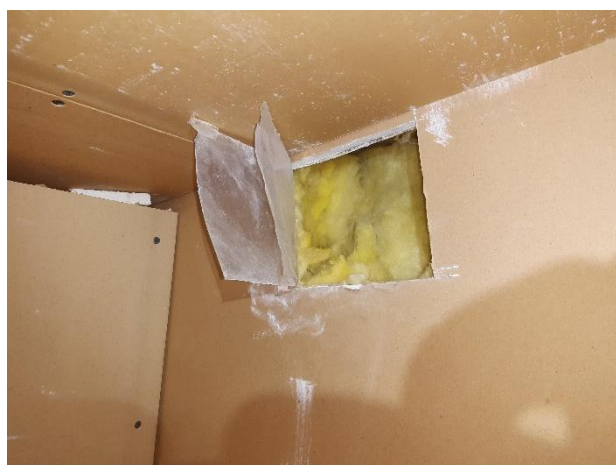
Kuva 1. Rakenneavaus tehtiin ulkoseinän yläreunaan.
