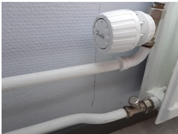
Kuva 17. Patterin takana pystyhal- keama.
