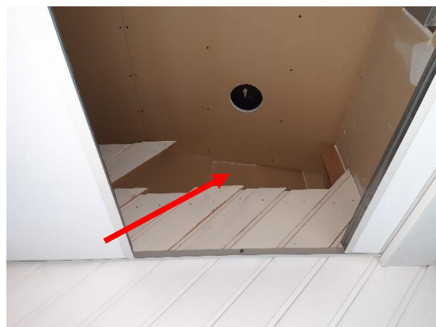
Kuva 1. Rakenneavaus tehtiin ulkoseinän yläreunaan, alakaton yläpuolelle.
