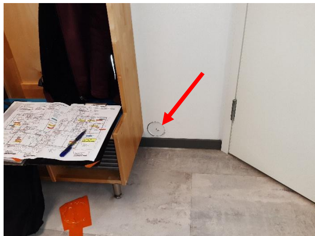
Kuva 1. Rakenneavaus tehtiin väliseinän alareunaan.
