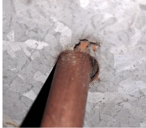
Kuva 2. Vaipan tiivistämättömät läpiviennit tulokoneessa muodostavat sisäilman kuitulähteen
