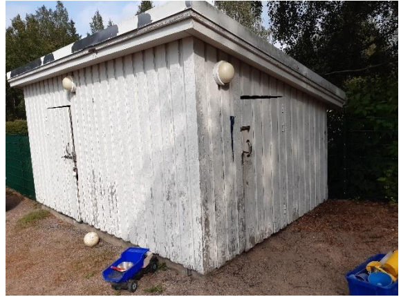
Kuva 73. Itäpuolen puurakenteinen varastorakennus.
