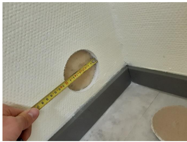
Kuva 2. Rakennetta tarkasteltiin Ø100 mm avauksen kautta.
