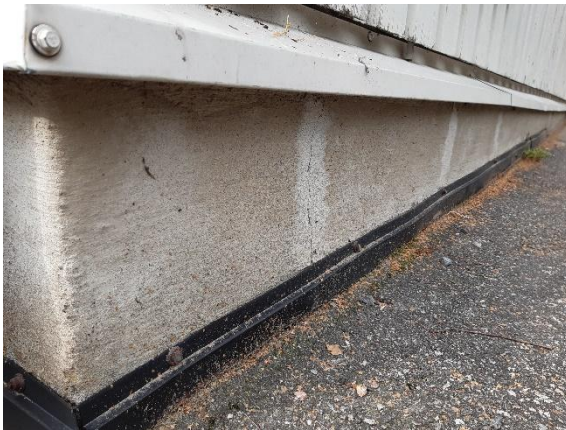
Kuva 19. Sokkelissa pystyhalkeamia.
