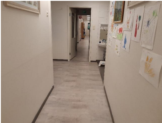
Kuva 8. Lattiapintoina on pääosin uusittu vinyylilankku.
