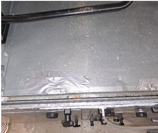
Kuva 3 Kammioita on tiivistetty teippaamalla sisä- ja ulkopuolelta
