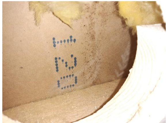
Kuva 49. RA-VS13. Mikrobikasvustoa kipsilevyn pinnassa.
