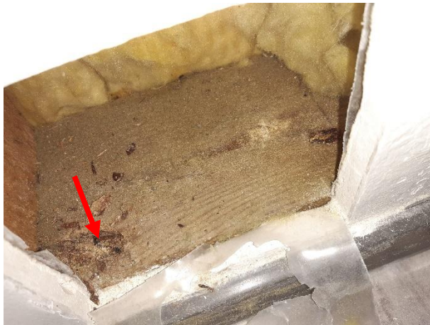
Kuva 5. Alasidepuun reunassa oksakohta, jota koestettiin puukolla.
