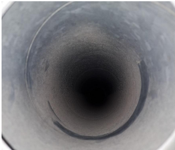
Kuva 81. Ryhmähuone 37 poistokanavan pölykertymä on alle 1,4 \text{ g/m}^2
