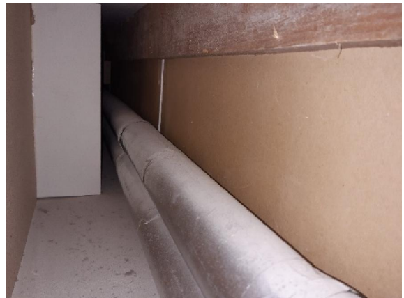
Kuva 26. RA-US2. Verhokoteloissa havaittiin pölyä, mutta ei merkittäviä puutteita.
