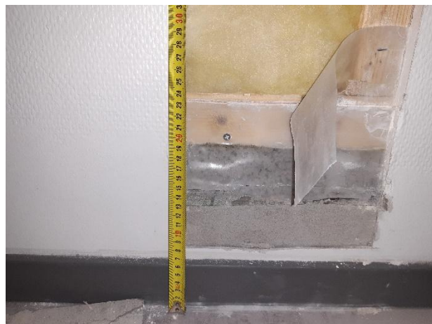
Kuva 2. Väliseinän alareunassa kevytsoraharkko, joka ulottuu n. 200 mm korkeudelle alapohjan yläpinnasta.
