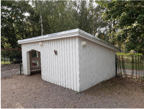
Kuva 72. Länsipuolen puurakenteinen varastorakennus.
