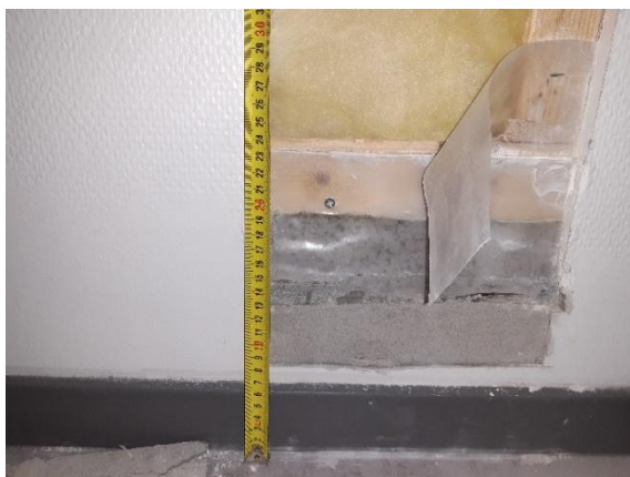
Kuva 44. RA-VS4. Väliseinän alareunassa kevytsoraharkko.
