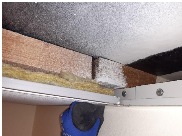
Kuva 1. Rakenneavaus tehtiin ulkoseinän läheisyyteen.
