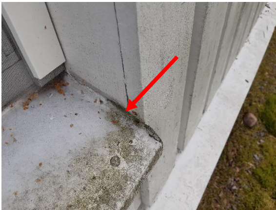
Kuva 37. Vesipellin liitos tiivistetty liimatiivistemassalla.
