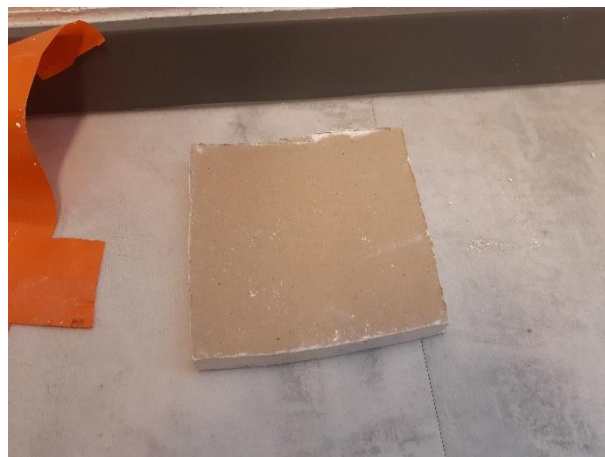
Kuva 2. Kipsilevyn ulkopinnassa ei havaittu kosteusjälkiä tai viitteitä mikrobikasvustoa.
