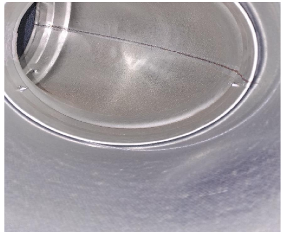
Kuva 80. Päiväkodin tulokanavassa pölykertymä on alle 0,4 \text{ g/m}^2 .
