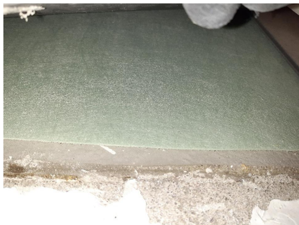
Kuva 3. Vinyylilankun alapuolella solumuovi.
