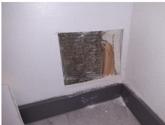
Kuva 42. RA-VS2. Mineraalivilla on muita avauksia tummempaa, kuin muissa avauksissa havaittu mineraalivilla.
