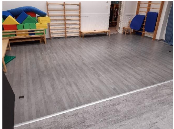
Kuva 9. Liikuntasalin lattiapäällysteenä lankkukuvioinen muovimatto.
