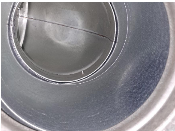
Kuva 79. Päiväkodin tulokanavassa pölykertymä on alle 0,4 \text{ g/m}^2
