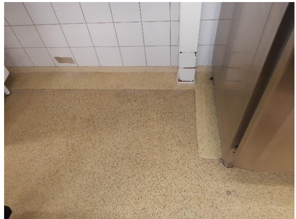
Kuva 13. Keittiön lattiaa on uusittu väli-seinän läheisyydessä.
