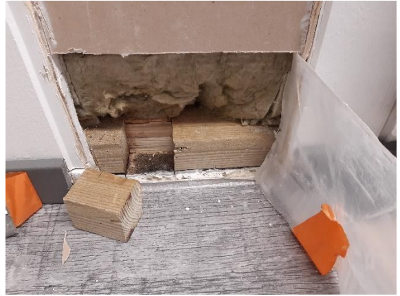
Kuva 30. RA-US12. Alasidepuun alapuolella on bitumikermikaista.
