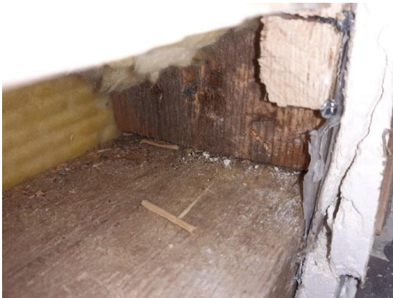
Kuva 31. RA-US13. Pystyrunko ja alasidepuu ovat muihin rakenneavauksiin verrattuna tummempia.
