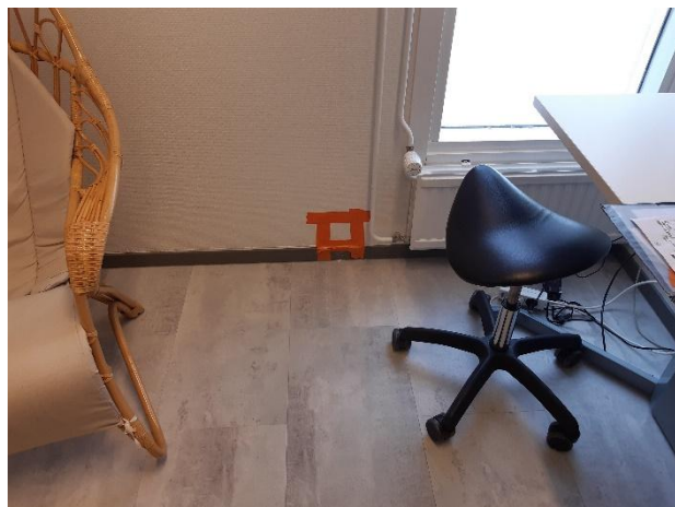
Kuva 1. Rakenneavaus tehtiin ulkoseinän reunaan, ikkunan alapuolelle.
