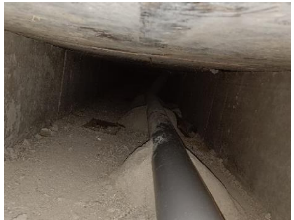
Kuva 16 Kanaalin betonirakenteinen kansi on valettu filmivanereiden varaan. Viemärit on tuettu valubetonien varaan.
