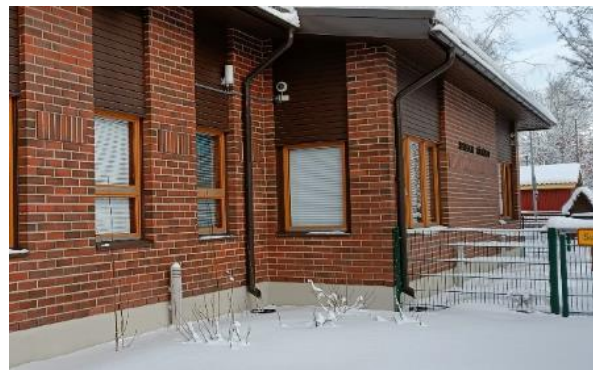
Kuva 37 Uusitut syöksytorvet ohjaavat sadevedet rännikaivoihin.
