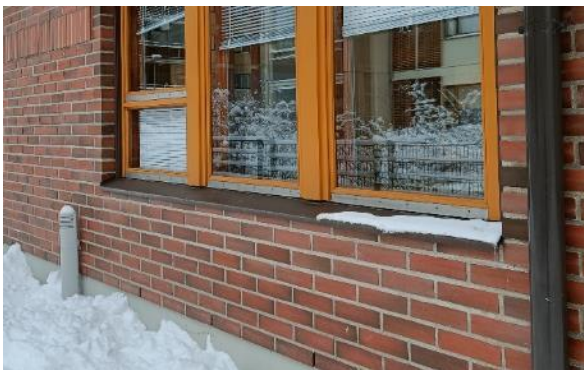
Kuva 36 Uusitut ikkunapellit on asennettu asianmukaisesti.
