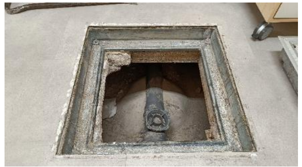
Kuva 12 Putkikanaalin tarkastusluukku avattuna tilassa 23.
