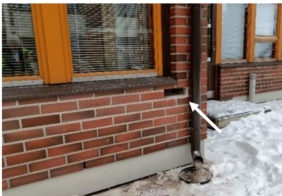
Kuva 42 Avaus 2 tehtiin tilan 43 ikkunan alapuolelle, ulkoseinän kulmaukseen. Avaus tehtiin 800...900 mm korkeudelle maanpinnan tasosta.
