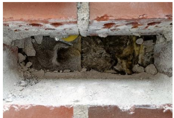
Kuva 43 Avaus 2. Tuulensuojavillaa.
