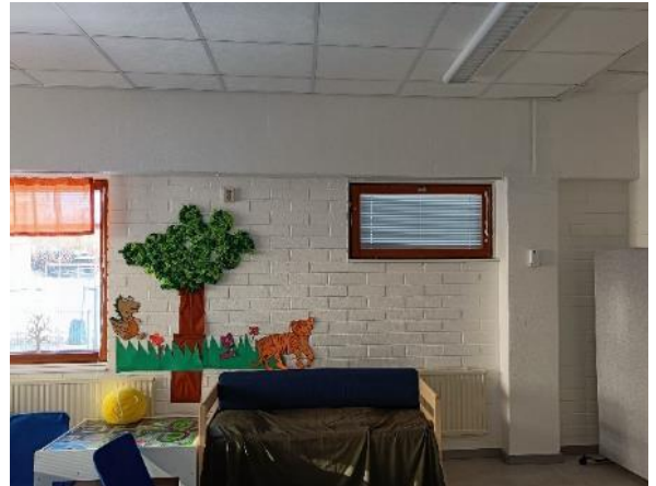
Kuva 5 Yleiskuva sisätilasta. Kuvassa on tiili-villa-tiili -rakenteinen päätyulkoseinä ja teräsbetonirakenteinen pilari ja palkit.
