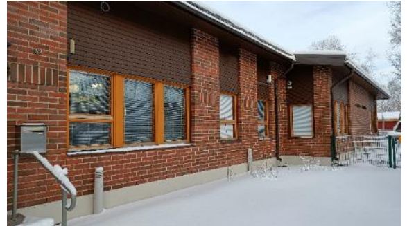
Kuva 10 Tuuletuspaaluja on arviolta 5 metrin välein.
