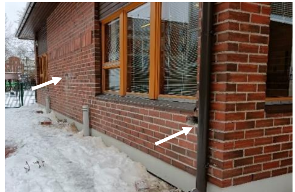
Kuva 41 Avaukset 2 ja 3 tilojen 43 ja 44 kohdille. Avaus 2 tehtiin rakennuksen kulmaan, ikkunan alapuolelle.
