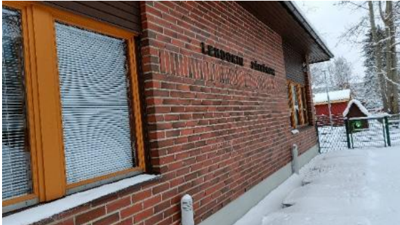
Kuva 9 Alapohjan alustatilan tuuletus on toteutettu tuuletuspaalujen kautta.
