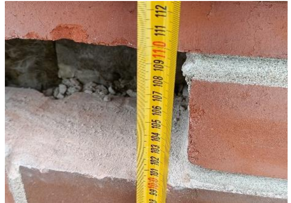
Kuva 39 Avaus 1 tehtiin 1000...1100 mm korkeudelle maanpinnan tasosta. Näyte N1 otettiin avauksen yläosasta mineraalivillasta.
