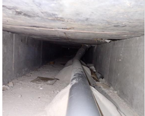
Kuva 19. Nykytilanne, suuremmat rakennusjätteet on poistettu, mutta pohjalla on edelleen hienoa ja isompaa rakennusjätettä. Muottivaneri on edelleen kanaalissa, vain sahatavarasta valmistetut valutuet on poistettu.
