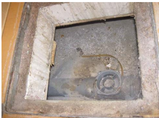
Kuva 16. Kuva 3. Optiplanin 31.3.2015, päiväystä lausunnosta. Lattia luukun kaulus on vaihdettu, ja osa rakennusjätteestä on poistettu
