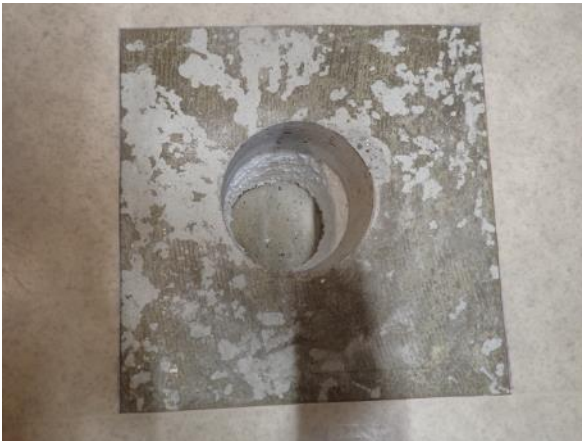
Havainnekuva rakenneavauksesta. Materiaalinäyte MA.08-AP otettiin rakenneavauksen vieressä olevan EPS-levyn alapinnasta irtileikatuista näytepaloista.
