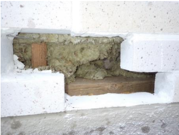
Havainnekuva rakenneavauksesta sen jälkeen, kun rakenneavauskohta oli puhdistettu lehmuksen siemenistä ja mineraalivillasilppusta.
