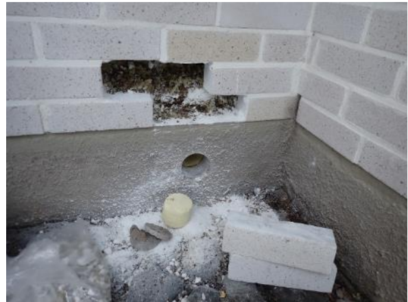
Yleiskuva rakenneavauksesta. Kuvassa myös sokkelin rakenneavaus RA.17-SO.
