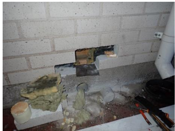
Yleiskuva rakenneavauksesta. Kuvassa myös ulkoseinän rakenneavaus RA.06-US.
