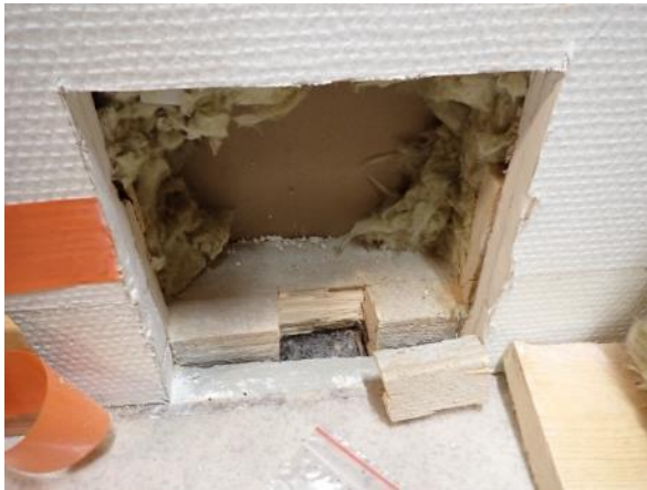
Havainnekuva rakenneavauksesta.
