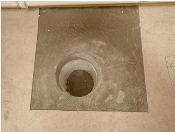
Havainnekuva rakenneavauksesta. Materiaalinäyte MA.09-AP otettiin EPS-levystä irti poratun näytekappaleen alapinnasta.
