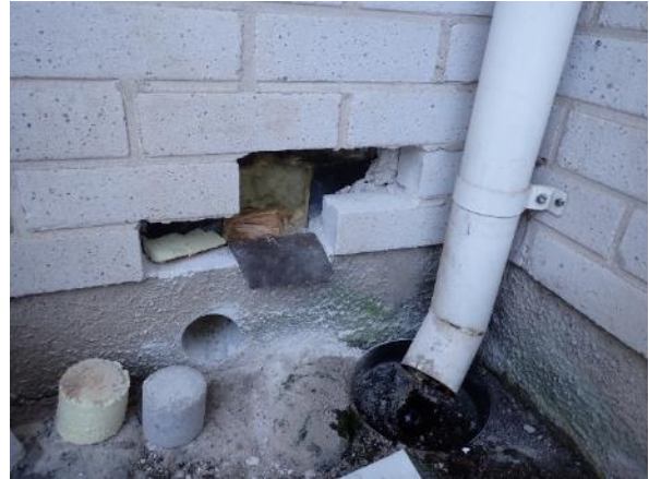
Yleiskuva rakenneavauksesta. Kuvassa myös sokkelin rakenneavaus RA.07-SO.
