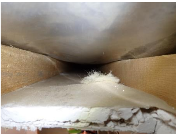
Valokuvaamalla koolauksen välistä tehdyissä tarkasteluissa ei kipsilevyn yläpinnassa havaittu viitteitä kosteus- tai mikrobivaurioista.
