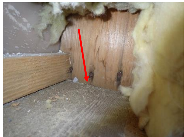
Materiaalinäyte MA.24-US otettiin pystytolpan ja alaohjauspuun kulmasta (punainen nuoli) .
