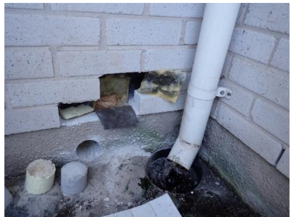
Yleiskuva rakenneavauksesta. Kuvassa myös ulkoseinän rakenneavaus RA.08-US.
