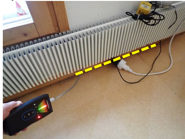
5. Alapohjan ja ulkoseinän liittymästä todettiin vähäistä rakomaista ilmavuotoa.
