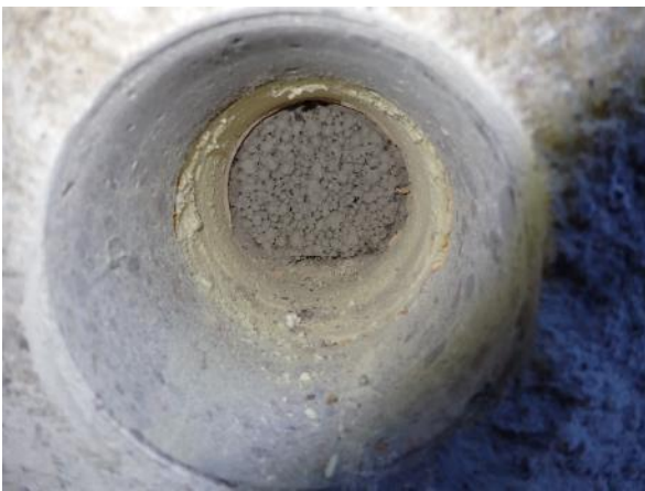
Havainnekuva rakenneavauksesta. Materiaalinäyte MA.16-US otettiin polyuretaanilevystä irti poratun näytekappaleen sisäpinnan kartonkilaaminaatista.
