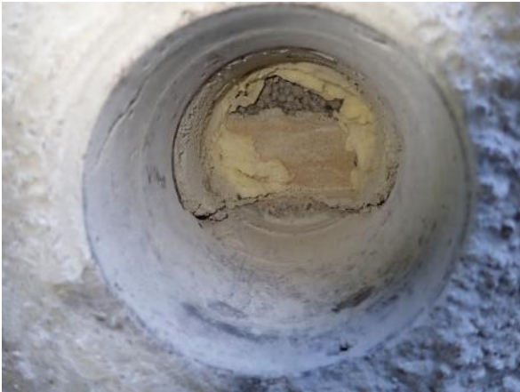
Havainnekuva rakenneavauksesta. Rakenneavauksen kohdalla sokkelihalkaisua ei ole ulotettu ontelolaatan yläpinnan alapuolelle.
