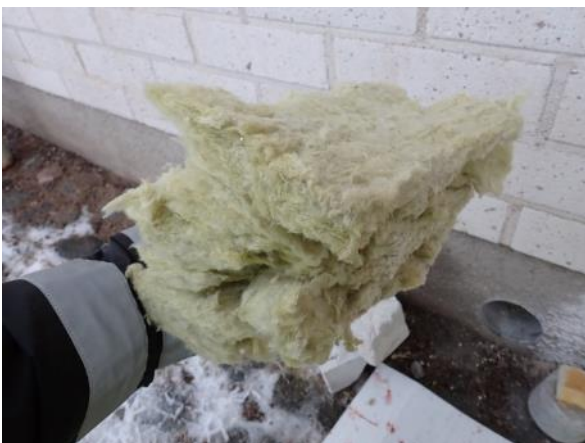
Lämmöneristeenä käytetyssä mineraalivillalevyssä ei ollut huomattavaa ilmavuotoihin viittaavaa pölykertymää.
