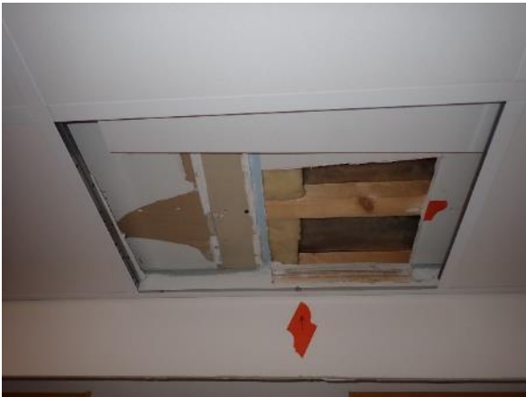
Havainnekuva rakenneavauksesta. Vanhan väliseinäliittymän kohdalla koolauksen väliin oli asennettu mineraalivillalakaista.
