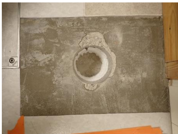
Havainnekuva rakenneavauksesta. Materiaalinäyte MA.07-AP otettiin rakenneavauksen vieressä olevan EPS-levyn alapinnasta irtileikatuista näytepaloista.
