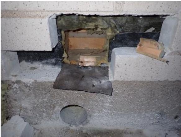
Havainnekuva rakenneavauksesta. Kuvassa myös sokkelin rakenneavaus RA.05-SO.
