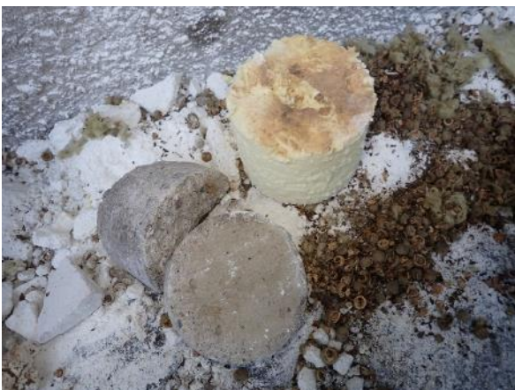
Kuvassa sokkelin sisäpinta ja sokkelihalkaisun ulkopinta. Sokkelihalkaisun ulkopinnassa oleva kartonki oli hankautunut irti rakenneavauksen yhteydessä eikä ollut tarkasteltavissa.
