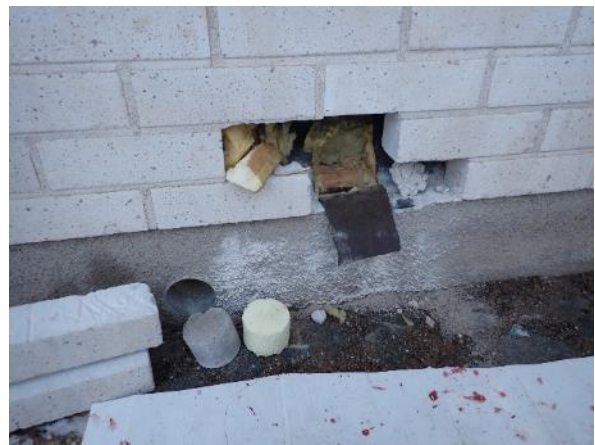
Yleiskuva rakenneavauksesta. Kuvassa myös ulkoseinän rakenneavaus RA.10-US.
