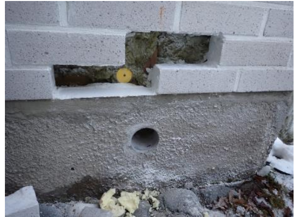
Yleiskuva rakenneavauksesta, jonka alareuna oli noin 0,2 m maanpinnan tasosta. Kuvassa myös ulkoseinän rakenneavaus RA.12-US.
