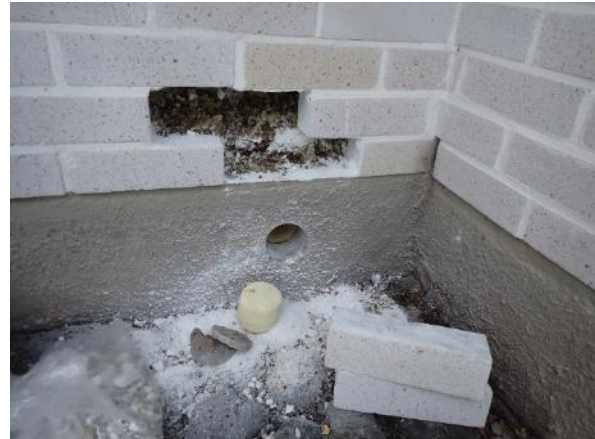
Yleiskuva rakenneavauksesta, jonka alareuna oli noin 0,1 m maanpinnan tasosta. Kuvassa myös ulkoseinän rakenneavaus RA.18-US.
