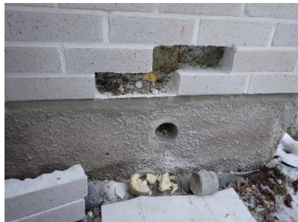
Yleiskuva rakenneavauksesta. Kuvassa myös sokkelin rakenneavaus RA.11-SO.
