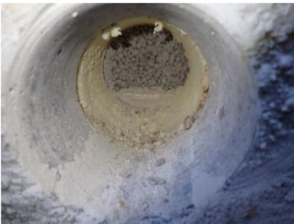
Havainnekuva rakenneavauksesta. Materiaalinäyte MA.19-US otettiin polyuretaanilevystä irti poratun näytekappaleen sisäpinnan kartonkilaaminaatista.
