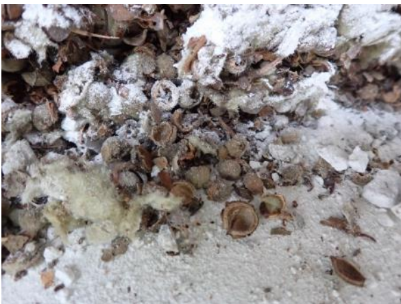
Rakenneavauksen kohdalla ilmaraossa oli runsaasti lehmäsiemeniä
