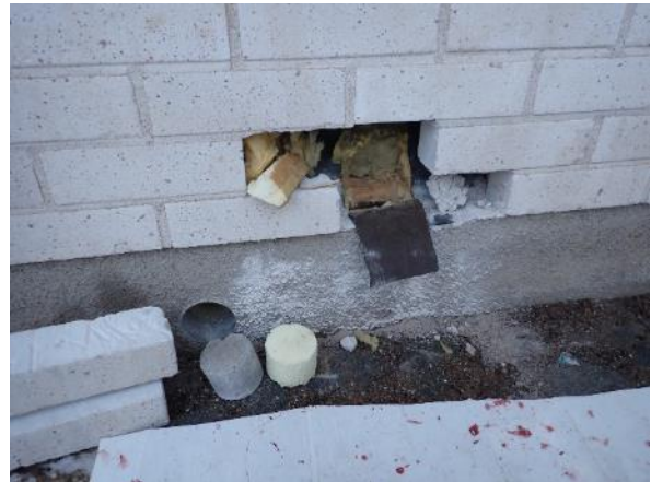
Yleiskuva rakenneavauksesta. Kuvassa myös sokkelin rakenneavaus RA.07-SO.
