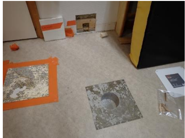
Yleiskuva rakenneavauksesta. Kuvassa etualalla alalohjan lisäksi rakenneavaus RA.02-AP.
