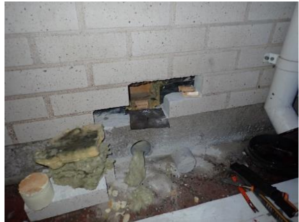
Yleiskuva rakenneavauksesta. Kuvassa myös sokkelin rakenneavaus RA.05-SO.
