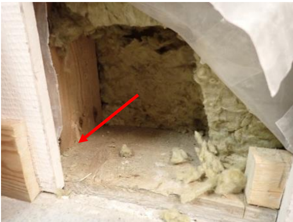
Havainnekuva rakenneavauksesta. Materiaalinäyte MA.27-US otettiin kuvassa näkyvän pystytolpan (punainen nuoli) vierestä.
