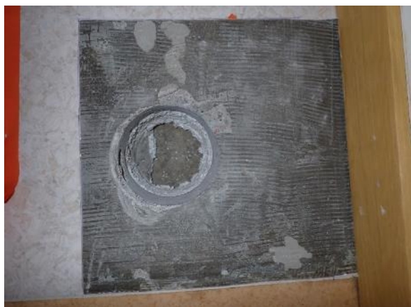
Havainnekuva rakenneavauksesta. Materiaalinäyte MA.10-AP otettiin rakenneavauksen vieressä olevan EPS-levyn alapinnasta irtileikatuista näytepaloista.
