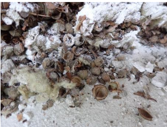
Rakenneavauksen kohdalla oli runsaasti lehmuksen siemeniä
