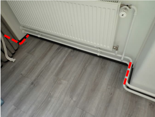
1. Alapohjan ja pilarin liittymästä sekä väliseinäliittymästä todettiin merkittävää ilmavuotoa normaaleissa käyttöolosuhteissa ja alipaineistettuna.
