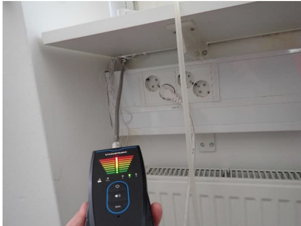
1. Koteloidun pilarin ja ulkoseinän liittymästä todettiin merkittävää rakomaista ilmavuotoa normaaleissa käyttöolosuhteissa. Alipaineistettuna vuotokohta laajeni.
