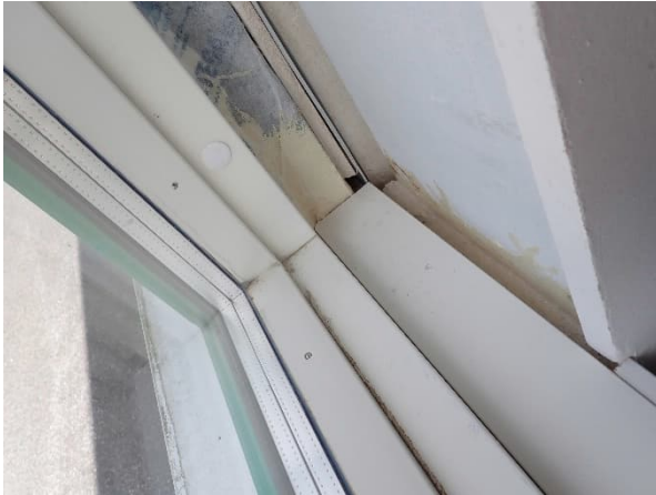
1. Koteloidun pilarin liittymä on paikoin tiivistetty ulkoseinälinjan puolella. Betonipilarin ja alapohjan välisestä tiivistyksestä ei ole tietoa.
