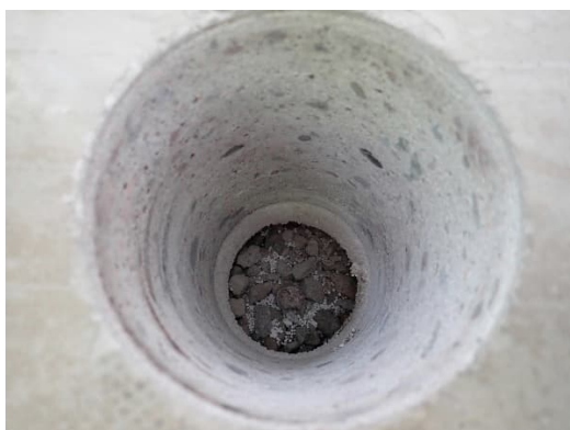
Kuva 5.3. Rakenneavaus RA.01-AP opetustilassa 1034–1036.
