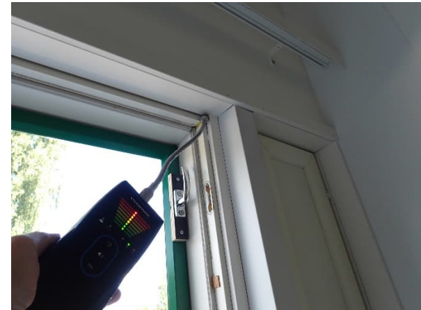
6. Yksittäisistä karmiliittymästä todettiin merkittävää pistemäistä vuotoa, kun kaasu syötettiin ulkoseinän yläosaan ja tila oli alipaineistettu.
