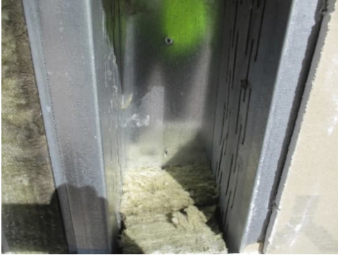
Kuva 6.2. Rakenneavaus RA.01-US opetustilan 1009 kohdalla. Avaus tehtiin julkisivun puolelta.
