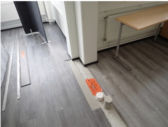
Rakenneavaus suoritettiin vanhan väliseinän kohdalle tilojen 1034 ja 1036 rajalla.
