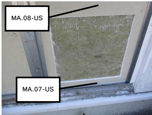
Kuva rakenneavauksesta RA.04-US.
