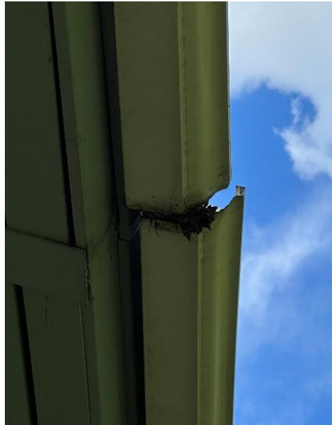
Kuva 6 a...d. Räystäskourut ovat paikoin irronneet toisistaan.
