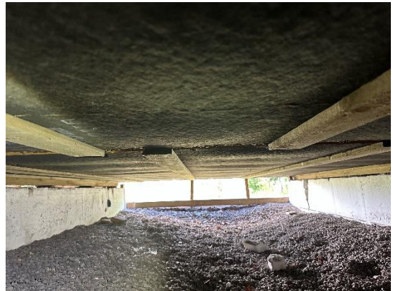
Kuva 9 a ja b. Yleiskuvia ryömintätilasta. Täyttönä on sepeli ja alapohjan alapinnassa tuulensuojalevy ja sen kannatinlaudat. Perustuspalkkeissa on myös paikoin varausreikiä.
