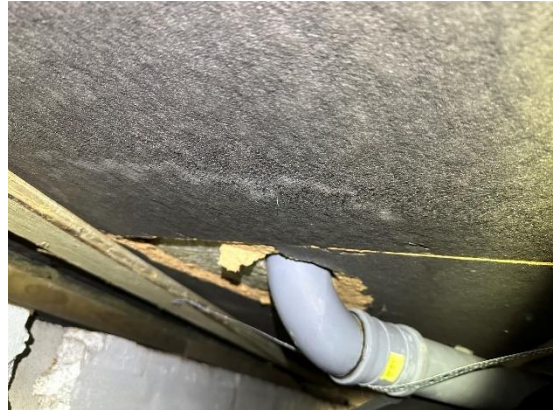
Kuva 12 a ja b. Lämminvesivaraajan vuotokohdan alueella tuulensuojalevyssä on kosteusjälkeä.
