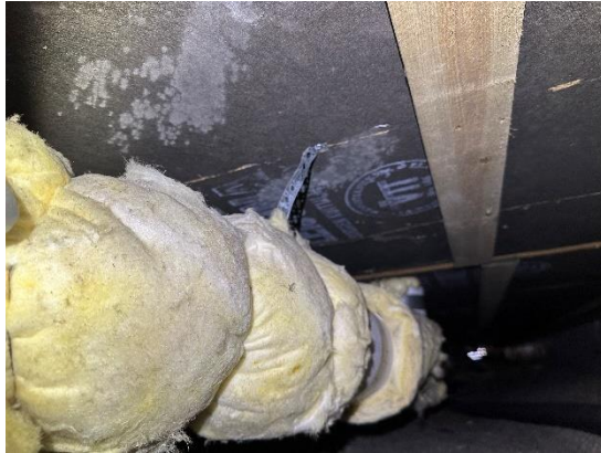
Kuva 12 a ja b. Lämminvesivaraajan vuotokohdan alueella tuulensuojalevyssä on kosteusjälkeä.
