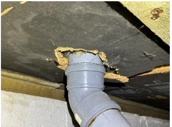
Kuva 13 a ja b. Tiedossa olevien vuotokohtien lisäksi havaittiin vesivuotojälkeä tilan 07 pesualtaan kohdalla.
