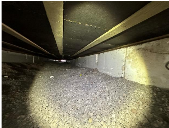
Kuva 9 a ja b. Yleiskuvia ryömintätilasta. Täyttönä on sepeli ja alapohjan alapinnassa tuulensuojalevy ja sen kannatinlaudat. Perustuspalkkeissa on myös paikoin varausreikiä.
