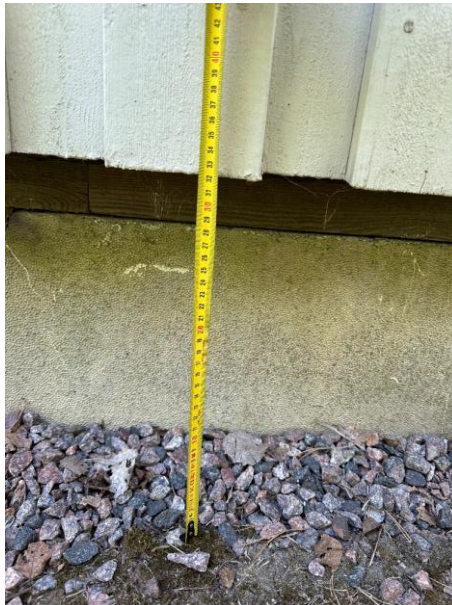
Kuva 5 a ja b. Sokkelikorkeus rakennuksen ympärillä on keskimäärin 25...30 cm. Sokkelipalkin ja tilaelementin välissä on painekyllästetty puu, jonka päälle tilaelementit on asennettu.
