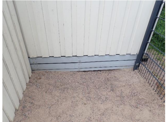
Kuva 8 a ja b. Perustuspalkit jakavat ryömintätilan kolmeen eri lohkoon, jotka tuulettuvat molemmista päistään. Päädyt on suojattu laudoituksella, jotka avattiin ryömintätilan tarkastusta varten.
