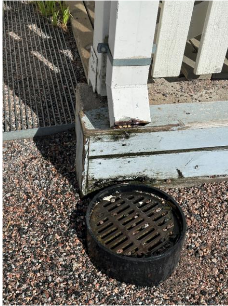
Kuva 4 a ja b. Sadevesien ohjaus toimii tyydyttävästi, mutta paikoin syöksytorvi on korkealla ja kastelee rakenteita. Rännikaivoissa on melko paljon soraa tai sinne kuulumatonta roskaa.
