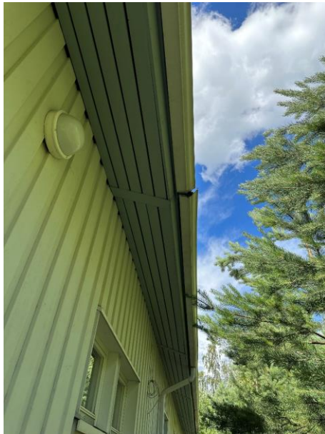
Kuva 6 a...d. Räystäskourut ovat paikoin irronneet toisistaan.
