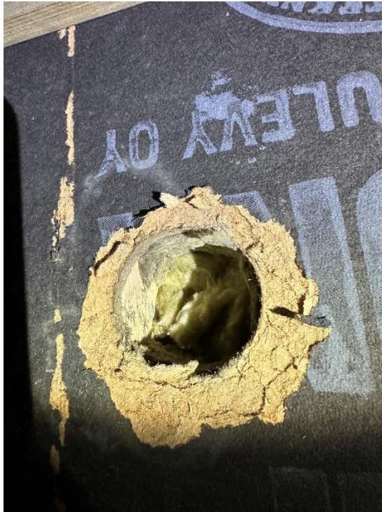
Kuva 10 a ja b. Tuulensuojalevyissä on yksittäisiä reikiä entisistä läpivienneistä tai varauksista. Suurempi reikä on sisäänkäynnin puolelta lukien toisessa palkkivälissä ja pienempi ensimmäisessä palkkivälissä lähellä vesipostin vuotokohtaa. Samassa kohdassa on myös vuotojälkeä.
