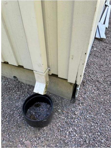
Kuva 4 a ja b. Sadevesien ohjaus toimii tyydyttävästi, mutta paikoin syöksytorvi on korkealla ja kastelee rakenteita. Rännikaivoissa on melko paljon soraa tai sinne kuulumatonta roskaa.
