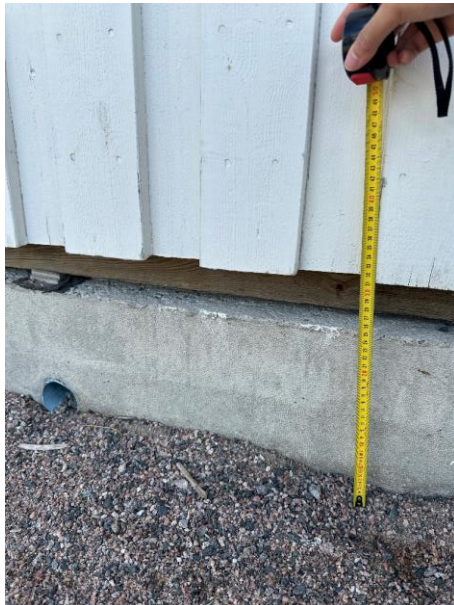
Kuva 5 a ja b. Sokkelikorkeus rakennuksen ympärillä on keskimäärin 25...30 cm. Sokkelipalkin ja tilaelementin välissä on painekyllästetty puu, jonka päälle tilaelementit on asennettu.
