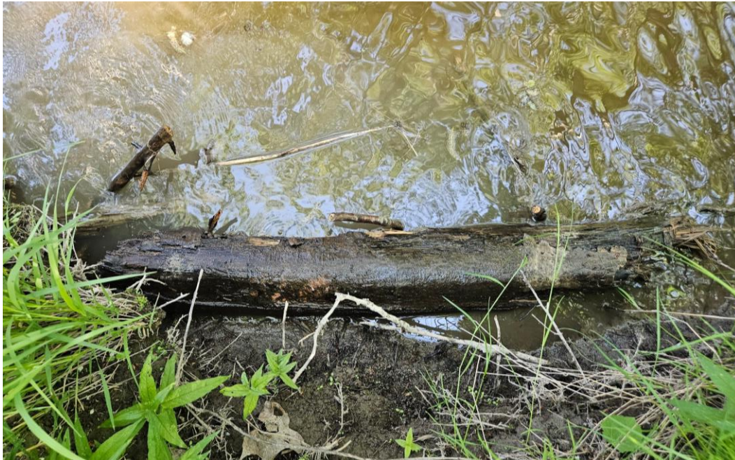
Kuva 9. Puron penkkaan kiilattua rydöstä purettua puumateriaalia (Honkanen, 2024).
