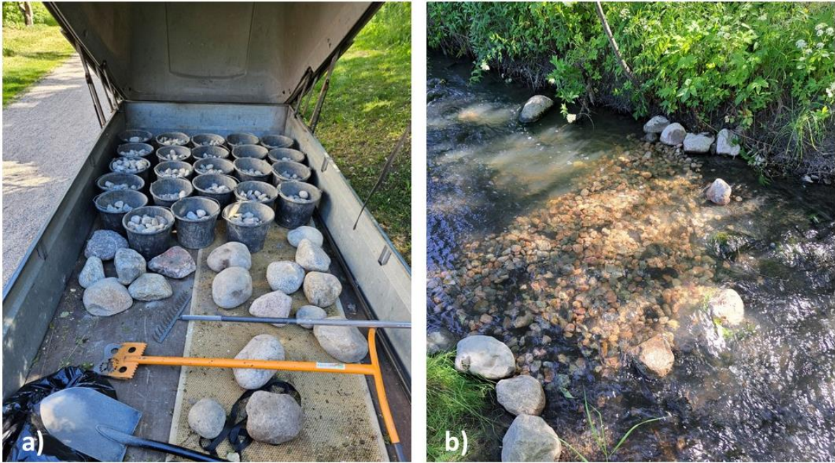
Kuva 6. a) Soraikon kunnostukseen tarvittavat välineet ja materiaalit (Honkanen, 2024). b) Valmis soraikko Pky33. Soraikkoon tuotiin uutta soraa ja poikaskiviä. Osa kivistä aseteltiin estämään soraikon leviämistä ja puron reunojen eroosiota (Lahin, 2024).
