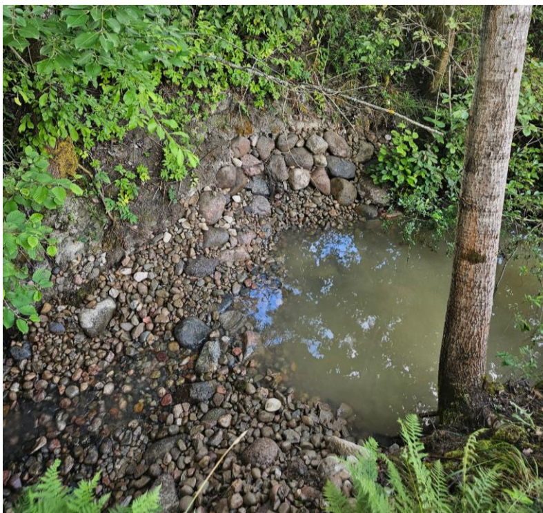
Kuva 5. Kiviä ja soraä aseteltiin puron reunoille suojaamaan penkkää eroosiolta (Honkanen, 2024).
