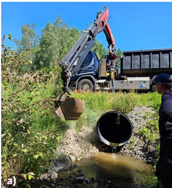
Kuva 4. a) Saapuva sorakuorma. b) Purouomaa porrastettiin soran ja kivien avulla (Honkanen, 2024).
