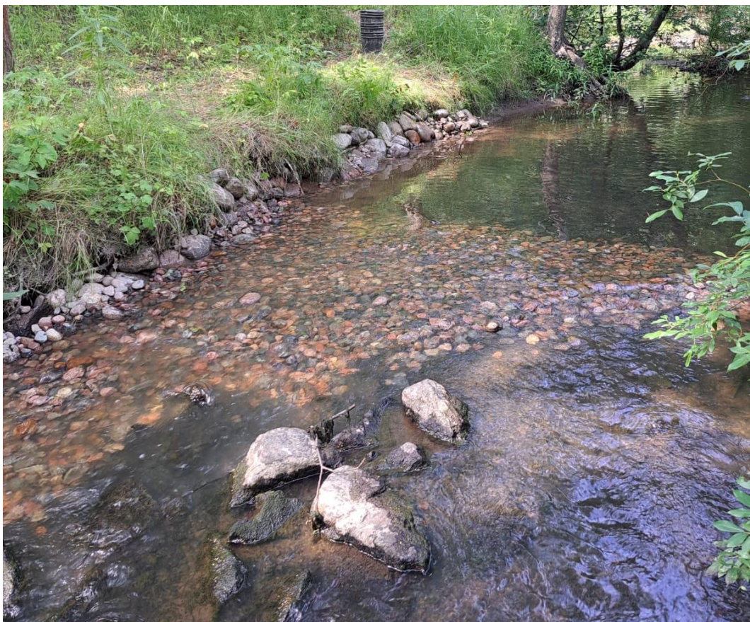
Kuva 20. Rekolanojalle talkoissa rakennettu soraikko Pre02a ja reunan eroosiosuojaus (Lahin, 2024).
