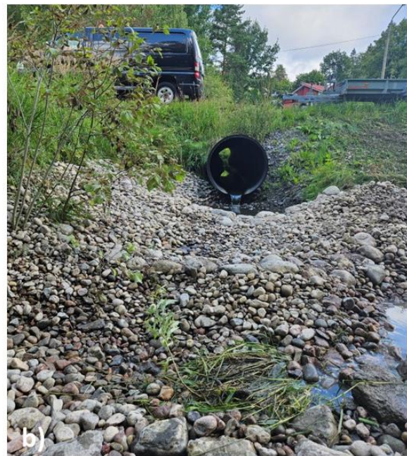
Kuva 4. a) Saapuva sorakuorma. b) Purouomaa porrastettiin soran ja kivien avulla (Honkanen, 2024).
