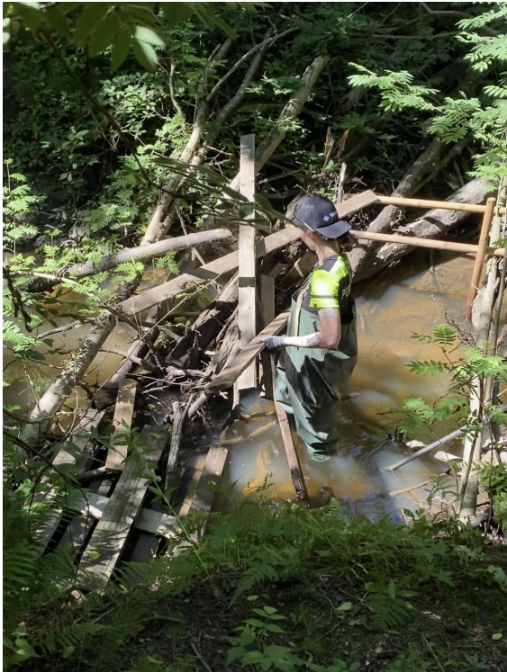
Kuva 5. Siltarakennelma Maitikkapuistossa Kylmäojalla
