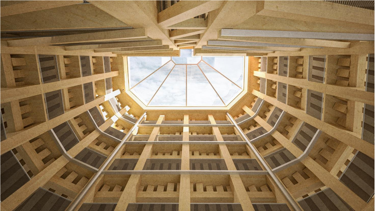
Kuva 4: Näkymä Vantaan Puu-Kivistön hallin valo-/savunpoistokuilusta
