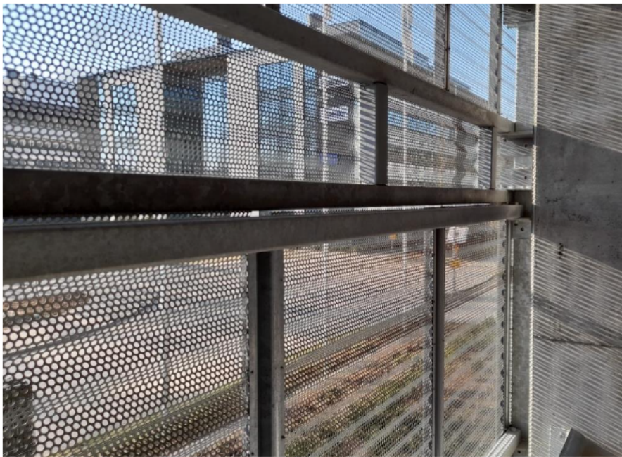
Kuva 2. Ramboll Villagen pysäköintitalon julkisivun pintana on käytetty rei'itettyä teräsohutelevyä.
