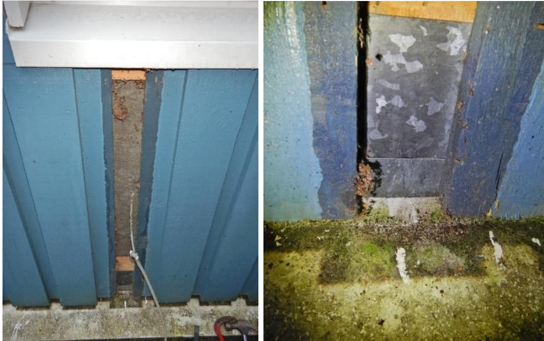
Kuva 41. Lastulevyseinän RA4b samaan kohtaan kuin RA4a sisältä. Rakenteen alaosassa näkyy sokkelin suojapelti ja sen ylösnosto, jonka takana on n. 20 cm korkeudelle ulottuva toinen pelti. Julkisivuverhouksen takana tuuletusväli ja tuulensuojavillan ulkopinta. Julkisivulaudoituksen alaosassa hieman kosteusjälkiä, puuosat muutoin ok.
