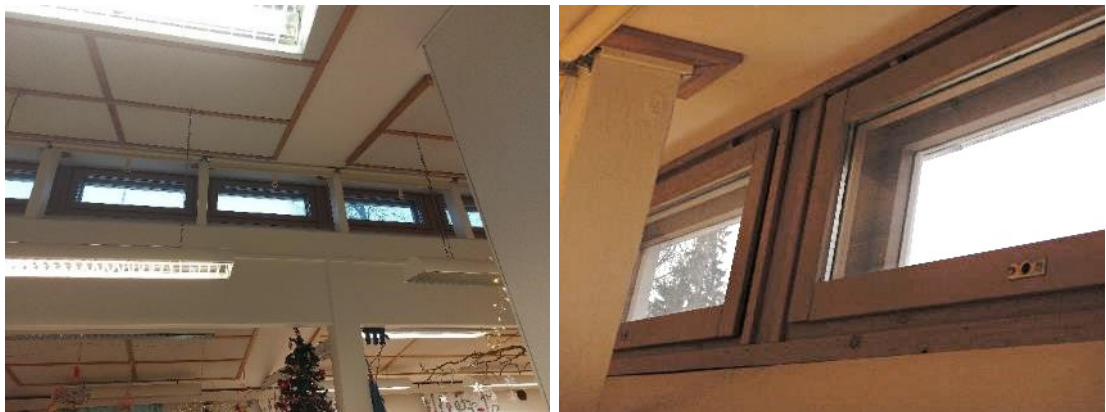
Kuva 31. Kattolappeiden väliset puiset yläikkunat sisältä nähtynä. Yhdessä kohdassa todettiin alapuolella kattopinnassa vuotojälki. Muutoin ei puutteita.
