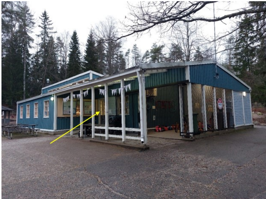
Kuva 7. Rakennuksen julkisivut kaakkoon ja lounaaseen joulukuun alussa 2025. Sokkeli on matala, mutta maanpinta kallistaa loivasti pois päin rakennuksesta. Pääsisäänkäynti on kuvassa keskellä.
