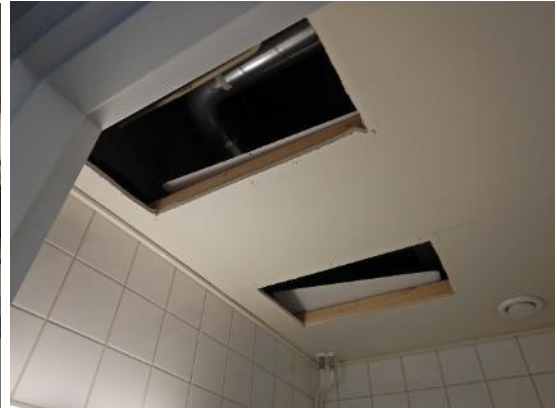
Kuva 74. Keittiö 101. Katossa vanhoja vuotojälkiä melko laajalla alueella. Oikealla wc:n 118 alakaton tarkastusluukut.
