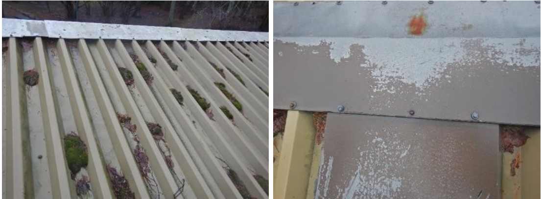
Kuva 70. Sammalta vesikatteen urissa. Oikealla harjapelti, jonka maali on kulunut ja pellin pinta on alkanut ruostua.
