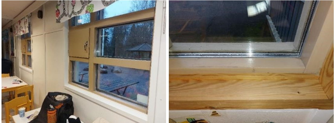
Kuva 29. Ikkunat sisäpuolelta. Ei puutteita.
