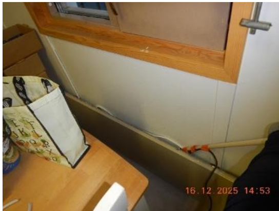
Kuva 48. Keittiön 101 ilmavuotokohtia: patterikiinnikkeiden kohdat, ikkunaelementin nurkat.
