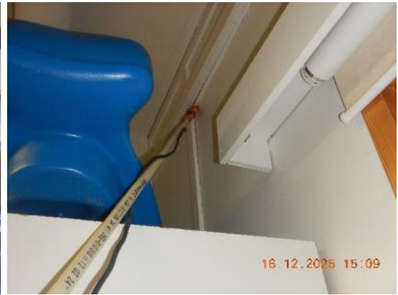
Kuva 51. Tilan 105 ilmavuotokohtia: ulkoseinän liitokset paikallisesti.
