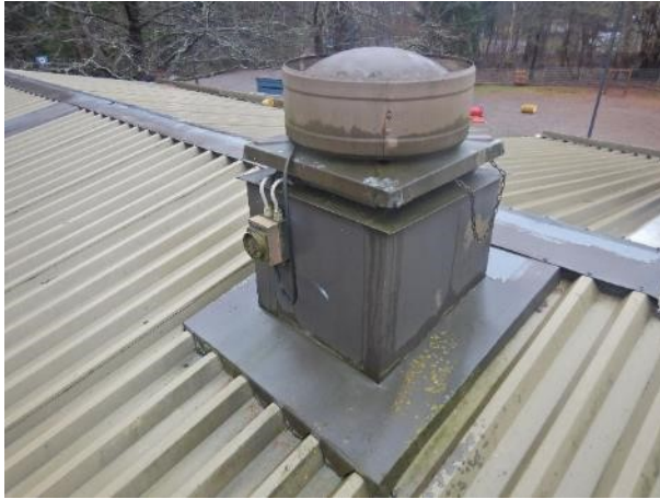
Kuva IV11. Yleiskuva, vesikatolla sijaitseva käytöstä poistettu huippuimuri.
