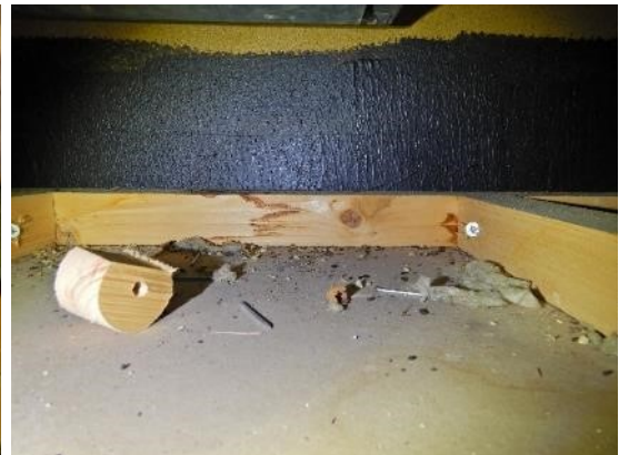
Kuva 75. Wc:n 118 alakattotilaa. Tilassa avointa mineraalivillaa, hiirenpapanoita, roskaa ja vanhoja kosteusjälkiä. Tilassa ovat näkyvillä uusitut, vedeneristetyt väliseinälevytykset sekä myös vanhaa lastulevytystä.
