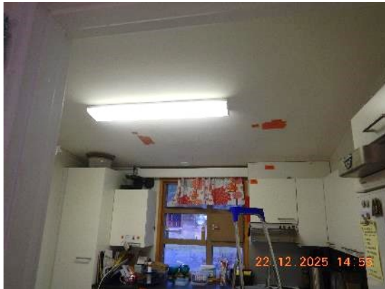
Kuva 74. Keittiö 101. Katossa vanhoja vuotojälkiä melko laajalla alueella. Oikealla wc:n 118 alakaton tarkastusluukut.
