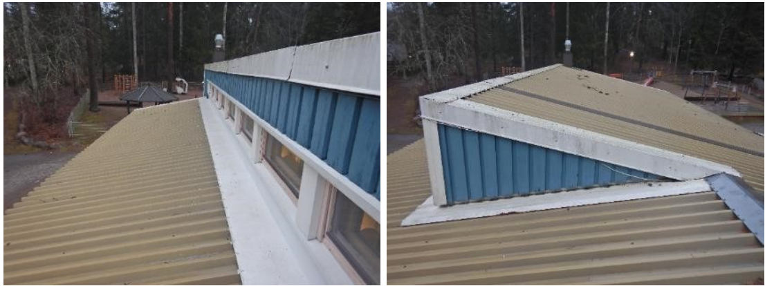
Kuva 30. Vesikaton yläpuoliset ulkoseinäosiot ja yläikkunat pulpettikaton lappeiden välissä. Ikkunat aukeavat lounaaseen.
