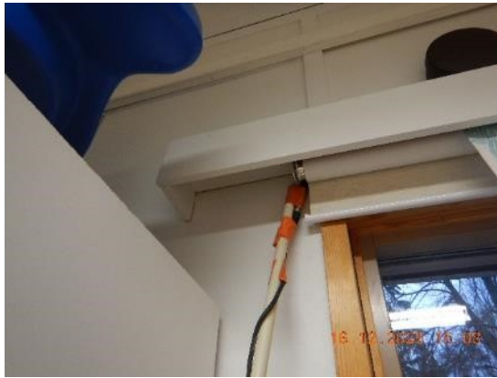
Kuva 51. Tilan 105 ilmavuotokohtia: ulkoseinän liitokset paikallisesti.
