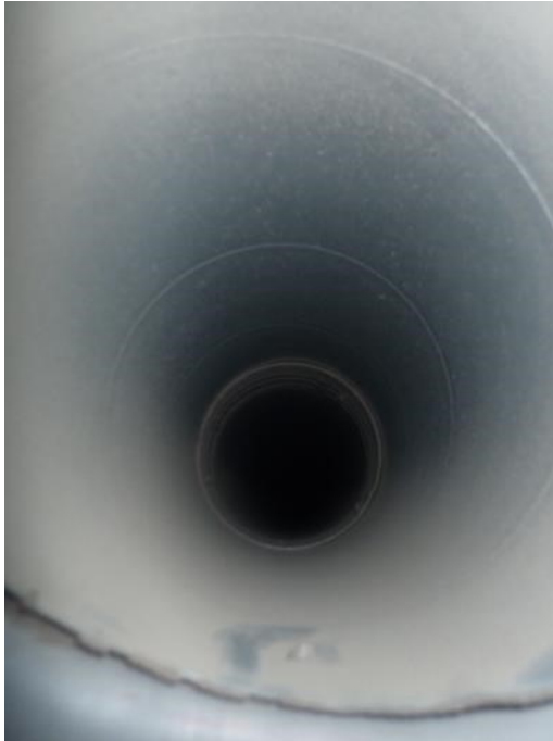
Kuva IV15. Pölykertymä poistoilmakanavistossa.
