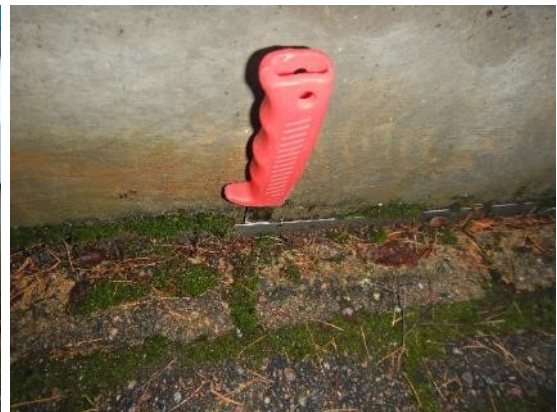
Kuva 15. Rakennuksen lounaisjulkisivulta. Sokkelissa on sammalta vain sokkelin alaosassa, maanpinnan tasossa. Sokkelin ja asfaltin välissä on peltikaista. Kaista ei liity tiiviisti sokkeliin.
