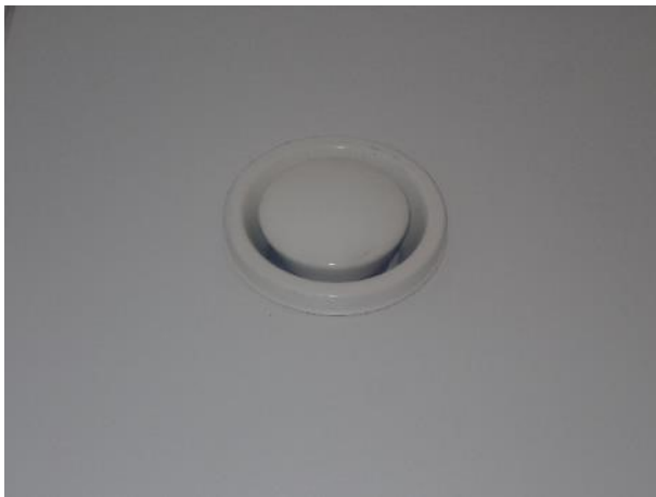
Kuva IV18. Yleiskuva poistoilmapäätelaitteesta.
