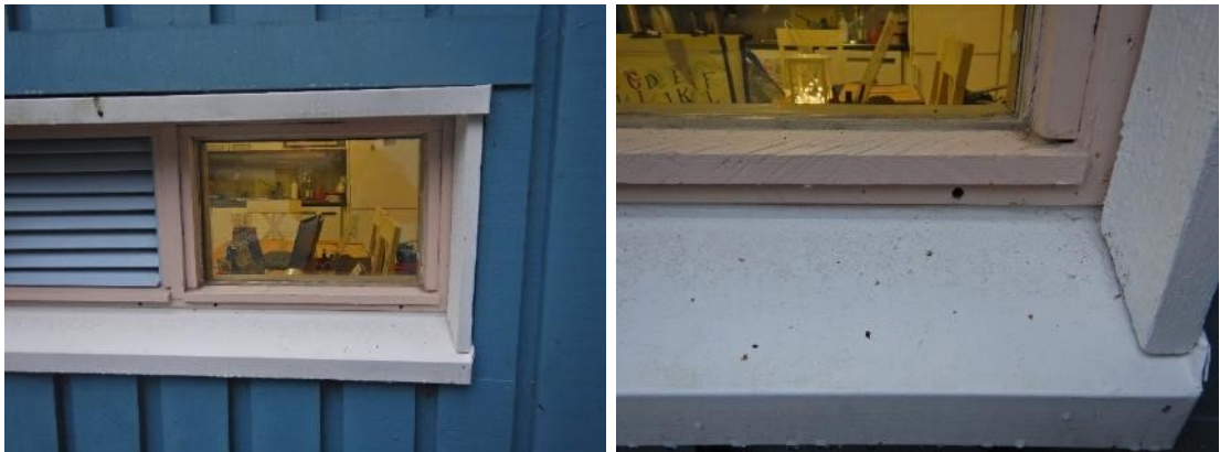
Kuva 27. Kiinteitä lämpölasia-ikkunoita, suojapellit ylä- ja alapuolella. Ei puutteita.
