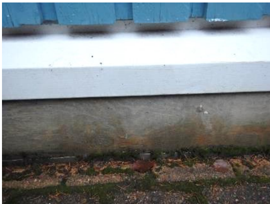
Kuva 15. Rakennuksen lounaisjulkisivulta. Sokkelissa on sammalta vain sokkelin alaosassa, maanpinnan tasossa. Sokkelin ja asfaltin välissä on peltikaista. Kaista ei liity tiiviisti sokkeliin.
