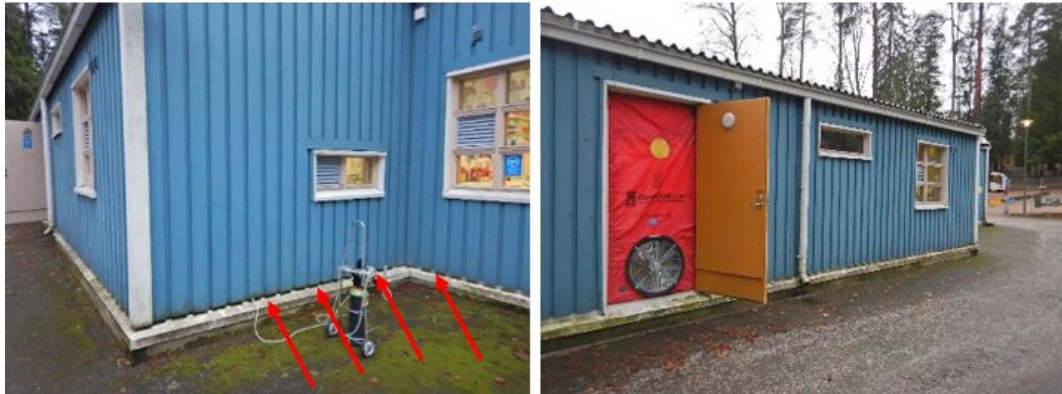
Kuva 46. Keittiön 101 ja tilan 105 alueen merkkiainekokeen kaasun syöttöä. Syöttökohdat merkitty kuvaan nuolilla. Oikealla alipaineistuskalusto, jolla koko rakennuksen sisätila alipaineistettiin kokeita varten.
