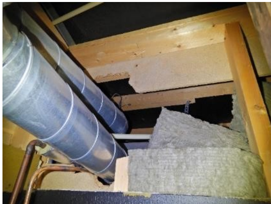
Kuva 75. Wc:n 118 alakattotilaa. Tilassa avointa mineraalivillaa, hiirenpapanoita, roskaa ja vanhoja kosteusjälkiä. Tilassa ovat näkyvillä uusitut, vedeneristetyt väliseinälevytykset sekä myös vanhaa lastulevytystä.
