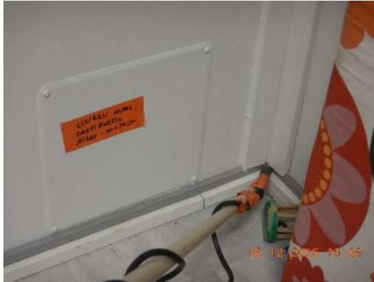
Kuva 50. Tilan 105 ilmavuotokohtia: ulkoseinän liitokset paikallisesti.
