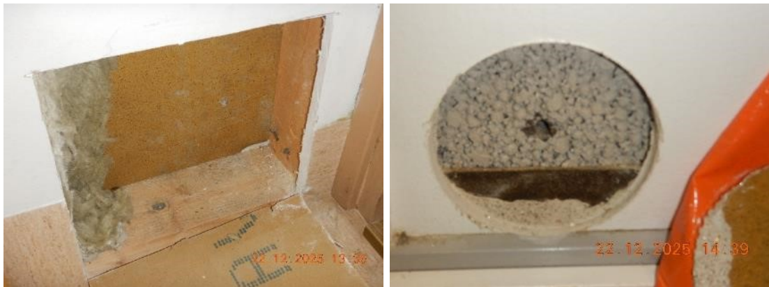
Kuva 44. Vanhan suihkun vastaisen väliseinän rakenneavaus RA7 (vasemmalla) ja wc:n vastaisen väliseinän avaus RA9 (oikealla). Suihkua vasten puurunko ja kuitusementtilevy, wc:tä vasten seinän alaosassa harkko ja kerminosto.
