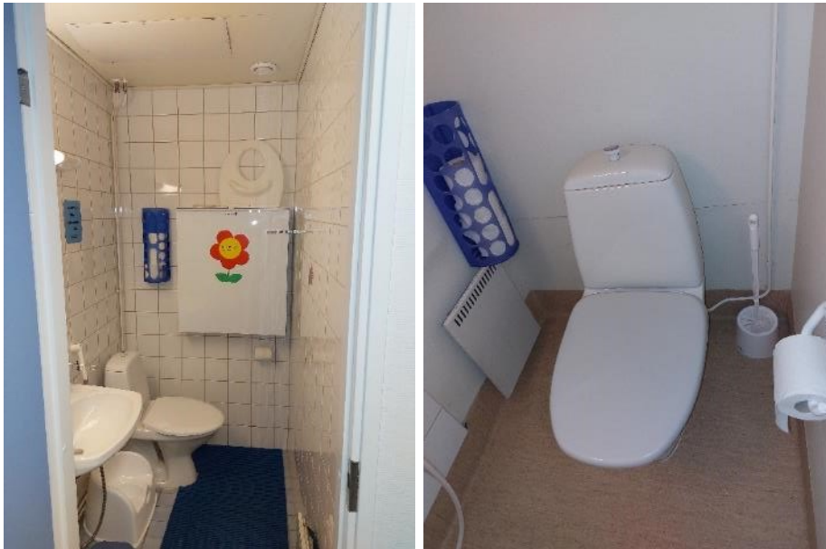
Kuva 19. Rakennuksen wc-tiloja, vasemmalla wc 118, lattiassa vaaleaa 10x10 cm keraamista laattaa, oikealla wc 115b, lattiassa muovimattoa, seinät maalatut.
