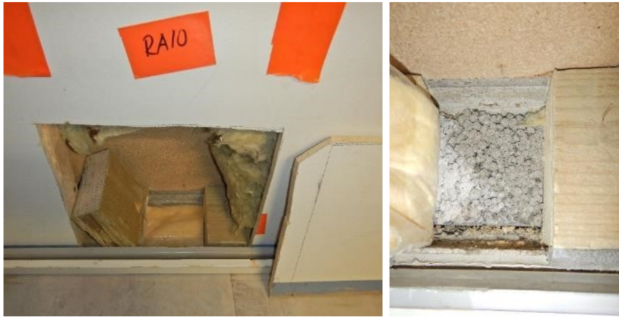
Kuva 43. Omilla perustuksilla lepäävän väliseinän rakenneavaus RA10. Ei poikkeavaa.
