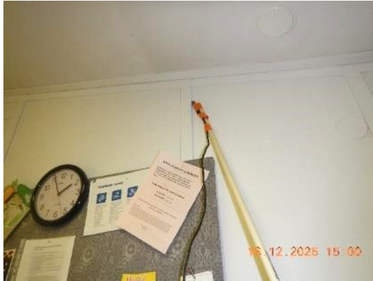
Kuva 47. Keittiön 101 ilmavuotokohtia: levysauma paikallisesti, seinässä olevan peitelevyn reuna.
