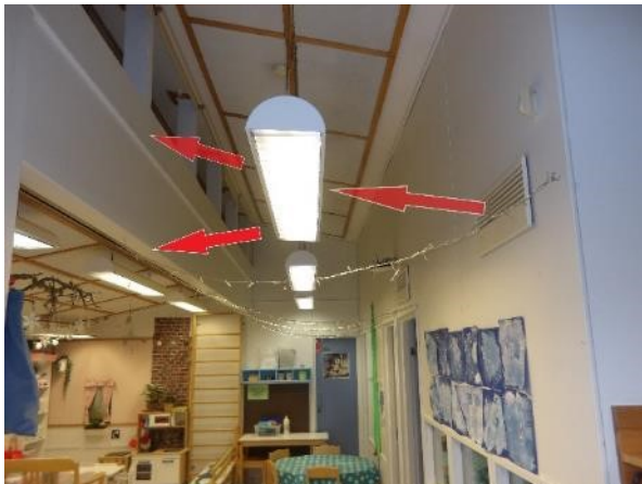
Kuva IV20. Tuloilma törmää valaisimeen, jonka jälkeen se suuntautuu osin ylös kohti seinää ja alemmaksi kohti oleskelualueetta.
