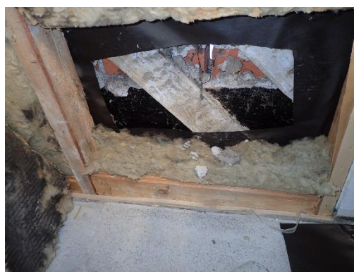
Kuva 19. Länsipäätyseinän rakenneavaus RA14 tilassa 23.
