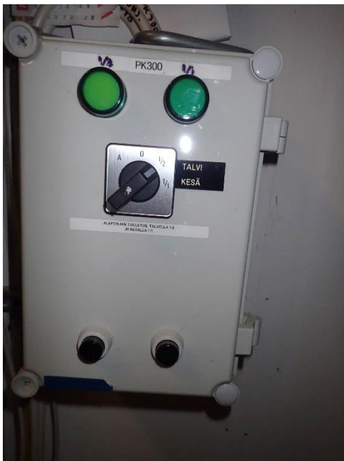
Kuvat 2, 3 ja 4. Kuvassa 2 on esitetty ilmanvaihdon palvelualueet. Ilmanvaihtokuvia ei ollut käytössä, joten tiedot ovat suuntaa antavia. Ryömintätilaan on asennettu erillispoisto, jossa on talvi- ja kesäsäätö. Rakennuksen itäpäätä (rehtorin vanha asunto) palvelee ILTO850 -kone, joka oli säädetty asentoon 2 (normaali, asteikko 1-3).
