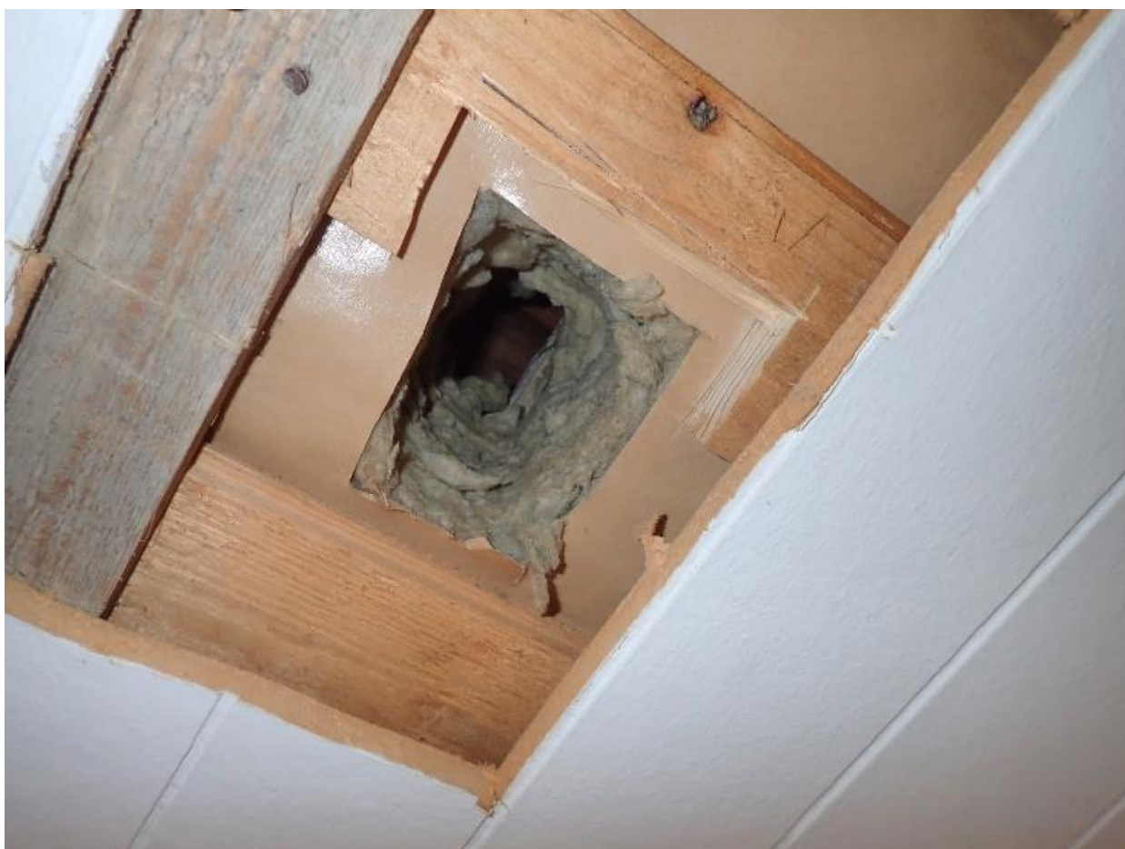
Kuva 33. Rakenneavaus RA3 tilassa 07. Muovitetun pahvin päältä otetusta mineraalivillanäytteestä MR8 ei todettu mikrobikasvustoa.
