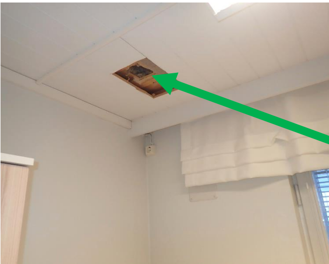
Kuvat 34 ja 35. Tilan 07 yläpohjan rakenneavauksesta RA3 kuva päätyseinän suuntaan. Kattolaudoituksen pinnassa on silminnähtävää mikrobikasvustoa.
