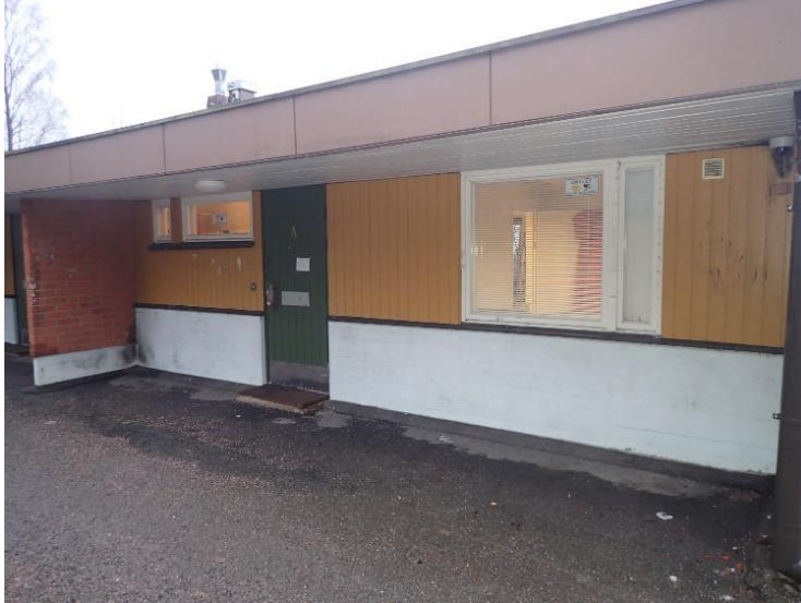
Kuva 15. Pitkillä julkisivuilla ulkoseinärakennetta suojaa säärasitukselta leveät räystäät.
