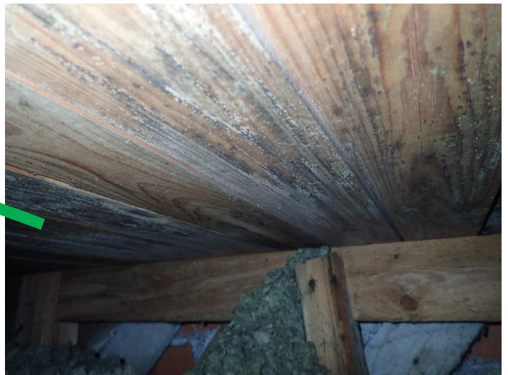
Kuvat 34 ja 35. Tilan 07 yläpohjan rakenneavauksesta RA3 kuva päätyseinän suuntaan. Kattolaudoituksen pinnassa on silminnähtävää mikrobikasvustoa.
