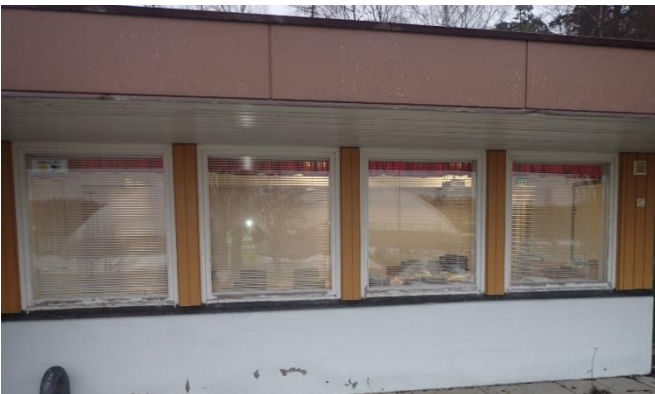
Kuva 21, 22 ja 23. Yleiskuvia kohteen ikkunoista ulko-ovesta. Eteläjulkisivun puoleiset ikkunapuitteet ja ovet ovat huoltotoimenpiteiden tarpeessa.
