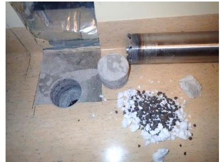
Kuva 10. Rakenneavaus 1. Styroksissa tai lecasorassa ei todettu mikrobikasvustoa.
