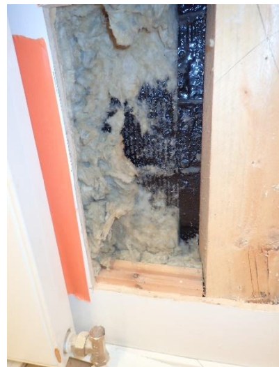
Kuva 18. Luokahuoneen ulkoseinän mineraalivillaeristeessä ei todettu mikrobikasvustoa.
