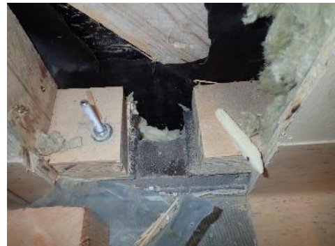
Kuva 16. Tilan 05 ulkoseinän tervapaperin pinnoissa, mineraalivillassa tai SPU-eristeessä ei todettu mikrobikasvustoa.
