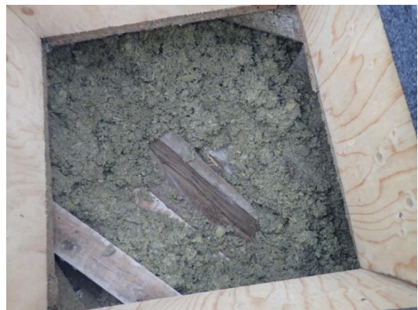
Kuvat 36 ja 37. Tilan 03 kohdalla kattoluukku todettiin osittain mikrobivaurioituneeksi (tummentumat luukussa). Laudanpalat ja osa puhallusvillasta oli märkää.
