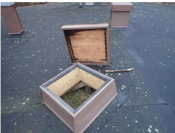
Kuvat 36 ja 37. Tilan 03 kohdalla kattoluukku todettiin osittain mikrobivaurioituneeksi (tummentumat luukussa). Laudanpalat ja osa puhallusvillasta oli märkää.
