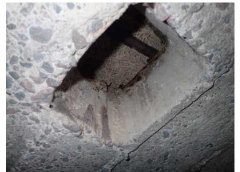
Kuva 11. Kuva ryömintätilan puolelta vanhasta alapohjarakenteen läpivientikohdasta. Eristekerroksena on tojax-eriste.
