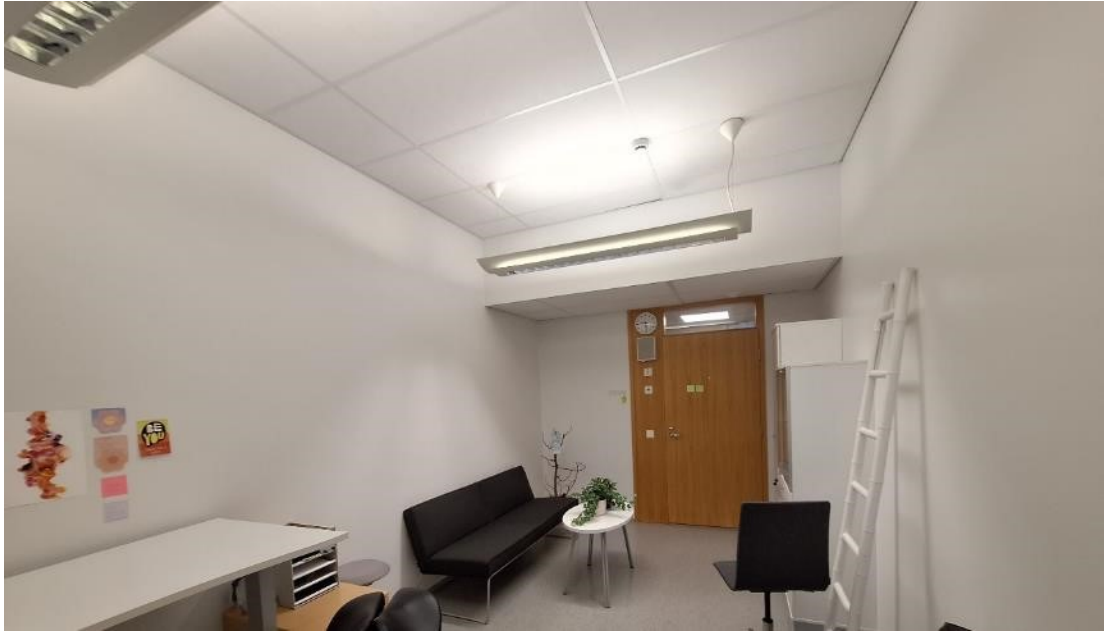
Kuva 40. Tarkastettujen tilojen alakatto oli kahdella eri tasolla, joista alemman alakaton sisällä oli taloteknisiä asennuksia.
