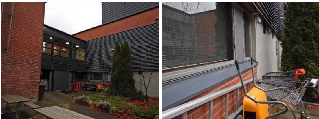
Kuva 11. Yleiskuva sisäpihasta ja lähikuva tilan 180 kohdalta, jossa ei havaittu mitään poikkeavaa.
