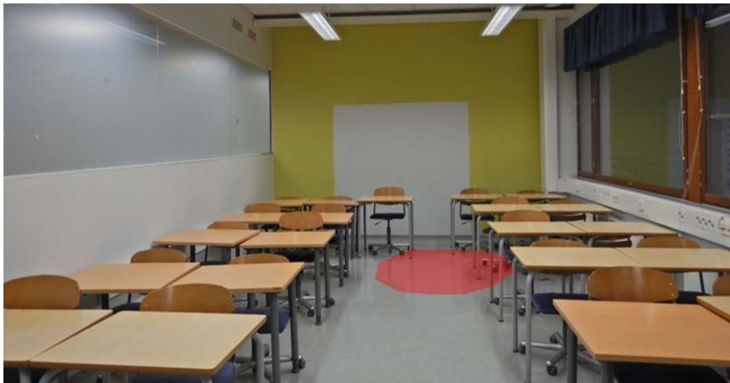
Kuva 35. Luokan 272 lattian alue, jossa havaittiin kohonneita pintakosteusilmaisimen lukemia. Kohonneille kosteuksille ei havaittu mitään selvää syytä.
