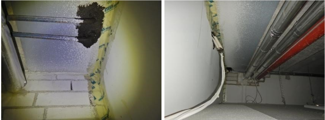
Kuva 28. Tilassa 179 välipohjan liittymät on tiivistetyt kuten myös patteriputken läpivienti.
