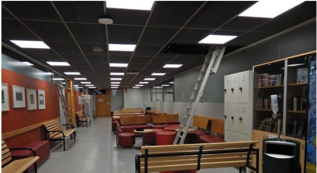
Kuva 42. 2. kerroksen käytävällä oli alakattona ritiläkatto.
