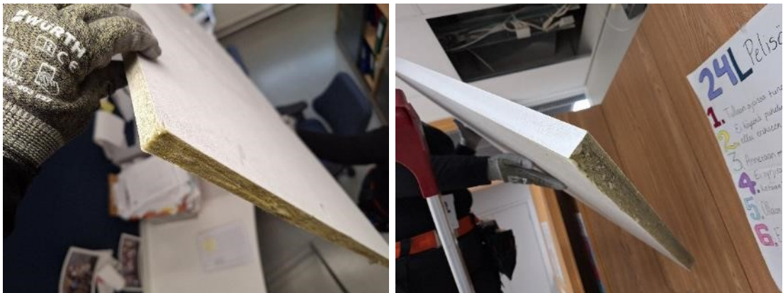
Kuva 41. Eri korkeuksille asennettujen alakattojen levytys poikkesi toisistaan. Ylemmällä, lähes kattopinnan tasolla olevan alakaton levyjen reunoihin oli tehty pölynsidontakäsittely. Alemmalla alakattotasolla levyjen reunoissa oli varsinainen pintakerros. Molemmilla tasoilla vajaamittausten levyjen leikkauspinnat levyissä olivat avoimella villapinnalla.
