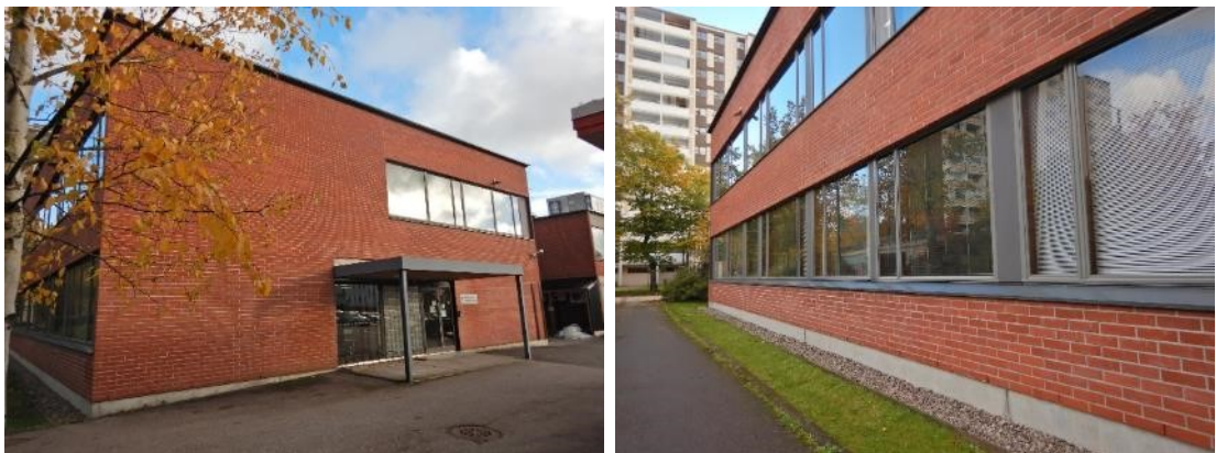
Kuva 9. Yleiskuvia laajennusosasta. Nurmialueiden ja rakennuksen välissä on sorakaista ja julkisivut ovat yleisesti hyväkuntoiset.
