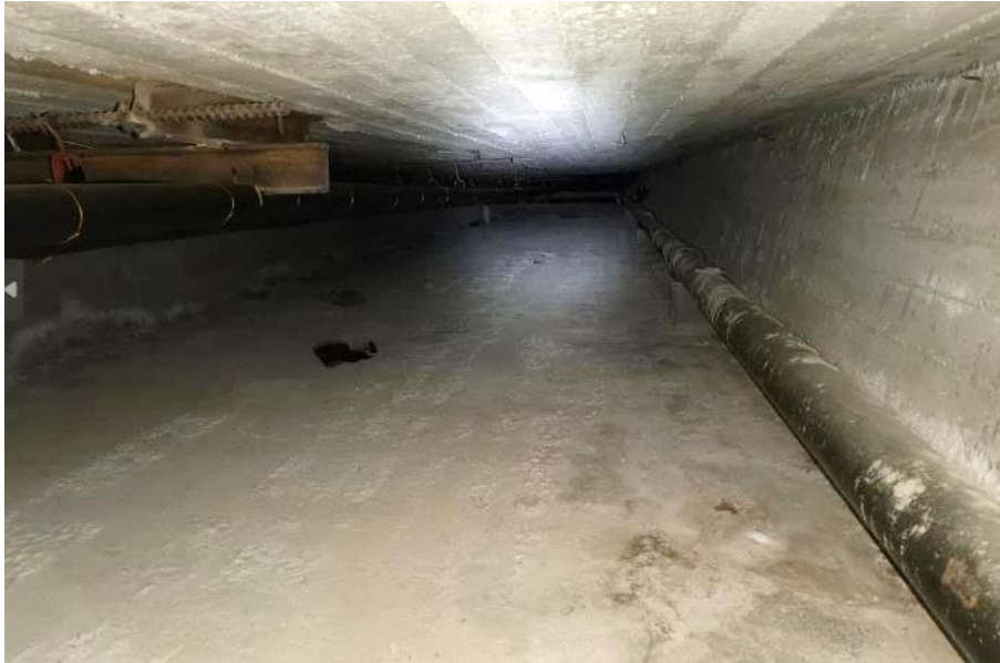
Kuva 37. Yleiskuvia keskikäytävän alla olevasta putkikanaalista alempana sijaitsevalta osalta. Putkikanaali oli pääosin siisti, mutta siellä oli voimakas maakellarin haju.
