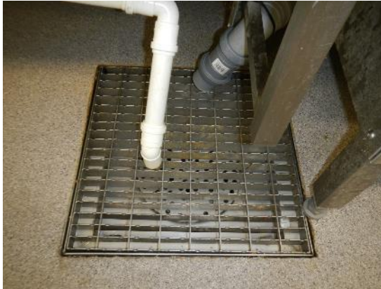
Kuva 21. Keittiössä ei todettu pintakosteuspoikkeamia. Kaivot olivat siistit ja toimivan näköiset.
