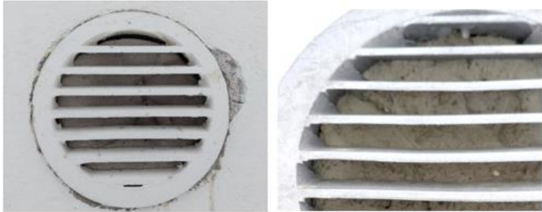
Kuvat 63 a ja b. Sisäpuolelta laastilla/betonilla ummistettu raitisilmakanava.
