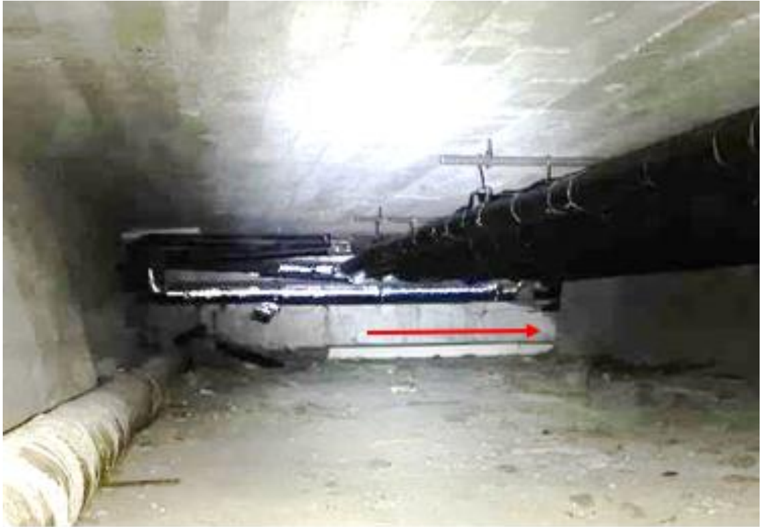
Kuva 39. Iso putkikanaali liittyy rakennuksen itäpäässä pieneen putkikanaaliin (nuoli), ks. seuraavat kuvat.
