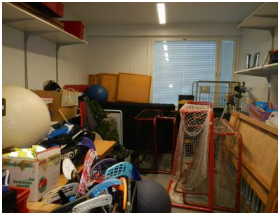
Kuva 27. Varastohuoneen 034 lattiassa on muovimatto. Tilassa on paljon tavaraa, eikä suurinta osaa huoneesta voitu tarkastaa. Lattianpäällyste oli tarkastetuin osin tyydyttävässä kunnossa, pintakosteuspoikkeamia ei todettu.
