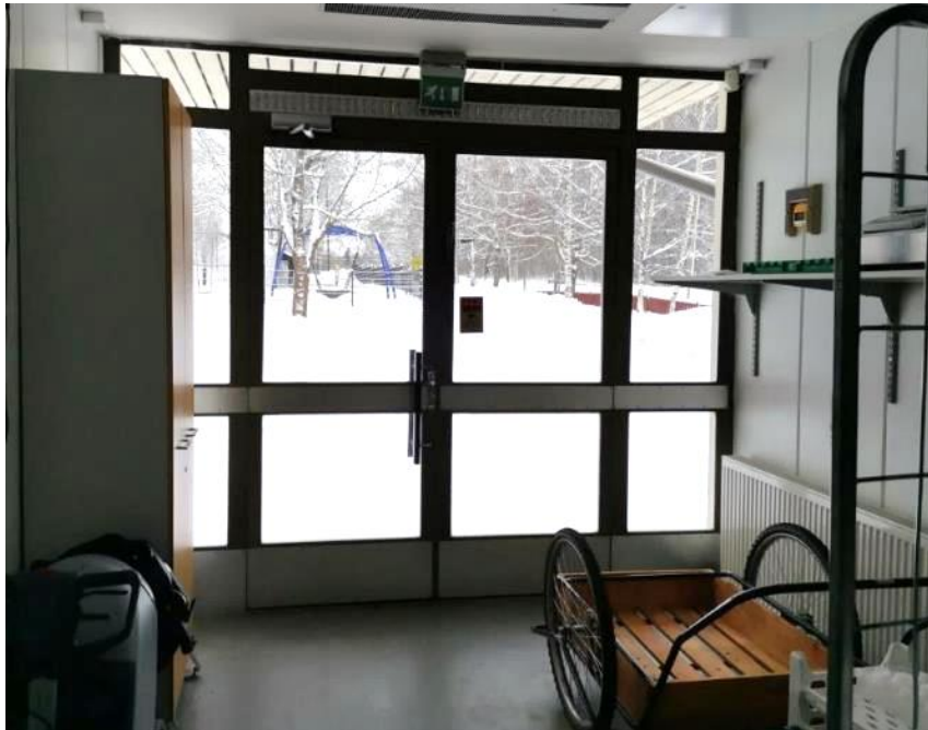
Kuva 85. Rakennuksen pääovet ovat ikkunallisia teräsovia. Näiden kunto oli hyvä.
