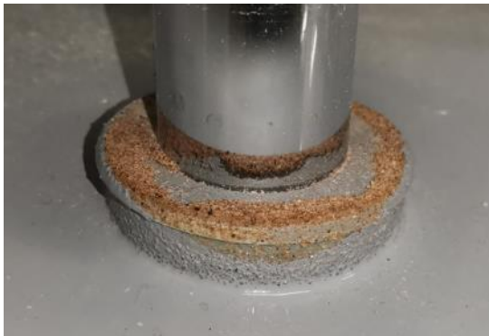
Kuva 48. Alapohjaläpivienti, jonka lattianpinnoitemassa tiivistää hyvin.
