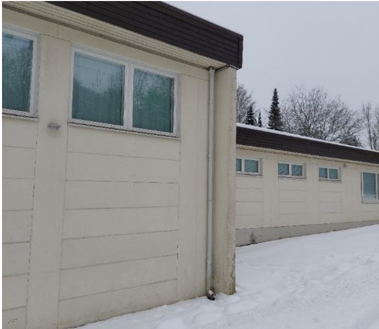
Kuva 10. Kattovedet on johdettu kattokaivojen kautta sadevesijärjestelmään lukuun ottamatta liikuntasalin katon nurkkaa, jossa on syöksytorvi rakennuksen pohjoissivulla.
