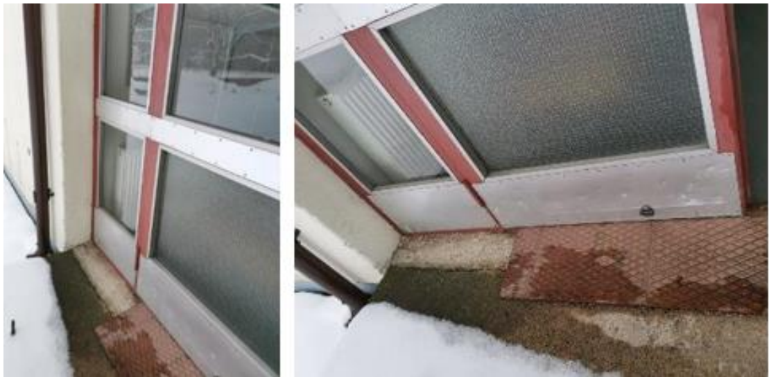
Kuvat 86 a ja b. Teräsovien maalipinnat ja pellitykset ovat hyvässä tai tyydyttävässä kunnossa. Kynnyspelti on vajaa, mutta kattolippa suojaa ovea melko hyvin. Tuulisella säällä oven alta voi kuitenkin kulkeutua kosteutta sisään. Eteisen lattiassa ei todettu kohonneita pintakosteuslukemia.
