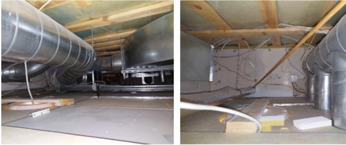
Kuvat 34 a ja b. Alakattojen yläpuoliset tilat olivat hyväkuntoisia eikä viitteitä esim. vesivuodoista havaittu.
