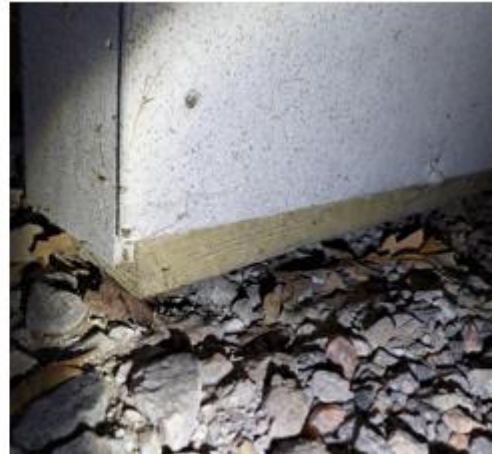
Kuvat 14 a ja b. Ryömintätila on jaettu kolmeen lohkon palo-osastojen mukaan. Osastojen välissä on puurunkoinen, kuitusementtilevypintainen seinä. Seinän alaosan painekyllästetty puurunko oli paikoin upotettu sepelitäyttöön.
