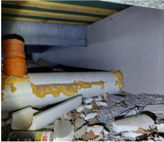
Kuvat 13 a ja b. Ryömintätilan pohjalla oli paikoin roskaa ja rakennusjätettä.
