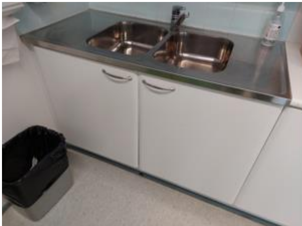
Kuvat 8 a ja b. Luokkatiloissa olleiden kalusteiden sokkelissa oli reikiä, jotta mahdolliset vesivuodot havaitaan aikaisessa vaiheessa. Kalusteiden alla ei havaittu viitteitä vesivuodoista.
