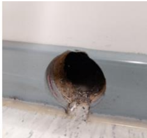
Kuvat 8 a ja b. Luokkatiloissa olleiden kalusteiden sokkelissa oli reikiä, jotta mahdolliset vesivuodot havaitaan aikaisessa vaiheessa. Kalusteiden alla ei havaittu viitteitä vesivuodoista.
