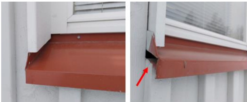
Kuvat 23 a ja b. Ikkunapellityksissä ei havaittu merkittäviä puutteita. Peltien päädyssä on pieni rako, josta vähäisiä määriä sadevettä voi päästä julkisivuverhouksen taakse.
