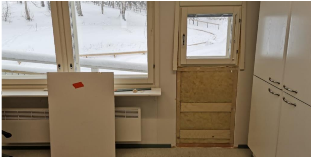
Kuvat 25. Yleiskuva ulkoseinään tehdystä rakenneseinestä. Ikkunan alta irrotettiin kokonainen sisäverhoukseen.
