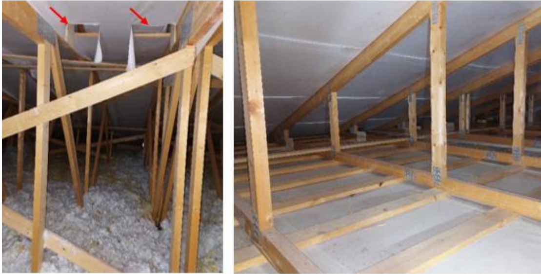
Kuvat 37 a ja b. Yläpohjan ullakkotilassa on kaksi aluskatekerrosta eri tasossa. Alimmaiseen aluskatteeseen on tehty reikiä (punaiset nuolet) tuuletukseen aikaansaamiseksi.
