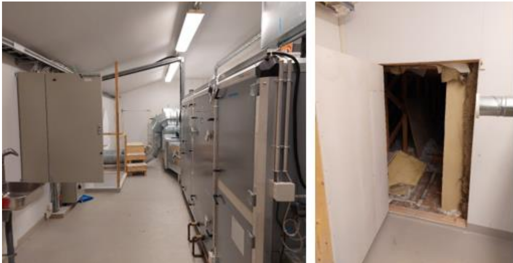
Kuvat 40 a ja b. Ullakkotilan keskellä on IV-konehuone, jonka sivuilla oleviin ontelotiloihin ei ollut kulkua. IV-konehuoneesta on kulku eteläpäädyn ullakkotilaan.
