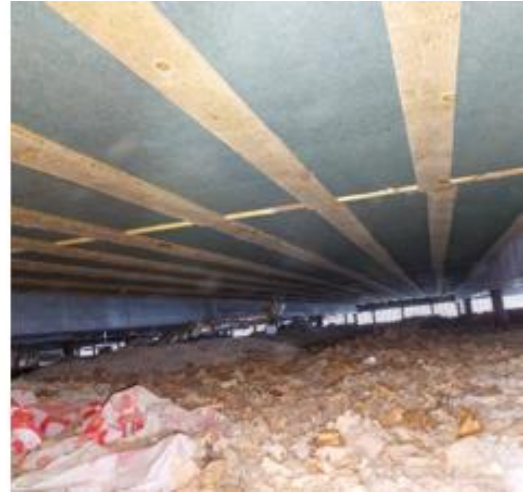
Kuvat 13 a ja b. Ryömintätilan pohjalla oli paikoin roskaa ja rakennusjätettä.
