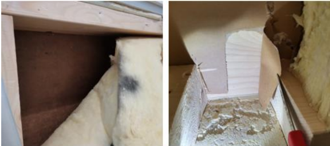
Kuvat 27 a ja b. Eristeen takana on yleisesti tuulensuojalevy. Seinien alaosiin tehdyissä avauksissa todettiin lauta/vaneri, jonka sisäpuolella oli paperi. Lauta/levy on mahdollisesti elementtiä jäykistävä rakenne. Eristevilloissa oli paikoin vähäistä ilmavuotoon viittaavaa tummumaa. Rakenteet olivat aistinvaraisesti arvioiden hyvin kuivia eikä viitteitä vaurioista havaittu. Alajuoksun alla, seinä- ja alapohjajaelementin välissä on polyuretaanivaahdotiivistys.
