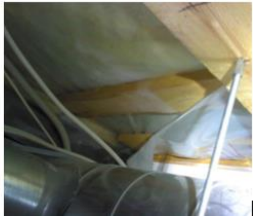
Kuvat 47 a ja b. Käytävällä alakaton yläpuolella yläpohjan ja väliseinän liittymässä alin lämpötila oli 5,0 °C (indeksi noin 35 %). Kohta on huomattavan kylmä. Syytä paikalliselle kylmälle kohdalla ei saatu selville.
