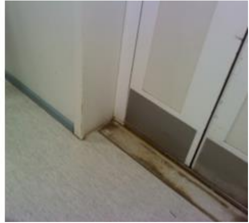
Kuvat 46 a ja b. Käytävällä lattia-seinäliittymässä tilaelementtien liitoskohdassa alin lämpötila oli 10,2 °C (indeksi noin 60 %).
