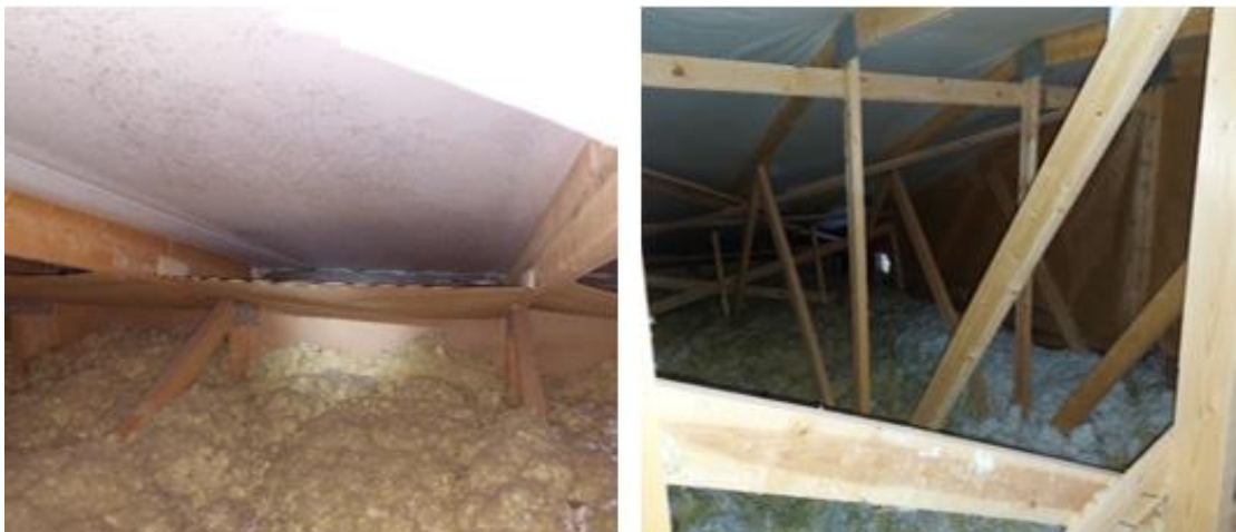
Kuvat 38 a ja b. Ullakkotilan tuuletus on järjestetty räystäiltä (kuva a) sekä päädyn venttiileistä (kuva b). Räystäillä oli pieneläinverkko. Tuuletuksessa ei aistinvaraisesti arvioiden havaittu puutteita.
