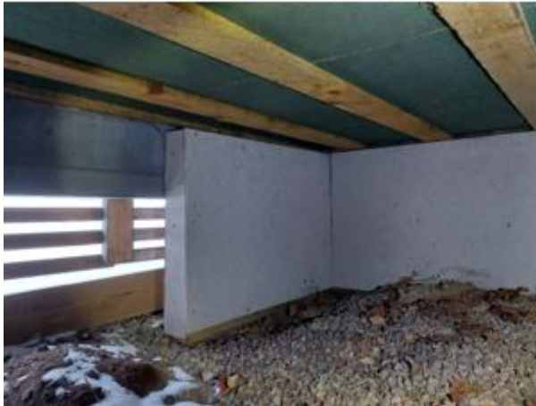
Kuvat 14 a ja b. Ryömintätila on jaettu kolmeen lohkon palo-osastojen mukaan. Osastojen välissä on puurunkoinen, kuitusementtilevypintainen seinä. Seinän alaosan painekyllästetty puurunko oli paikoin upotettu sepelitäyttöön.
