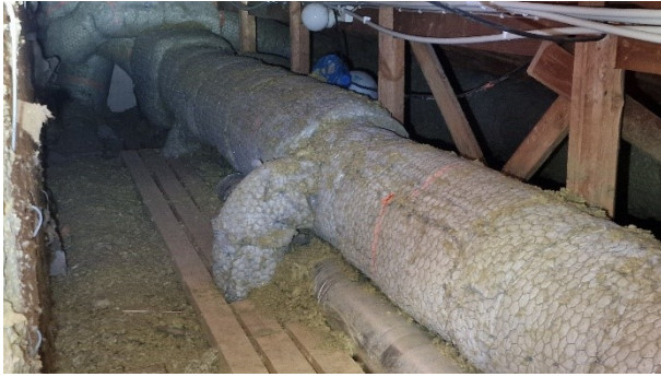
Kuva 81. Yleiskuva tuloilmakanavien asennuksista.
