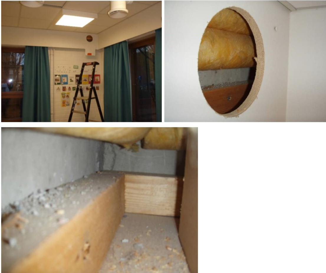
Kuva 49. Rakenneavaus RA3 tilan 136 ulkoseinän yläosan lastulevykoteloon. Tilassa ei havaittu vaurioita eikä ilmavirtausta. Kotelossa on pölyä, sahanpurua ja laastimuruja.
