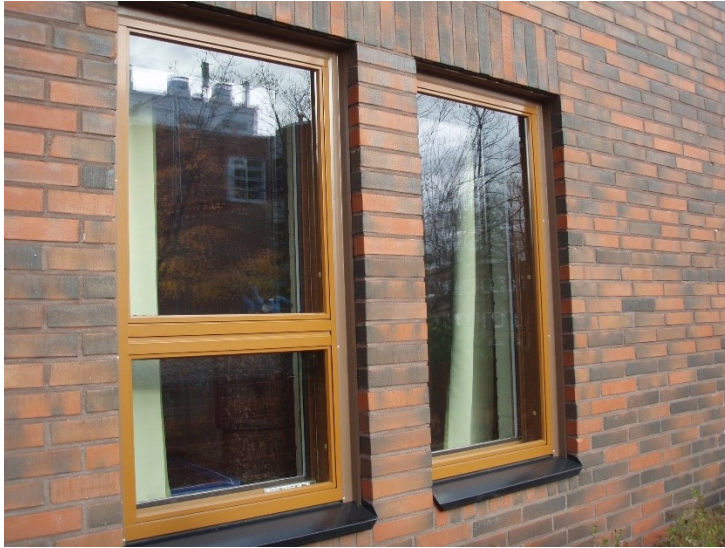
Kuva 38. Vuonna 2018 asennetut ikkunat sekä niiden vesi- ja peitepellitykset ovat hyväkuntoiset.
