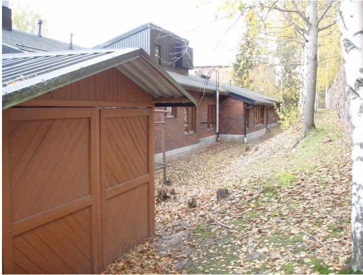
Kuva 5. Koillissivulla noin 3-4 m päässä ulkoseinästä on rinne. Rakennuksen vierellä maan pinta viettää rakennuksesta pois päin.
