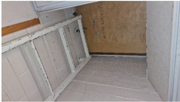
Kuva 100. Kuva IV- konehuoneen luukusta ja seinätikkaista.
