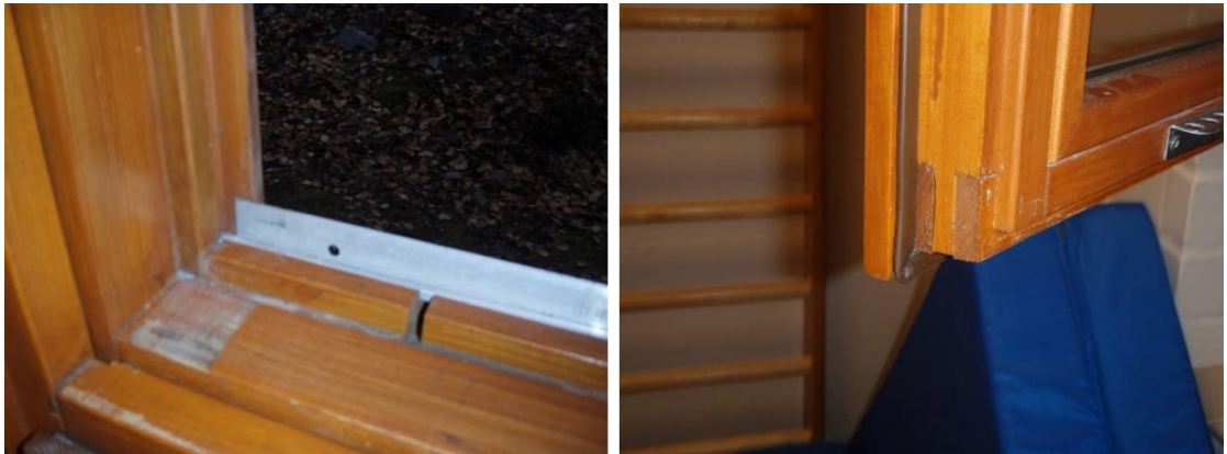
Kuva 39. Koillissivun alkuperäisen ikkunan maalipinta on paikallista käyntipuutteesta johtuvaa kulumaa lukuun ottamatta hyväkuntoinen. Tiivisteet ovat ehjät, mutta painuneet.
