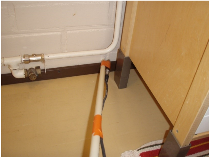
Kuva 50. Ilmavuotoa havaittiin alapohjaliittymässä tiilisaumojen kohdalla.
