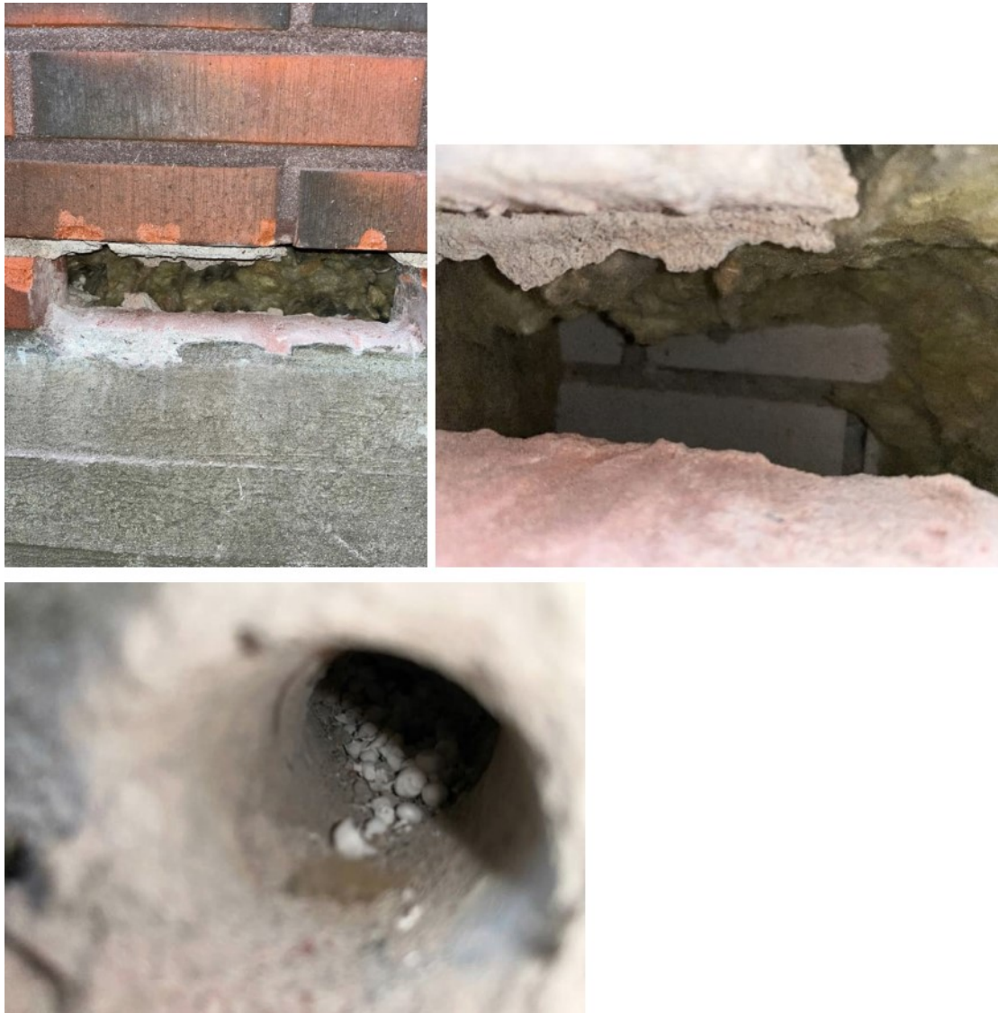
Kuva 47. Rakenneavaukset RA13A ja RA13B tilan 106 ulkoseinään ja sokkelin alareunaan. Ulkoseinän mineraalivillasta (MAT9) eikä sokkelin EPS-eristeestä (MAT10) otetuissa näytteissä todettu mikrobikasvustoa. Avauskohdalla sokkelissa oli tummumaa. Räystääkouru tulvii ja vesi roiskuu sokkelille.
