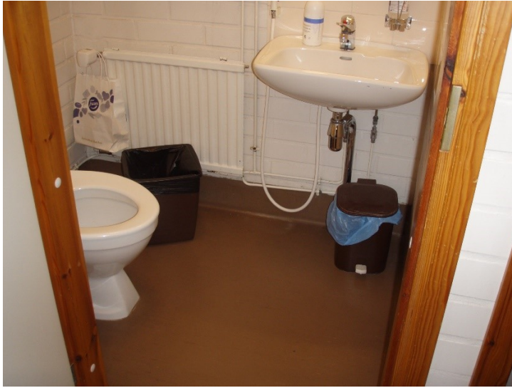
Kuva 12. Osassa tiloista alkuperäinen röpelöpintainen muovimatto, joka on nostettu seinälle.
