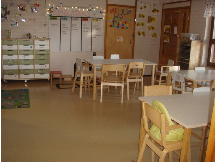
Kuva 10. Tiloissa on pääosin hyväkuntoinen, mutta paikoin kulunut alkuperäinen muovimatto. Lattialistat ovat mekaanisesti kiinnitettyjä muovilistoja.
