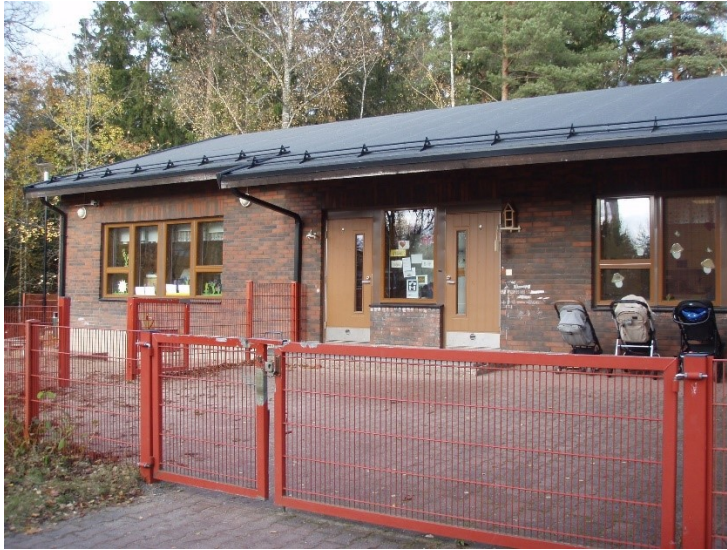
Kuva 3. Päiväkotiryhmien sisäänkäyntipihoilla on betonikiveys, joka viettää rakennuksesta pois päin.
