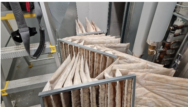
Kuva 72. Ilmanvaihtokoneen poistoilmasuodattimet.
