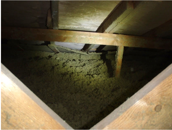
Kuva 61. Räystäällä on tuulenohjaimet. Yhdessä kohdassa ohjainlevyn kiinnitys on irronnut.
