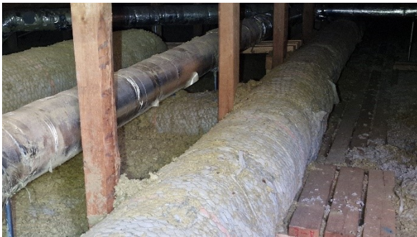
Kuva 82. Yleiskuva tuloilmakanavien asennuksista.
