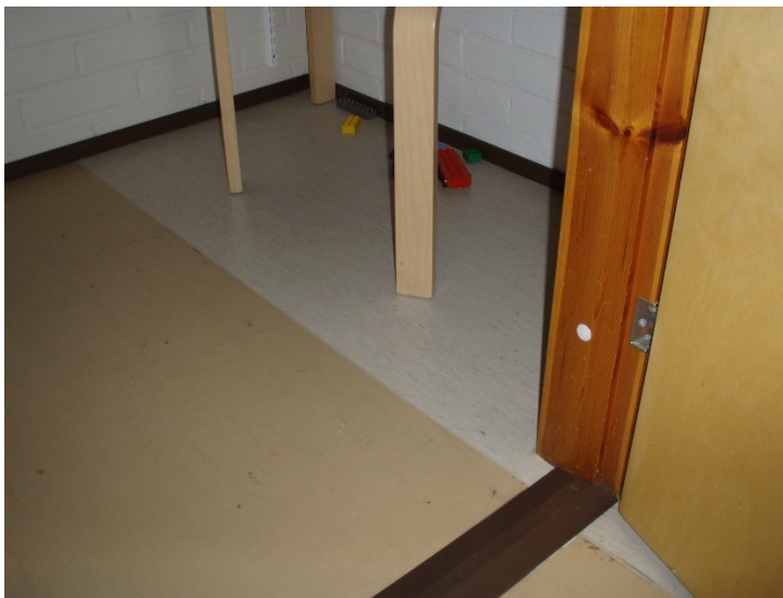
Kuva 11. Paikoin muovimatto on osittain uusittu. Näissä kohdissa ei havaittu kohonneita pintakosteusilmaisimen lukemia.
