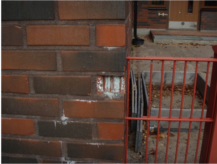
Kuva 32. Rikkoutunut julkisivutiili.
