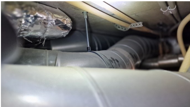
Kuva 84. Yleiskuva poistoilmakanavien asennuksista.
