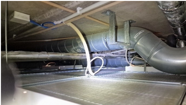
Kuva 83. Yleiskuva poistoilmakanavien asennuksista.
