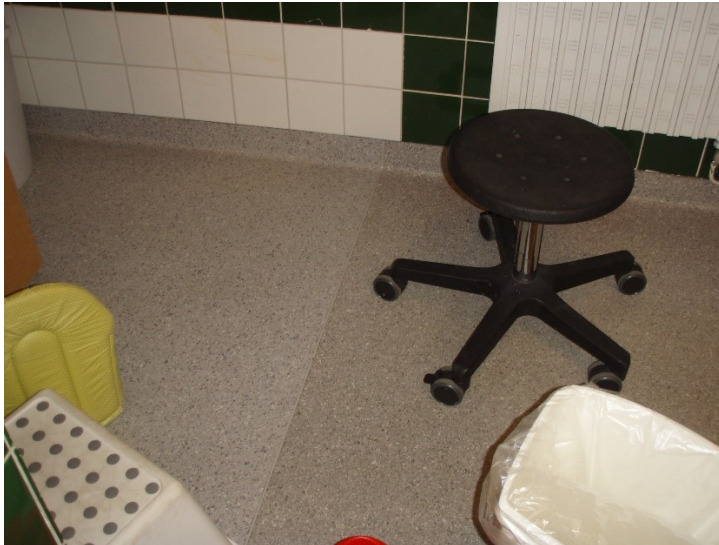
Kuva 13. Päiväkotiryhmien wc- ja pesutiloissa on uudempi hyväkuntoinen muovimatto, joka on nostettu seinälle. Tiloissa 105-106 RST-allas on purettu vaaleamman maton alueelta.
