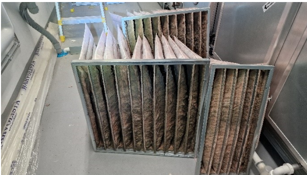
Kuva 71. Ilmanvaihtokoneen tuloilmasuodattimet.
