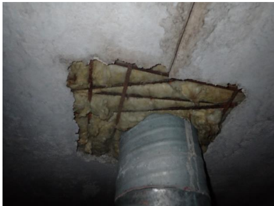
Kuvat 34 a ja b. Läpiviennit ylöspäin on tukittu pääosin mineraalivillalla.
