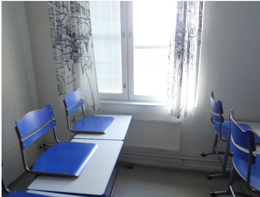
Kuva 60. Yleiskuva ulkoseinästä sisäpuolelta alkuperäisellä osalla. Ulkoseinän sisäpinnat ovat hyväkuntoisia, eikä niissä havaittu puutteita. Seinäpinnoissa on lähinnä käytöstä aiheutunutta kulumaa.
