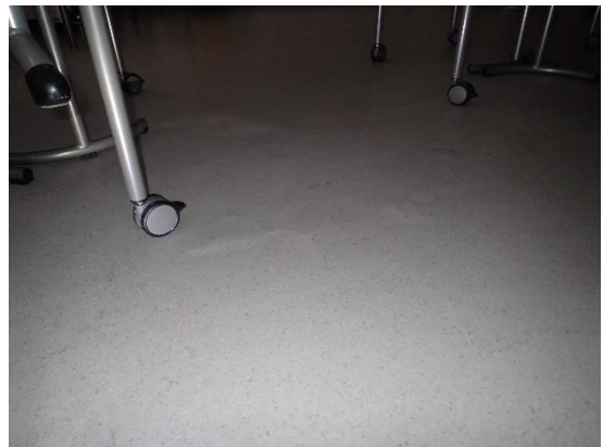
Kuva 96 a ja b. Muutamissa kohdissa laajennusosalla muovimaton alusta (tasoite) on halkeillut ja muovimatto sekä tasoite on irti alustastaan (tila 2071).
