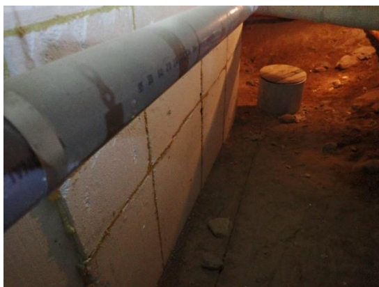
Kuva 40 a ja b. Viemäriputkissa havaittiin kosteuden tiivistymistä. Tiivistynyttä vettä on tippunut alustäyttöön.
