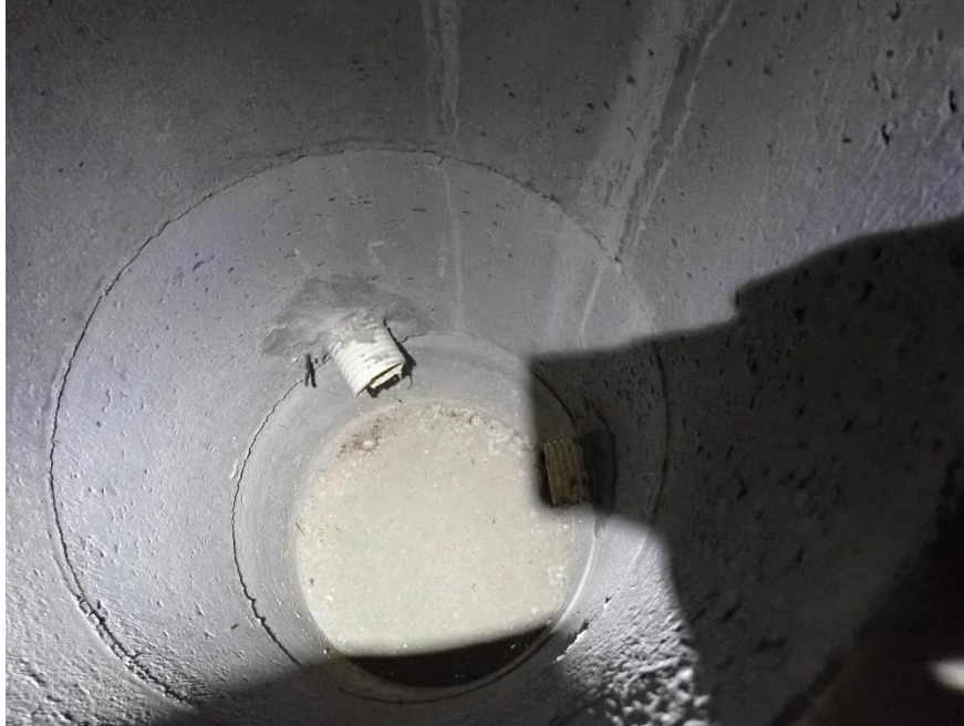
Kuva 41. Ryömintätilassa havaittiin kaksi salaojajärjestelmän tarkastuskaivoa, joissa ei ollut lainkaan vettä.
