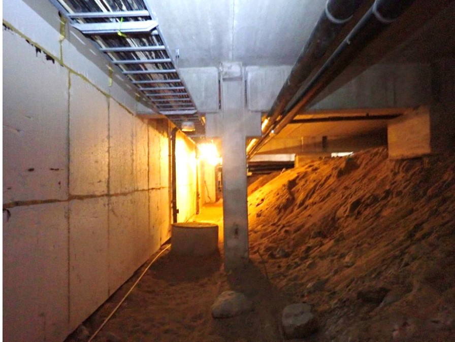
Kuva 29. Yleiskuva ryömintätilasta. Ryömintätila on noin 60...240 cm korkea. Ryömintätilan pohjalla on pääosin hiekka.
