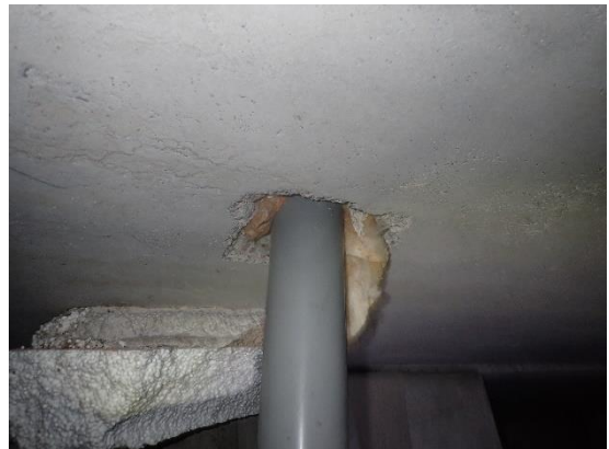
Kuvat 34 a ja b. Läpiviennit ylöspäin on tukittu pääosin mineraalivillalla.
