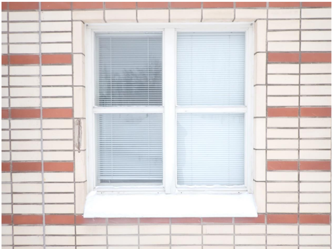
Kuva 65. Yleiskuva alkuperäisen osan ikkunan ulkopinnasta. Ikkunat ovat yleisilmeeltään tyydyttävässä kunnossa.
