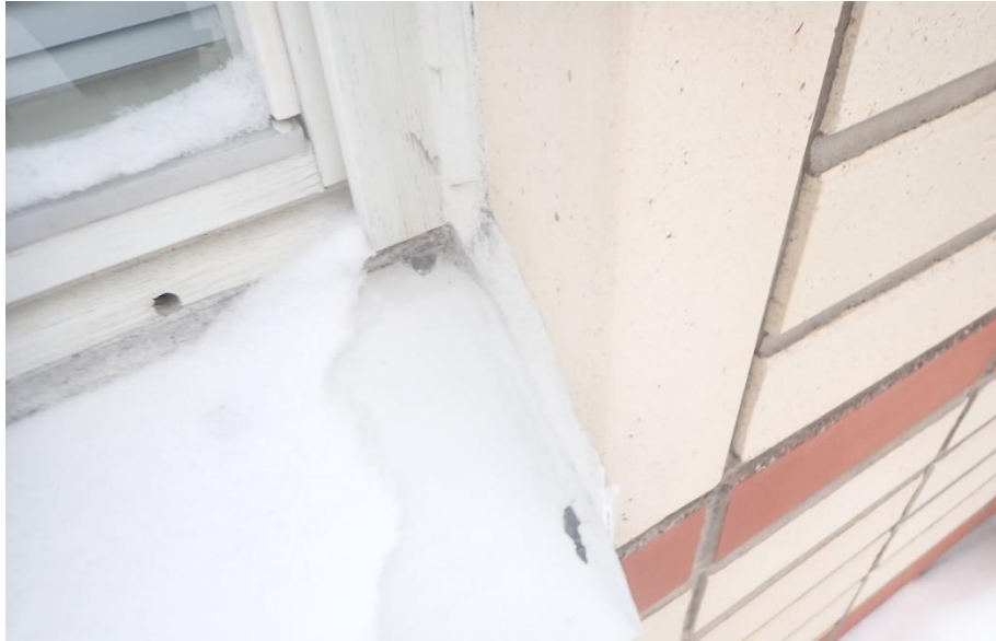
Kuva 70. Ikkunoiden ja ulkoseinäelementtien välisissä elastisissa saumamassoissa ei havaittu puutteita.
