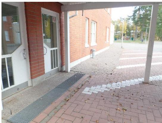
Kuva 2 a ja b. Maanpinnat rakennuksen ympärillä ovat tasaiset tai viettävät loivasti rakennuksesta poispäin.
