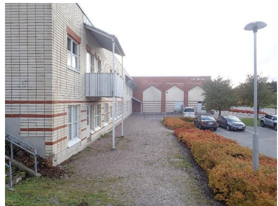
Kuva 2 a ja b. Maanpinnat rakennuksen ympärillä ovat tasaiset tai viettävät loivasti rakennuksesta poispäin.
