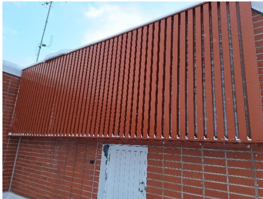
Kuva 112. Yleiskuva ilmanvaihtokoneiden ulkoilmanotosta.
