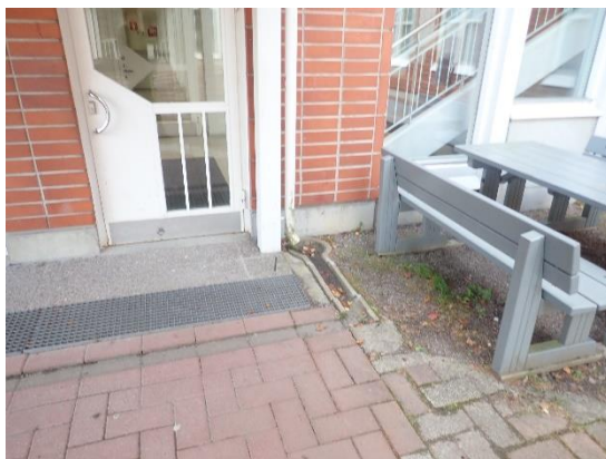
Kuva 5 a ja b. Sisääntulokatoksien kattovedet on johdettu loiskekuppeihin tai suoraan pihamaalle.
