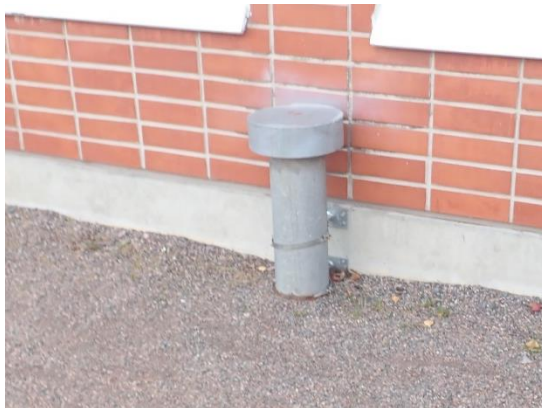
Kuva 37. Ryömintätilan korvausilma on järjestetty tuuletuspaalujen avulla. Ryömintätilassa korvausilmakanavissa havaittiin kosteuden jäätymistä. Lisäksi korvausilmakanavien säleikössä havaittiin runsaasti pölyä ja likaa.
