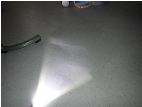
Kuva 96 a ja b. Muutamissa kohdissa laajennusosalla muovimaton alusta (tasoite) on halkeillut ja muovimatto sekä tasoite on irti alustastaan (tila 2071).
