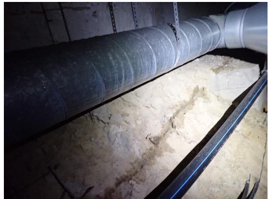
Kuva 39 a ja b. Ryömintätilan korvausilmaventtiileissä ja ilmanvaihtokanavissa oli merkkejä kosteuden tiivistymistä.
