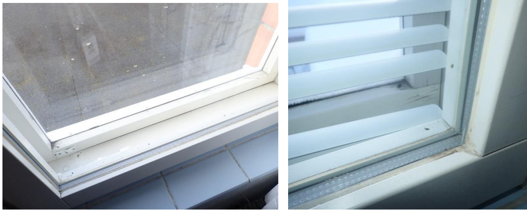
Kuvat 64 a ja b. Yleiskuvia alkuperäisen osan ikkunoiden sisäpinnoista. Ikkunat ovat tyydyttävässä kunnossa.
