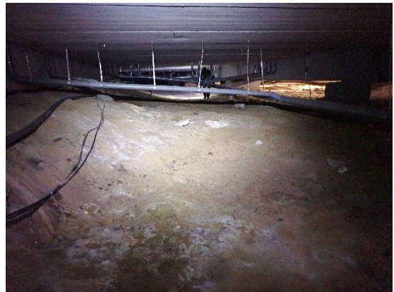
Kuva 29. Yleiskuva ryömintätilasta. Ryömintätila on noin 60...240 cm korkea. Ryömintätilan pohjalla on pääosin hiekka.
