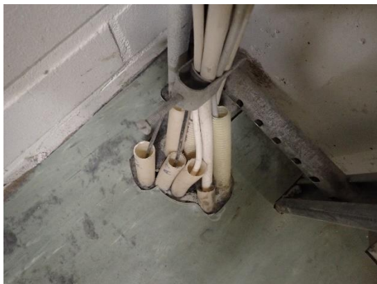
Kuvat 18 a ja b. Alapohjarakenteen sähköläpivienneissä havaittiin laaja-alaisesti ilmatiiveyspuutteita. Läpiviennit olivat tiivistämättömiä ja niistä havaittiin ilmayhteys ryömintätilaan. Sähköläpivientien sijainnit on esitetty liitteessä 3.
