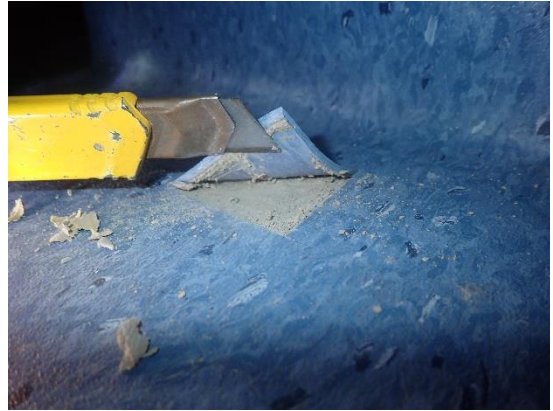
Kuva 23. Viiltomittauksessa VM2 muovimaton alla havaittiin lievä kemikaalimainen haju. Maton tartunta alustaansa oli hyvä.
