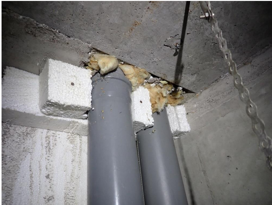
Kuva 31. Läpiviennit ylöspäin on tukittu pääosin mineraalivillalla.
