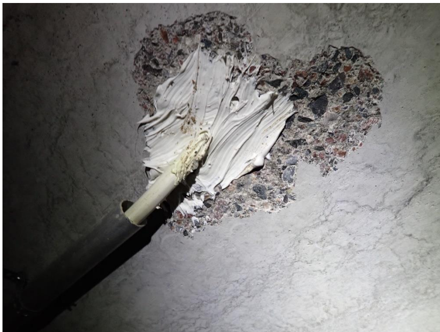
Kuva 32. Yksittäisiä kaapeliläpivientejä on tiivistetty elastisella massalla.
