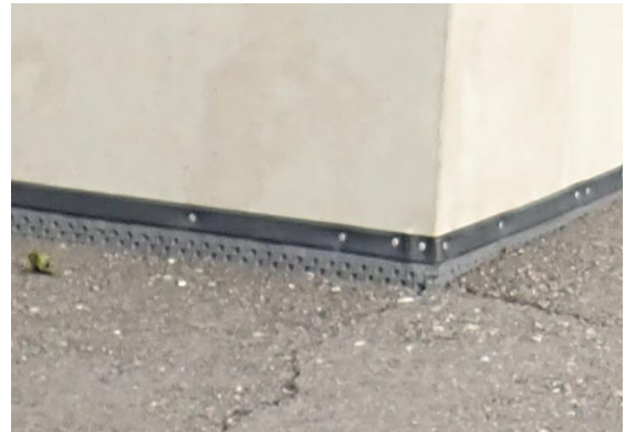
Kuva 6 a ja b. Laajennusosalla on perusmuurilevy näkyvissä asfaltin ja sokkelin välissä.
