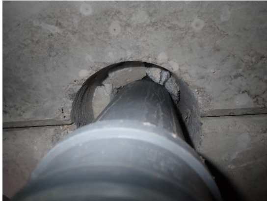
Kuva 43 a ja b. Putkiläpivientejä on tukittu osittain eps-eristeellä ja mineraalivillalla.
