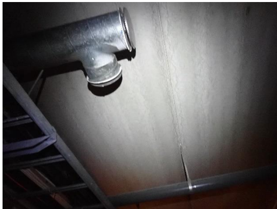
Kuva 39 a ja b. Ryömintätilan korvausilmaventtiileissä ja ilmanvaihtokanavissa oli merkkejä kosteuden tiivistymistä.
