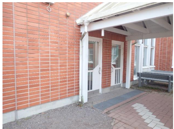
Kuva 5 a ja b. Sisääntulokatoksien kattovedet on johdettu loiskekuppeihin tai suoraan pihamaalle.
