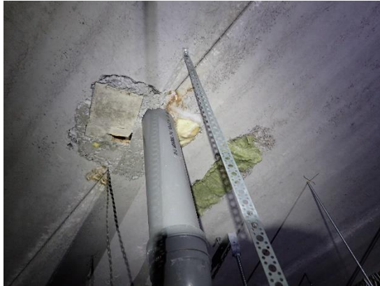
Kuvat 33 a ja b. Ryömintätilasta yläpuolisten tilojen suuntaan havaittiin ilmavirtausta muutamien läpivientien kohdilla.
