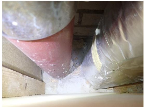
Kuva 95 a ja b. Välipohjien putkiläpivienneissä ei havaittu merkittäviä puutteita. Kuva alkuperäisen osan kotelorakenteesta olevista läpivienneistä.
