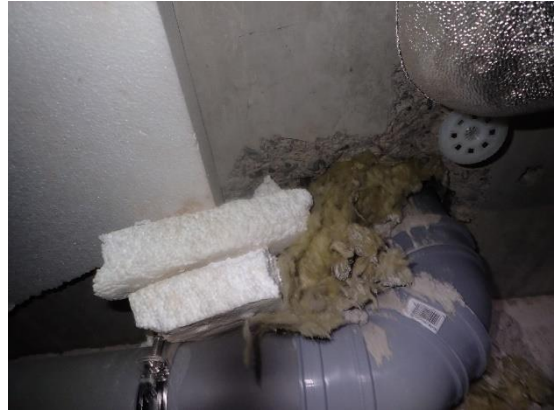
Kuva 43 a ja b. Putkiläpivientejä on tukittu osittain eps-eristeellä ja mineraalivillalla.
