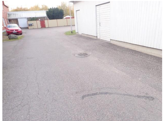
Kuva 3 a ja b. Ajoväylät on osittain asfaltoituja. Asfalttipinnoissa on yleisesti halkeilua ja epätasaisuutta.
