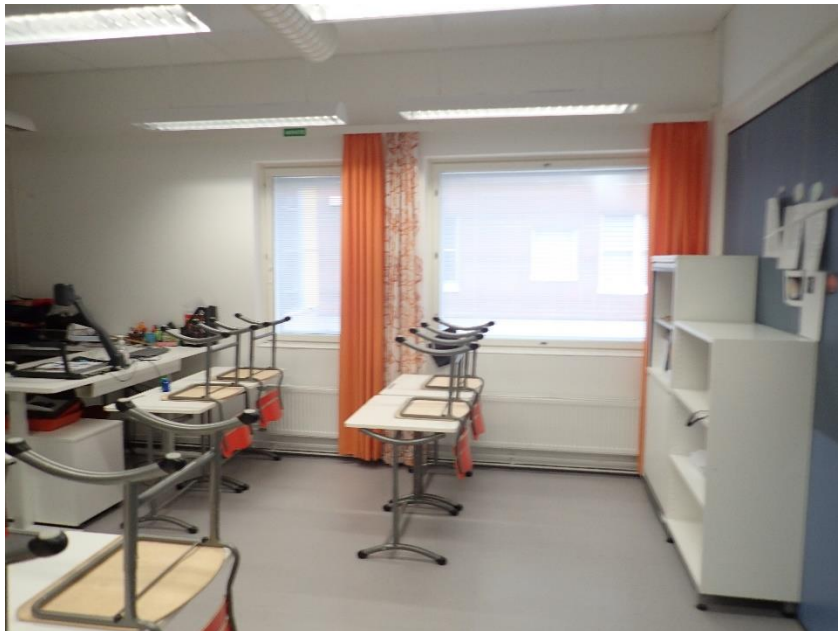
Kuva 61. Yleiskuva ulkoseinästä sisäpuolelta laajennusosalla. Ulkoseinän sisäpinnat ovat hyväkuntoisia, eikä niissä havaittu puutteita.
