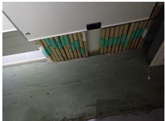
Kuvat 18 a ja b. Alapohjarakenteen sähköläpivienneissä havaittiin laaja-alaisesti ilmatiiveyspuutteita. Läpiviennit olivat tiivistämättömiä ja niistä havaittiin ilmayhteys ryömintätilaan. Sähköläpivientien sijainnit on esitetty liitteessä 3.
