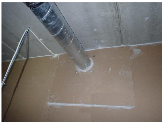
Kuvat 45 a ja b. Ryömintätilan ja viereisen liikuntasalin välinevaraston välisen palokatkoseinän toteutuksessa ei havaittu puutteita.
