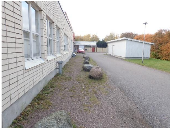
Kuva 7 a ja b. Paikoin rakennuksen vierustalla on alkavaa sammaloitumista ja nurmettumista.
