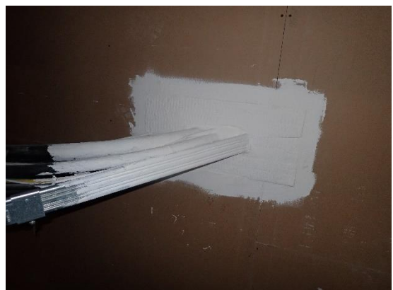
Kuvat 45 a ja b. Ryömintätilan ja viereisen liikuntasalin välinevaraston välisen palokatkoseinän toteutuksessa ei havaittu puutteita.
