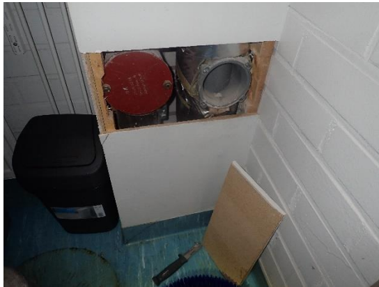
Kuva 95 a ja b. Välipohjien putkiläpivienneissä ei havaittu merkittäviä puutteita. Kuva alkuperäisen osan kotelorakenteesta olevista läpivienneistä.
