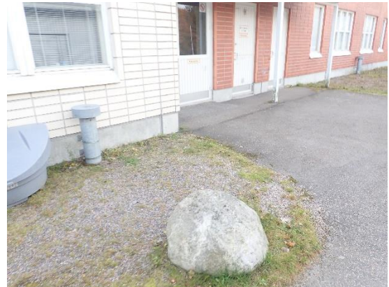
Kuva 7 a ja b. Paikoin rakennuksen vierustalla on alkavaa sammaloitumista ja nurmettumista.
