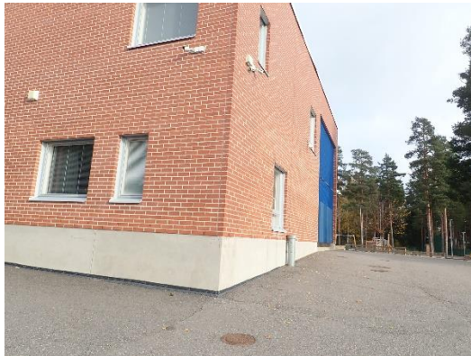
Kuva 6 a ja b. Laajennusosalla on perusmuurilevy näkyvissä asfaltin ja sokkelin välissä.
