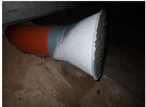
Kuva 37. Ryömintätilan korvausilma on järjestetty tuuletuspaalujen avulla. Ryömintätilassa korvausilmakanavissa havaittiin kosteuden jäätymistä. Lisäksi korvausilmakanavien säleikössä havaittiin runsaasti pölyä ja likaa.
