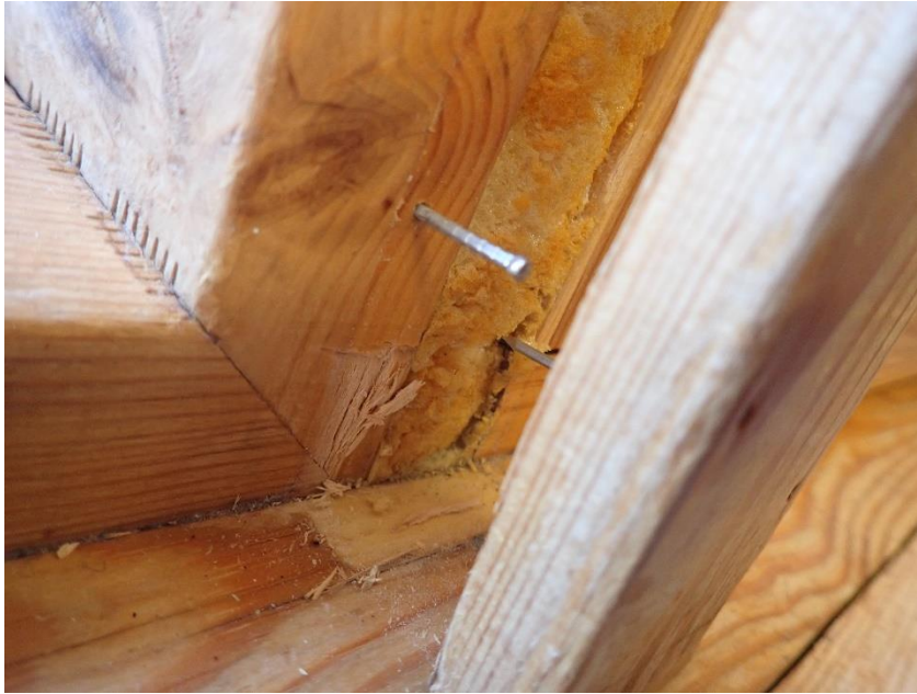
Kuva 37. Ulkoseinän ja ikkunoiden välinen liittymä on osassa ikkunoita tiivistetty polyuretaanivaahdolla. Rakenneliittymä ei ole täysin ilmatiivis.
