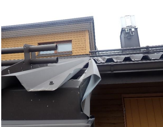
Kuva 42 a ja b. Muutamissa pellityksissä havaittiin puutteita, jotka on suositeltavaa korjata.
