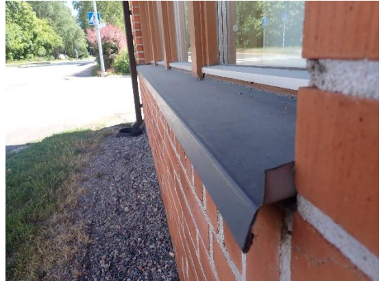
Kuva 4 a ja b. Rakennuksen koillisjulkisivulla nurmialue on erotettu sorakaistalla rakennuksesta.
