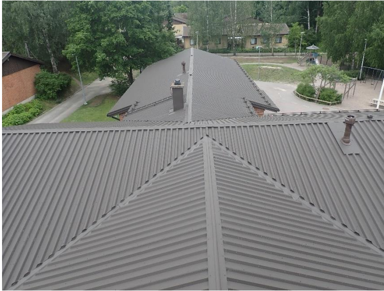
Kuva 40 a ja b. Yleiskuva vesikatolta. Vesikate on uusittu vuonna 2015.
