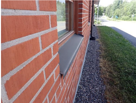
Kuva 4 a ja b. Rakennuksen koillisjulkisivulla nurmialue on erotettu sorakaistalla rakennuksesta.
