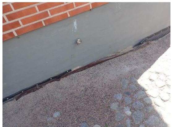
Kuva 6 a ja b. Perusmuurilevystä on irronnut ylälistä.
