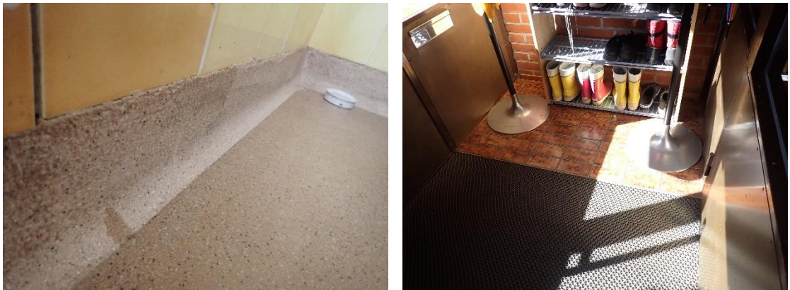
Kuvat 13 a ja b. Keittiössä on käytetty akryylipinnoitetta ja muutamissa tiloissa on keraaminen laatoitus.
