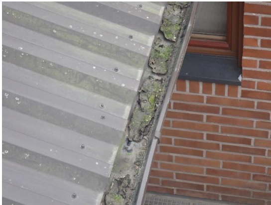
Kuvat 43 a ja b. Räystäskourut useassa kohdassa täynnä roskaa.
