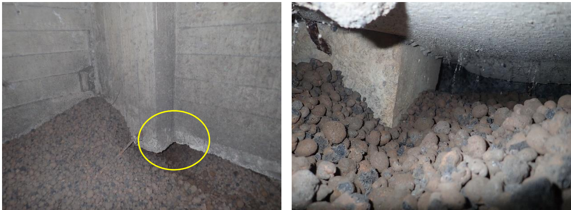
Kuva 24 a ja b. Rakennus on paalutettu. Rakennuksen kulmassa oleva paalu näkyy, kun kevytsoraa kaivaa hieman pois edestä. Betonirakenteissa tai julkisivuissa ei havaittu painumaan viittaavia vaurioita.
