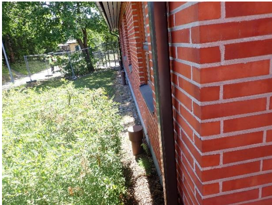
Kuva 5 a ja b. Rakennuksen etelänurkassa nurmialue on erotettu sorakaistalla rakennuksesta. Kasvillisuus on paikoin melko lähellä rakennusta.
