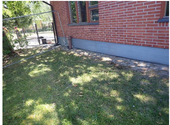
Kuva 5 a ja b. Rakennuksen etelänurkassa nurmialue on erotettu sorakaistalla rakennuksesta. Kasvillisuus on paikoin melko lähellä rakennusta.
