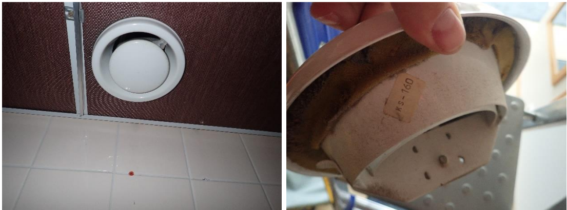
Kuva 59 a ja b. Yleiskuvia poistoilmaventtiileistä. Poistoilmaventtiileissä havaittiin vähäistä pölykertymää.
