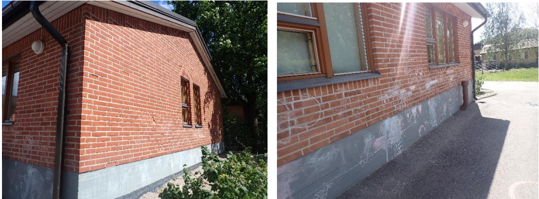
Kuvat 33 a ja b. Yleiskuvia seinien ulkopinnoista.
