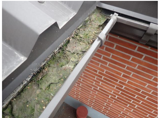
Kuvat 43 a ja b. Räystäskourut useassa kohdassa täynnä roskaa.
