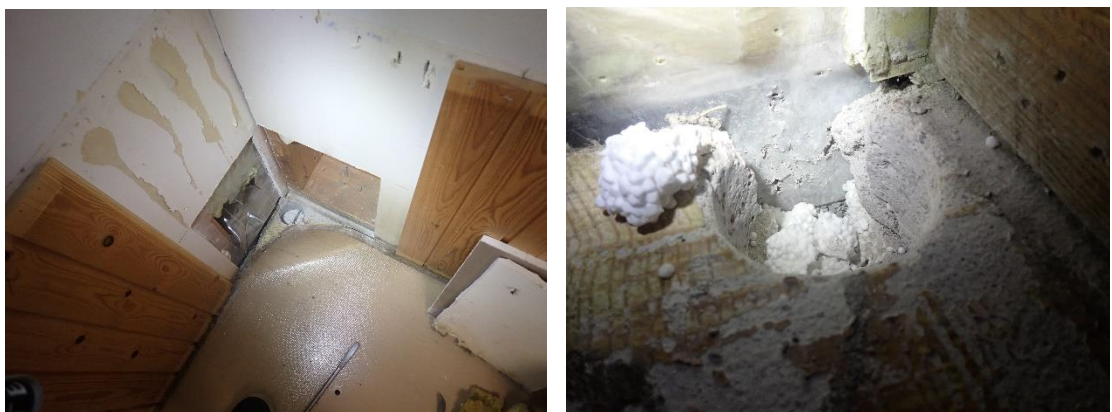
Kuva 26. Yleiskuva lattiaan tehdystä rakennevauksesta (RA4). Rakennevauksen perusteella lattiassa on pintamateriaalin alla suunnitelmien mukaisesti teräsbetoni- ja EPS-eriste.
