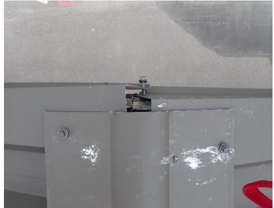
Kuva 42 a ja b. Muutamissa pellityksissä havaittiin puutteita, jotka on suositeltavaa korjata.
