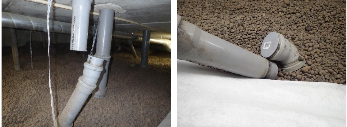
Kuva 25. Viemäreitä on osin poistettu käytöstä. Käytöstä poistetut viemärit on tulpattu käytössä olevaan viemäriin liittyvältä osaltaan.
