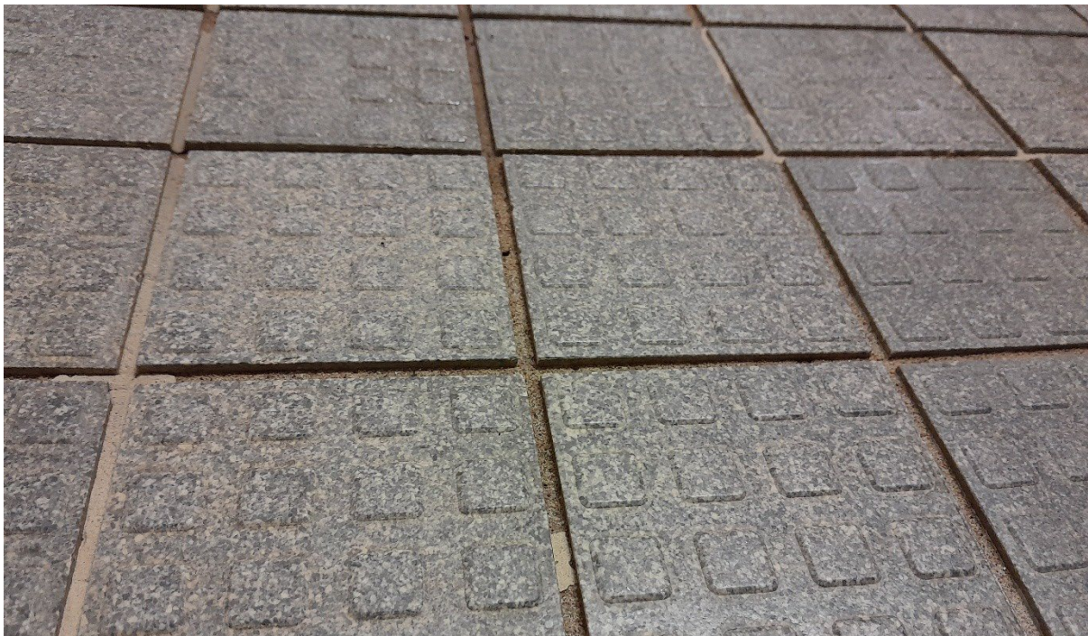
Kuva 4. Syvät laattasaumat keräävät likaa ja kosteutta
