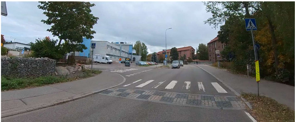
Kuva 11. Korotettu liittymä Ylästöntie - Veromäentie.
