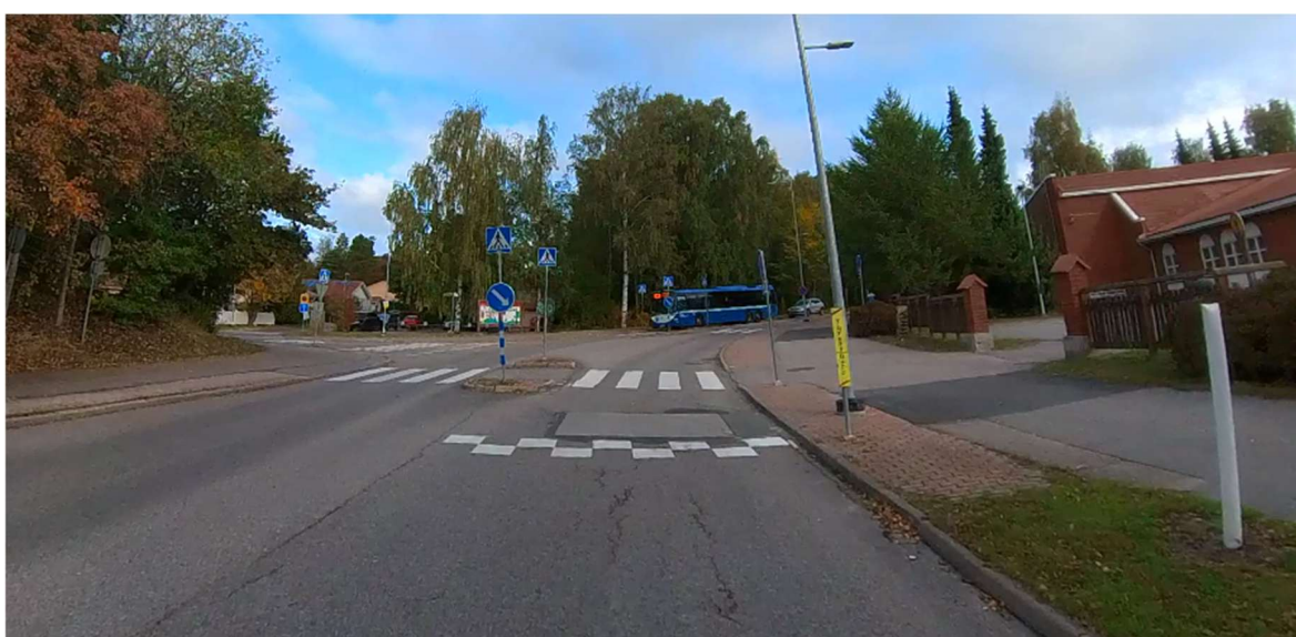
Kuva 8. Epinkoskentien suojatie varustettu keskisaarekkeella ja tyynyhidasteella.
