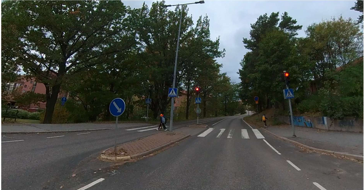
Kuva 9. Liikennevalo-ohjattu suojatie Veromäessä.
