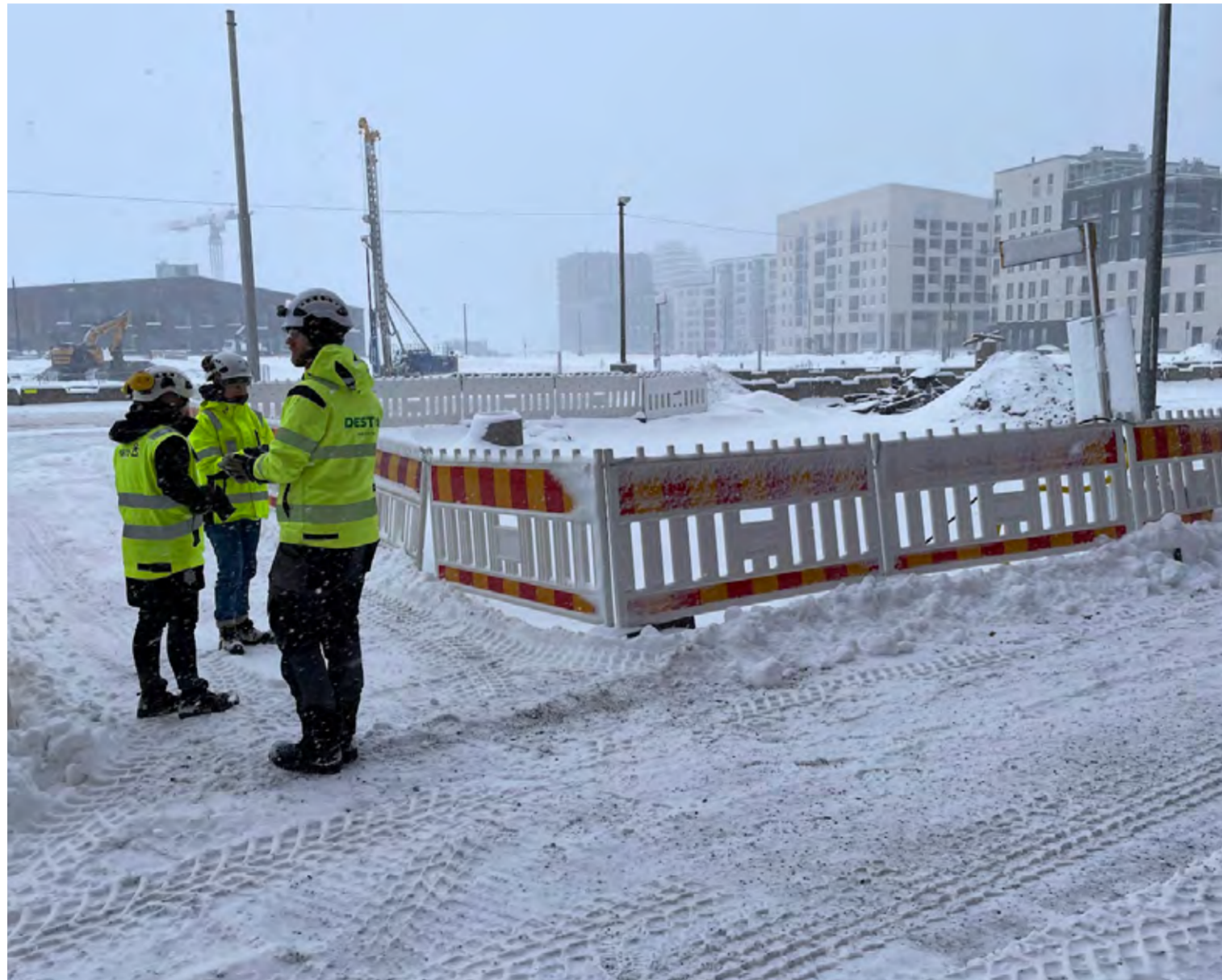
Kuva 6.28 Kalasatamasta Pasilaan -hankkeen työmaa. (Kuva: Ilari Jounila).
