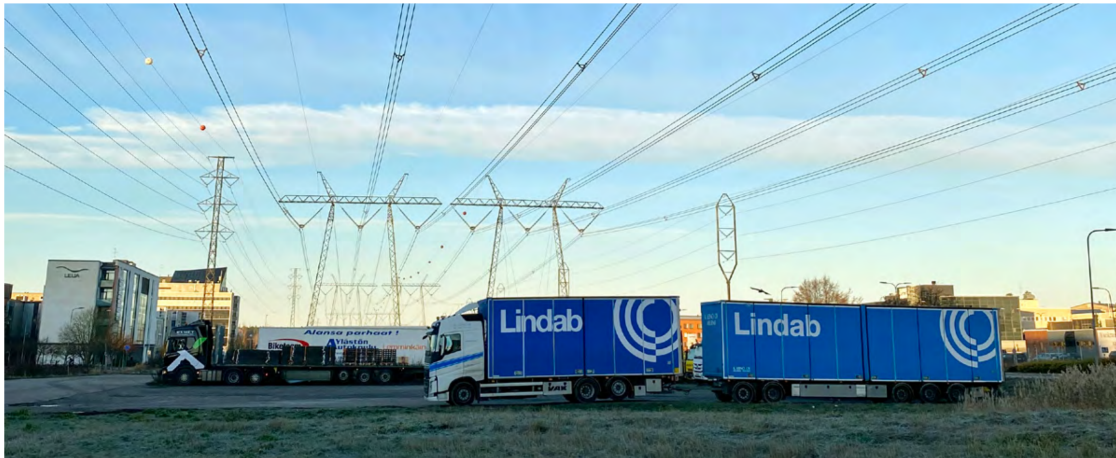
Kuva 4.21 Voimajohdot 400kV Pakkalassa. [Kuva: Tiina Hulkko].
