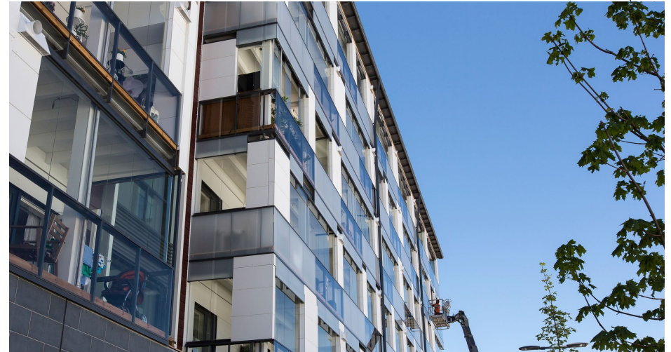
PuuMera, valmistuessaan Euroopan suurin asuinkäyttöön tarkoitettu puukerrostalo, Kivistö 2015. Ensimmäinen kerros betonirakenteinen, ylemmät kerrokset puurakenteisia, puurunkojärjestelmänä käytettiin rankarakenteisia suurelementtiseiniä. Arkkitehtitoimisto Vuorelma Arkkitehdit Oy
