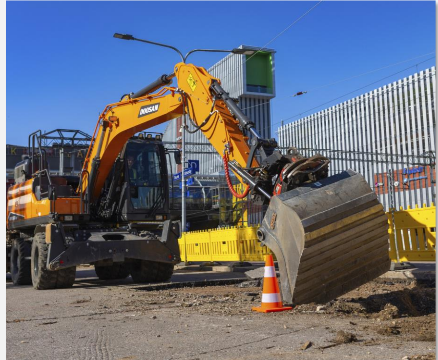
Kuva 30. Vantaan ratikan valmistelevien töiden aloitus Tikkurilan aseman itäpuolella 19.5.2025 (kuva: Joose Zanas).
