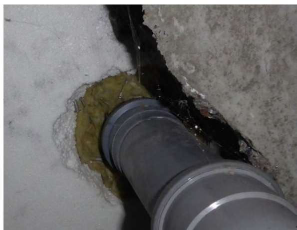
Kuvat 11 ja 12. Esimerkkejä alapohjan läpivientien tiiveystasosta.
