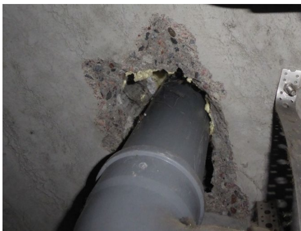
Kuvat 11 ja 12. Esimerkkejä alapohjan läpivientien tiiveystasosta.
