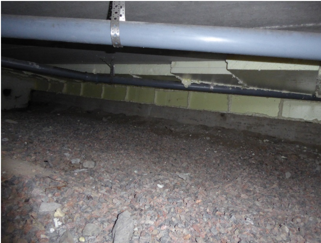
Kuva 7. Yleiskuva ryömintätilasta. Perusmuuri ja alapohjarakenteen alapinta on paikoin eristetty polyuretaanilevyllä.
