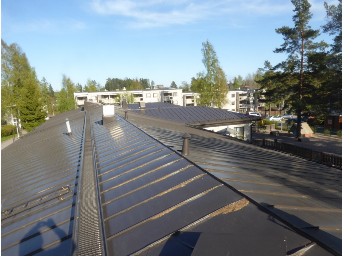
Kuva 24. Yleiskuva rakennuksen vesikatolta. Vesikate on uusittu 2015 ja se oli hyväkuntoinen.
