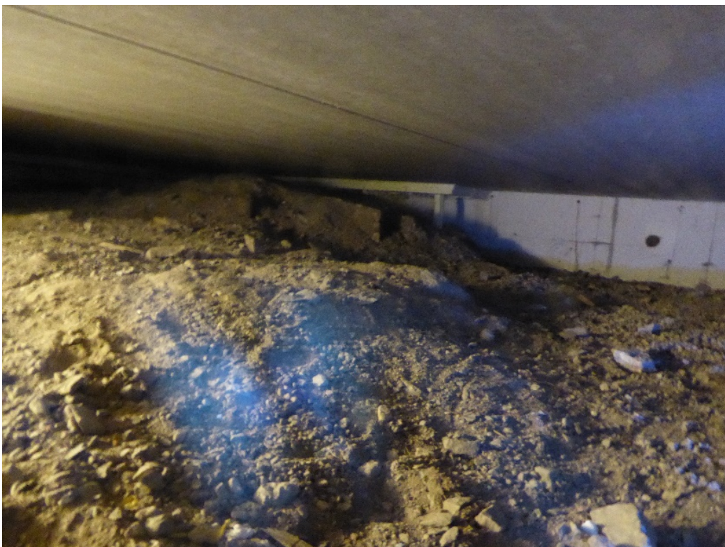
Kuva 8. Tilan L17 kohdalla ryömintätilan korkeus vaihtelee kallion mukaisesti.
