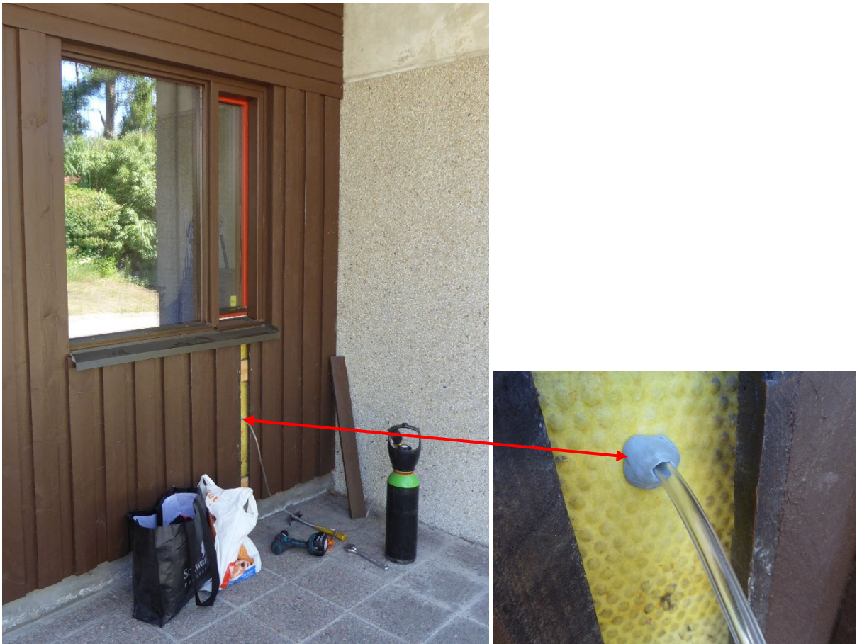
Kuvat 18 ja 19. Merkkiainetta päästettiin seinärakenteen eristetilaan tuulensuojalevyyn tehdyn reiän kautta. Kuva on tilan H11 ulkopuolelta.
