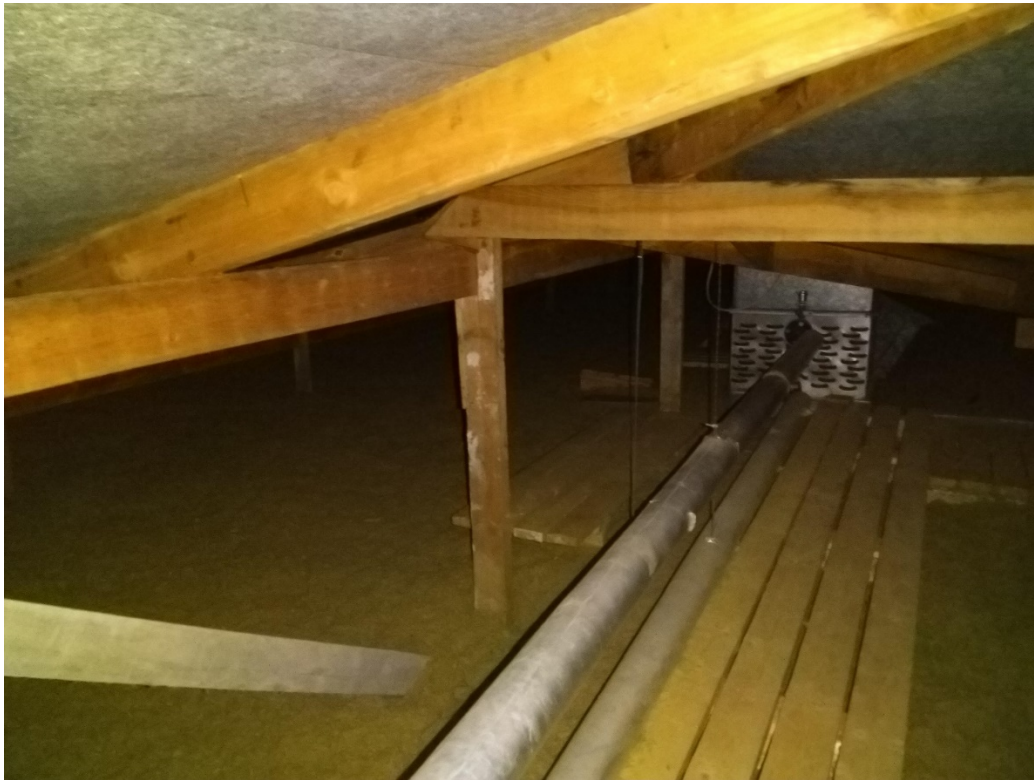
Kuva 25. Yleiskuva yläpohjan ja vesikaton välisestä tuulettuvasta tilasta.
