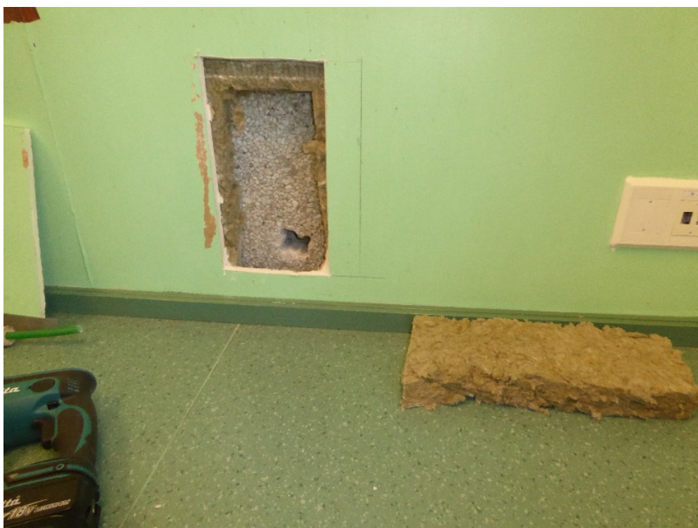
Kuva 20. Tilan L21 väliseinän (entisen ulkoseinän) rakenneavaus. Seinärakenteessa ei havaittu vaurioon viittaavaa hajua eikä värimuunnoksia. Vanhan ulkoseinärakenteen mineraalivillan ulkopinnasta otettiin materiaalinäyte mikrobi tutkimusta varten. Näytteessä ei havaittu viitettä vauriosta.
