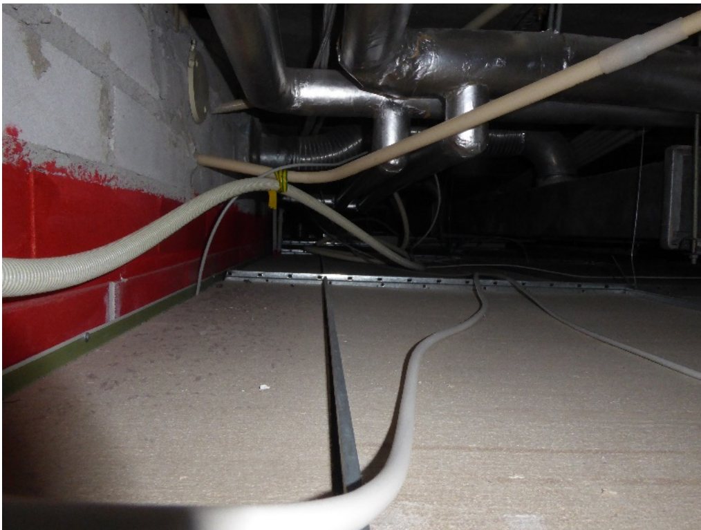
Kuva 21. Esimerkkikuva alaslasketun katon päältä käytävän H27 kohdalta.
