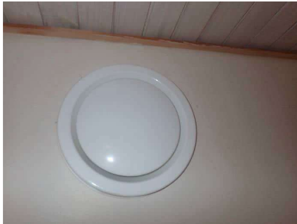
Kuva 46. Yleiskuva poistoilmapäätelaitteesta.
