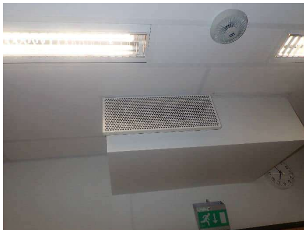
Kuva 47. Yleiskuva poistoilmapäätelaitteesta.
