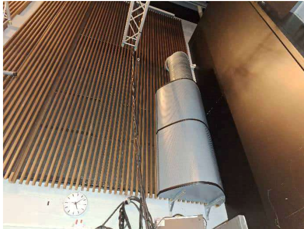
Kuva 45. Yleiskuva auditoriotiloja palvelevasta tuloilman piennopeuspäätelaitteesta.
