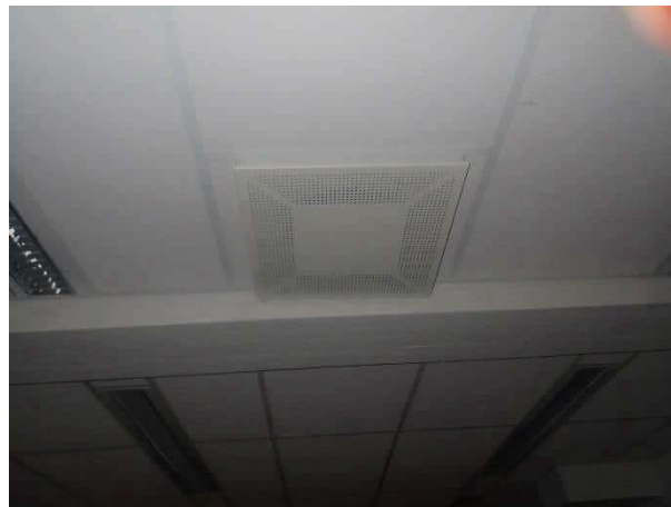
Kuva 51. Katon palkkirakenne estää tuloilmavirran kattavan leviämisen.
