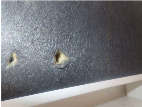
Kuva 48. Suojaamatonta mineraalivillaa kansliatilan tuloilmapäätelaitteessa.
