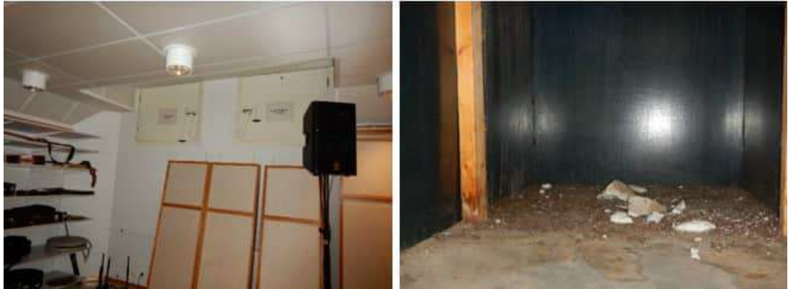
Kuva 36. Tilan 034b kastuneet savunpoistokammiot.
