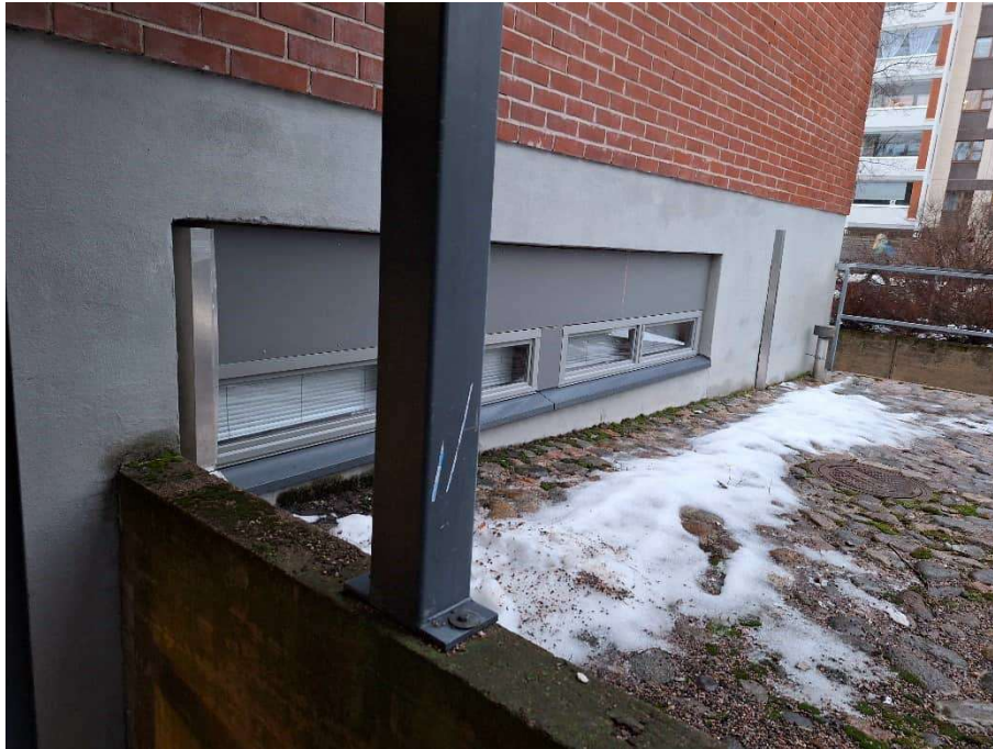
Kuva 16. Kellarin etelänurkkaa, ks. tarkemmin kuvat alla. Kuvassa rakennuksen nurkalla näkyvän tuuletuspaalun ja seinän metallikaistojen funktio ei selvinnyt tutkimuksessa.
