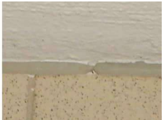
Kuva 69. Kellarin tilasta 046b, jossa kantavien betoniväliseinien alaosissa oli kohonneita pintakosteudenlukemia. Tiiveys kuten kuvassa 66, eli liittymän tiiveys on kohtalaisen hyvä.
