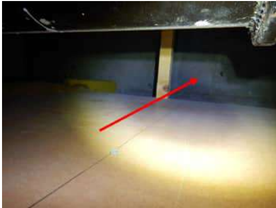
Kuva 41. Tilan 037 viereinen putkitunneli on suorassa ilmayhteydessä tilan 037 alakattotilaan. Vasemmalla näkymä tunnelin yläosaan tunnelin puolelta. Oikealla näkymä tunnelin yläosaan tilan 037 alakattotilasta.
