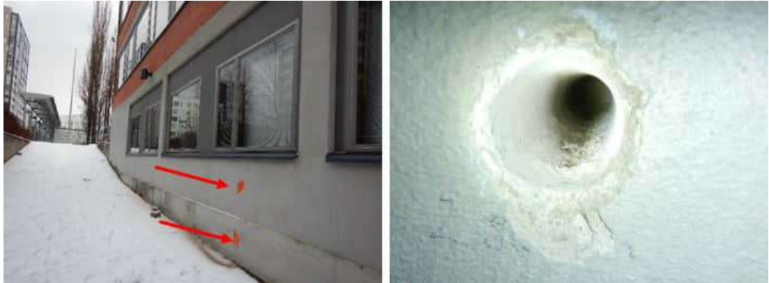
Kuva 58. Luokkien 055-052 ikkunoiden alapuolinen rakenne itäjulkisivulla on rakenneavausten (RA17 ja 18) perusteella suunnitelmien mukaisesti umpinainen betonimuuri, joka on sisäpuolelta eristetty (ei halkaisuja).
