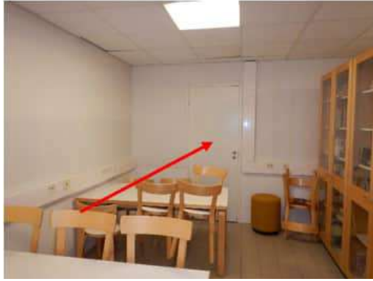
Kuva 40. Havainnot tilan 037 viereisestä putkitunnelista. Kulku tilaan on vasemmassa kuvassa takaseinällä näkyvästä ovesta. Ovi ei ollut ilmatiivis. Tunneli oli epäpuhtas, hajua kulkeutuu tilaan 037 oven ja alakaton kautta. Oikealla kuva tunnelin alkupäästä.
