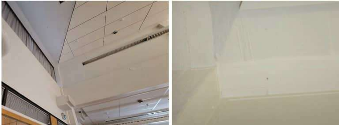
Kuva 134. Katonrajassa olevan levytetyn osuuden liittymät vaikuttivat visuaalisesti tarkastettuna tiiviin näköisiltä.
