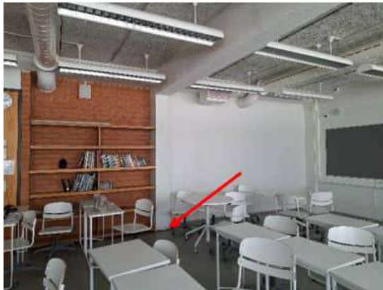
Kuva 106. Luokka 108. Pilarin ja väliseinien liitos lattiaan on epätiivis.
