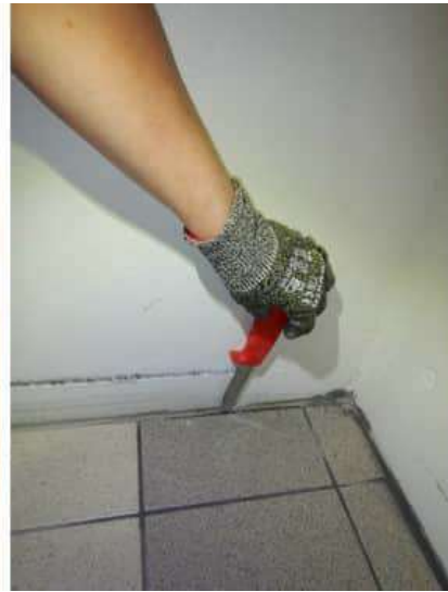
Kuva 75. Tila 055, lattian laatoitusta on uusittu ulkoseinänvierellä. Tiiveys tutkittiin merkkiainekokein, ks. seuraava kappale.
