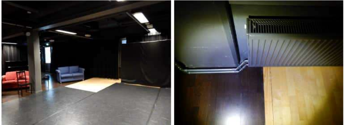
Kuva 113. Tila 123. Lattiassa parketti, joka on uusittu tilan länsipuoliskolla.
