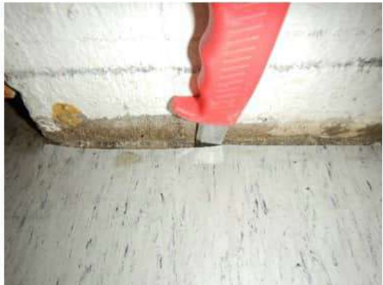
Kuva 106. Luokka 108. Pilarin ja väliseinien liitos lattiaan on epätiivis.
