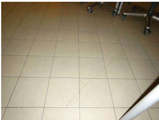
Kuva 72. Kellarin luokan 052 lattiassa oli pitkä halkeama ja vastaavalla alueella julkisivulla sokkeli halki.
