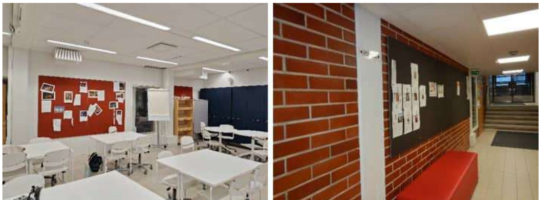
Kuva 50. Linotauluja luokassa 053 ja käytävällä 048. Taulujen lähellä oli havaittavissa linoleumin hajua.
