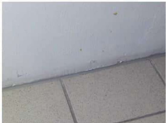
Kuva 70. Kellarin tilat 035, 036 ja 039 ovat tiili-villa-tiili-seinää vasten. Näissäkin seinä-lattialiitos oli toteutettu joustavalla massalla. Tiiveys oli kohtalainen, kalusteiden alla keskimääräistä heikompi.
