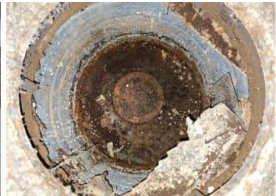
Kuva 68. viemäriputkien puhdistusluukuista ainakin toinen oli täysin avoin alapohjan hiekkakerrokseen.
