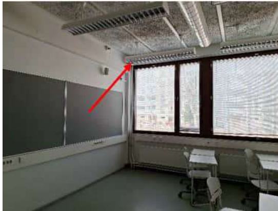
Kuva 105. Luokka 108. Ulkoseinän rakenneliittymät on tiivistetty kuten luokassa 107. Nurkassa oli vähäistä siivousvesivalumaa kattopinnassa putkiläpivientien kohdalla.
