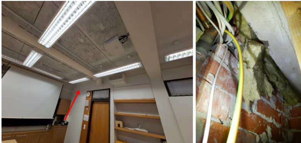
Kuva 97. Luokkien käytävän vastainen väliseinä on levytetty. Rakenteen yläosassa todettiin alkuperäisen näköistä mineraalivillaa.
