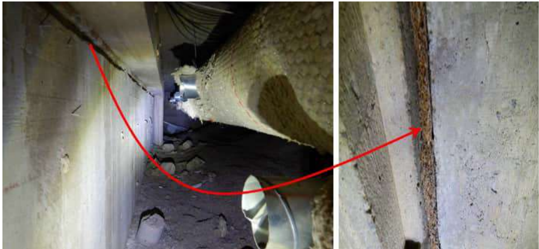
Kuva 47. B-osan alapuolinen alustatila. Kuvassa näkymä tilojen 046 ja 047 vastaiselle puolelle alustatilaa. Kuvassa näkyy eristetty tuloilmakanava, josta ei kuitenkaan tullut ilmaa. Oikealla kuva A- ja B-osien välisestä liikuntasaumasta, jossa on erotuskaistana aistinvaraisesti arvioituna kosteus- mikrobivaurioitunut kuitulevy. Alustatila on ilmayhteydessä 1. kerroksen sisäilmaan liikuntasauaman kautta. Ilmavirran suunta oli tutkimusten aikaan alaspäin.
