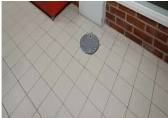
Kuva 68. viemäriputkien puhdistusluukuista ainakin toinen oli täysin avoin alapohjan hiekkakerrokseen.
