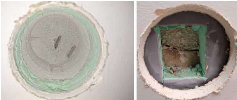
Kuva 59. Luokassa 055 ulkoseinärakenteen sisäpuolinen eristys poikkeaa avauksen (RA-1) perusteella muista tiloista. Sisäpinnassa on kipsilevy, sen takana kova muovieriste ja kevytbetoni (siporex), kuten FCG:n tutkimuksessa on todettu v. 2020 (vasen kuva). Betonipilarin kohdalla (RA-2) ei kuitenkaan ole siporexia, pelkkä muovieriste. Eristelevy on tiivistetty sisäpinnasta kokonaan yli, todennäköisesti TKR-pinnoitteella, tn. tiivistetty sivuista siporexin pintaan (kuva oikealla). Pilarin kohdalla rakenteessa todettiin selvä maakellarimainen haju. Rakenne on merkkiainekokeen perusteella epätiivis sisäilmaan päin.
