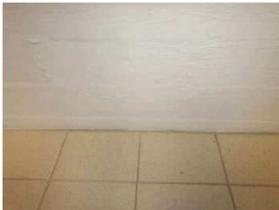
Kuva 69. Kellarin tilasta 046b, jossa kantavien betoniväliseinien alaosissa oli kohonneita pintakosteudenlukemia. Tiiveys kuten kuvassa 66, eli liittymän tiiveys on kohtalaisen hyvä.
