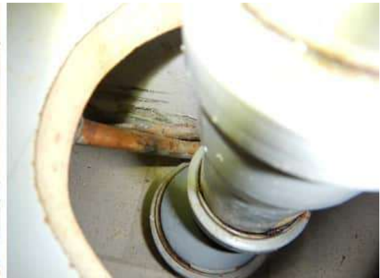
Kuva 76. Kellarin tilassa 030 liittymiä on tiivistetty kattavasti, ks. myös kuvat alla. Vuoden 2020 tutkimuksessa ko. alueella on ollut selviä ilmavuotoja seinä-lattialiittymistä. Keittiökalusteen alla tiivistystä ei ole kuitenkaan tehty (kuva oikealla, näkymä kalustesokkelitilaan). Vasemmassa kuvassa näkyy myös tunnelin 016a epätiivin kulkuaukon sijainti.
