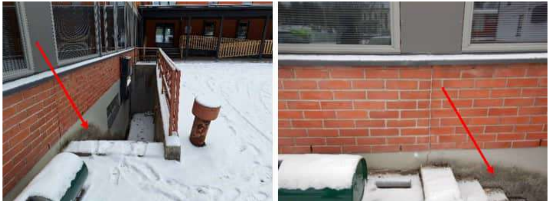
Kuva 13. Länsijulkisivulla tilan 030 kohdalla sokkeliin kohdistuu kosteusrasitusta kellarin portaan liittymässä.
