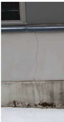
Kuva 72. Kellarin luokan 052 lattiassa oli pitkä halkeama ja vastaavalla alueella julkisivulla sokkeli halki.
