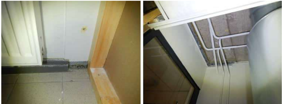
Kuva 77. Tilassa 030 ulkoseinän liittymät lattiaan- ja 1. krs välipohjan alapintaan on tiivistetty Codex-nauhalla pintarakenteiden päälle.
