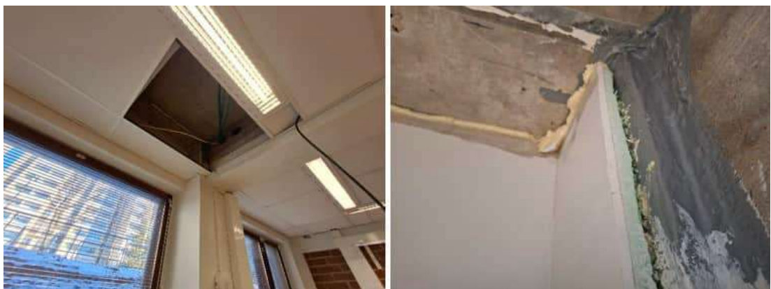
Kuva 85. Kellarin tilasta 055, ulkoseinän yläosan sisäpuolelta mineraalivillalla eristetty osa. Tällä alueella eristeen ulkopuolella on betonikuori. Sisäpuolen toteutus eroaa luokasta 054. Tässä sisäpinta on
