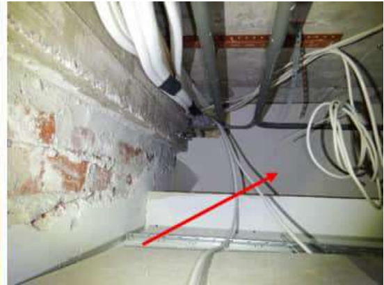
Kuva 41. Tilan 037 viereinen putkitunneli on suorassa ilmayhteydessä tilan 037 alakattotilaan. Vasemmalla näkymä tunnelin yläosaan tunnelin puolelta. Oikealla näkymä tunnelin yläosaan tilan 037 alakattotilasta.
