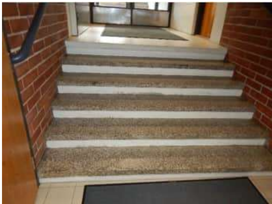
Kuva 71. Kellarin käytävä 048 porrashuoneen H päädyssä. Porrasaskelmien kohdalla ei ole joustavaa tiivistysmassaa pystypinnalla. Tiiveys on huonompi kuin liittymissä keskimäärin.
