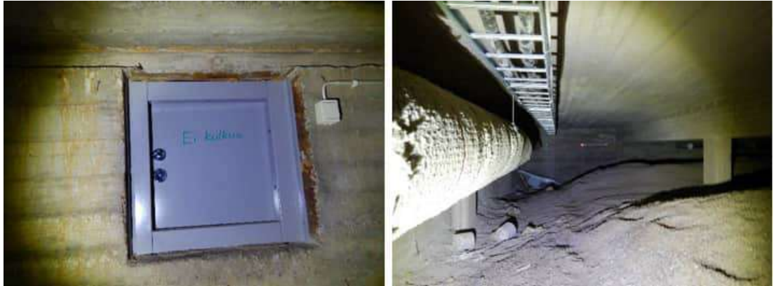
Kuva 48. B-osan alapuoliseen alustatilaan on toinenkin, uudempi, mutta käytöstä poistettu kulkutie. Sijainti tiloissa ei selvinnyt. Oikealla näkymä tunnelin 016a vastaiselle puolelle alustatilaa.
