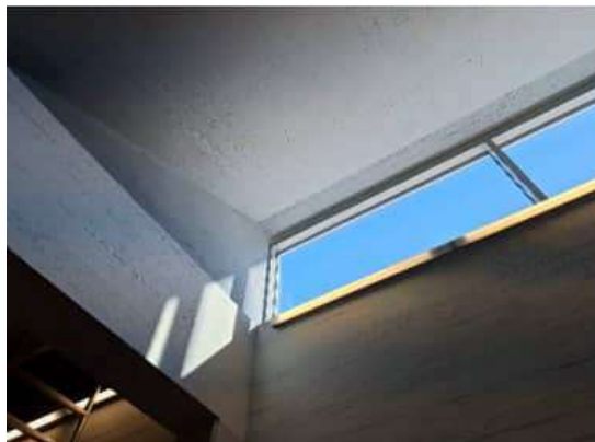
Kuva 140. Käytävien yläosissa on katonrajassa ikkunat, joiden liittymät on tiivistetty nauhalla, vrt. kohta 8.5. Tiivistyksissä on paljon poimuja ja ne ovat paikoittain selvästi epätiivisiä.
