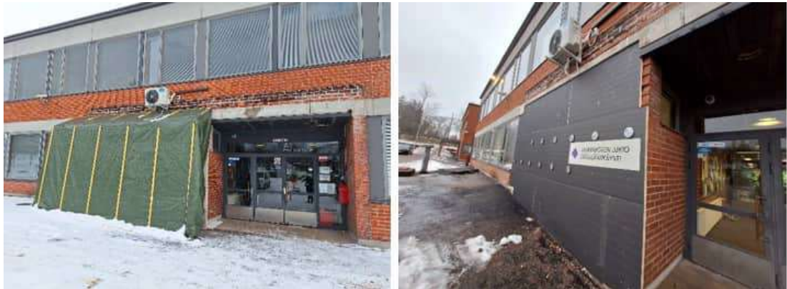
Kuva 21. Siipirakennuksen purku, aukko suojattu asianmukaisesti väliaikaisesti.
