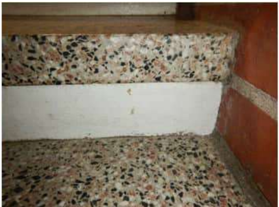
Kuva 71. Kellarin käytävä 048 porrashuoneen H päädyssä. Porrasaskelmien kohdalla ei ole joustavaa tiivistysmassaa pystypinnalla. Tiiveys on huonompi kuin liittymissä keskimäärin.
