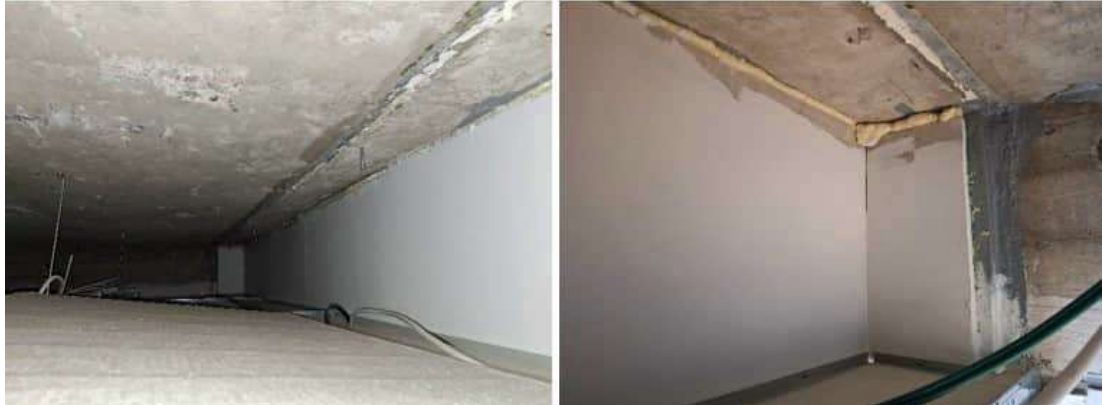
Kuva 86. Kellarin tilasta 055, ulkoseinän yläosan sisäpuolelta mineraalivillalla eristetty osa, jatkuu.
