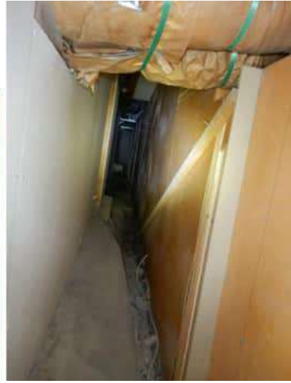
Kuva 40. Havainnot tilan 037 viereisestä putkitunnelista. Kulku tilaan on vasemmassa kuvassa takaseinällä näkyvästä ovesta. Ovi ei ollut ilmatiivis. Tunneli oli epäpuhtas, hajua kulkeutuu tilaan 037 oven ja alakaton kautta. Oikealla kuva tunnelin alkupäästä.
