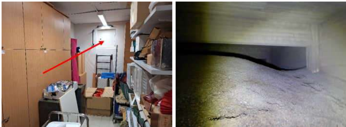
Kuva 45. B-osan alapuolinen alustatila. Kulku tilaan luukusta varastotilassa 056. Kuvassa oikealla näkymä tunnelin 016b vastaiselle puolelle alustatilaa. Pohjalla on riittävä sepelöinti ja tila vaikutti kuivalta.
