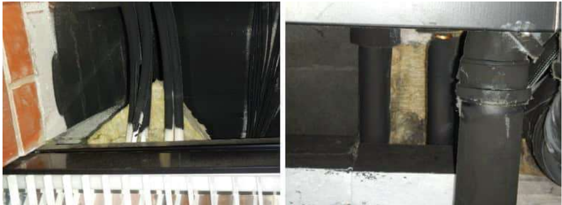
Kuva 123. Käytävien kattopinnoissa on paljon avointa villapintaa akustiikkalevytyksissä ja taloteknisten asennusten yhteydessä.
