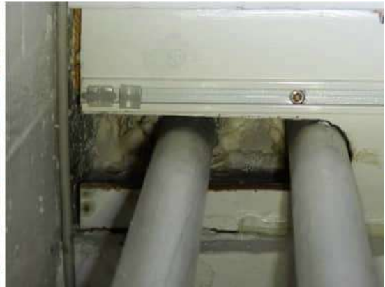
Kuva 105. Luokka 108. Ulkoseinän rakenneliittymät on tiivistetty kuten luokassa 107. Nurkassa oli vähäistä siivousvesivalumaa kattopinnassa putkiläpivientien kohdalla.
