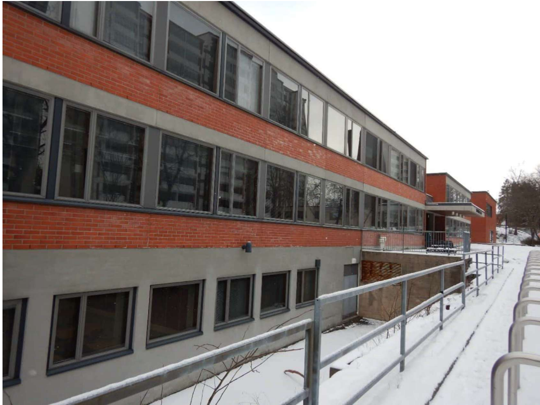
Kuva 107. Maanpinnan taso luokkien ulkopuolella vaihtuu luokan 111 kohdalla. Luokka 112 sijaitsee taaempänä katoksen vieressä. A- ja B-osan välinen liikuntasäula on tasoeron kohdalla.
