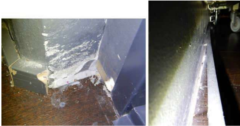
Kuva 114. Tila 123. Lattiarakenne laatan päälle koolattu puukansi. Puukannen liitokset on tiivistetty ulkoseinälinjalla.
