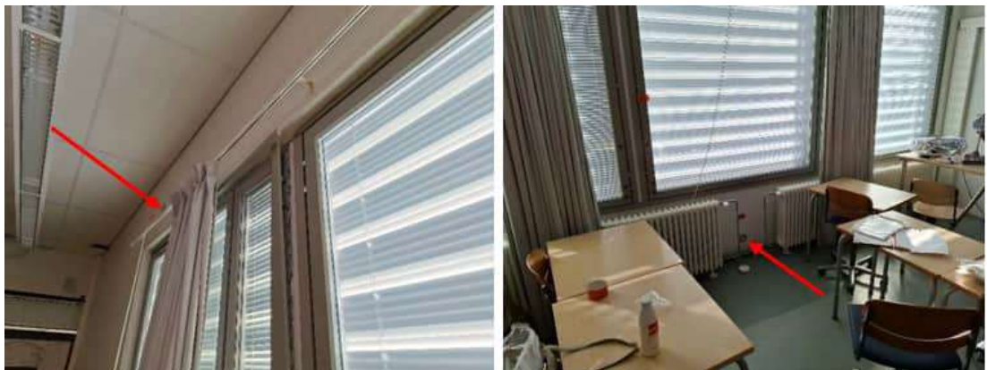
Kuva 135. Eteläjulkisivun ulkoseinän rakenneavaukset RA-30 (kuva vasemmalla) ja RA-30 (kuva oikealla) luokassa 208.
