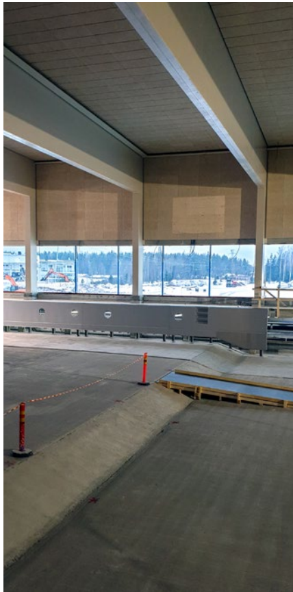
Elmon uimahallin sisäkatto on jo asennettu. 50 metrin allas saa teräspinnan.
