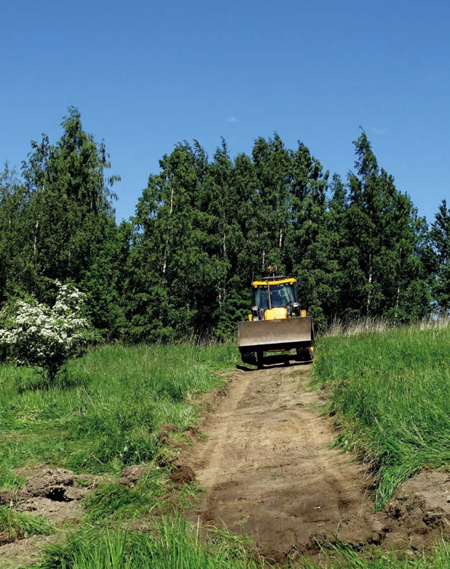
Kuva 27. Luontopolun pohjan tekemisessä ja haitallisten pensaiden poistossa saatiin suurenmoista ja merkittävää apua Katujen kunnossapitoyksiköltä jo keväällä ja syksyllä 2020. Kaivuriguru Jouni Aalto vauhdissa. – 11.6.2020.
