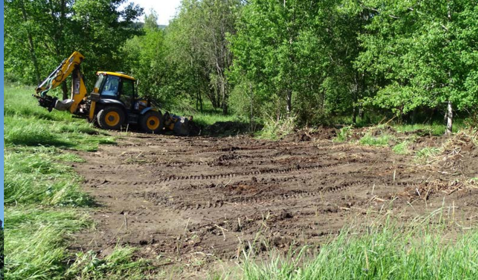
Kuva 28. Katujen kunnossapito teki mahtavaa työtä kesien 2020 ja 2022 aikana myös haitallisten vieraslajien poistamiseksi alueelta. Japanintatarta ei kuitenkaan onnistuttu hävittämään edes kaivurilla, vaan tataret vesoivat nopeasti takaisin tuohon samaan kohtaan. – 11.6.2020.
