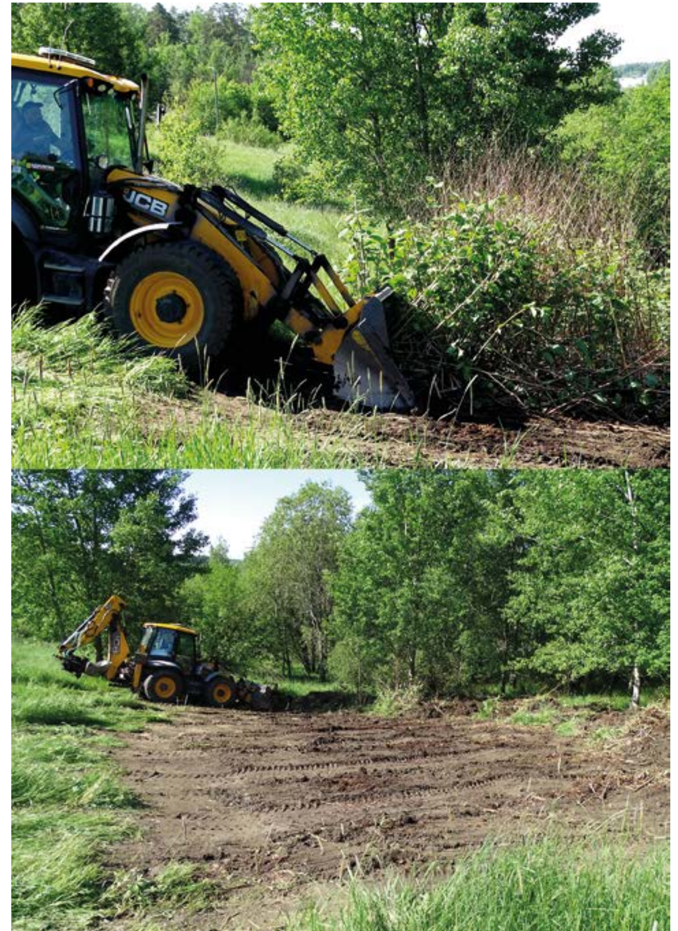
Kuvat 15, 16. Japanintatarkasvustoja, kurturuusuja ja norjanangervopensaita poistettiin kaivurilla mukavassa kevähelteessä. - 11.6.2020
