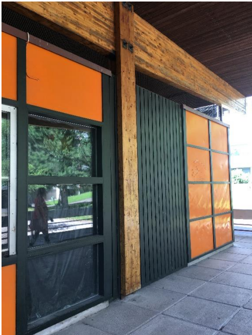
Kioskijulkisivun ja liimapuurakenteiden yksityiskohdat.
