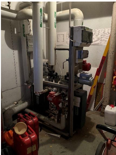
Kuva 2. Lämmönjakokeskusyksikkö
