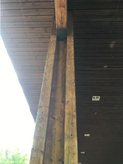
Kioskien yläpuolisen katoksen säilytettävä liimapuupilari ja -palkki.
