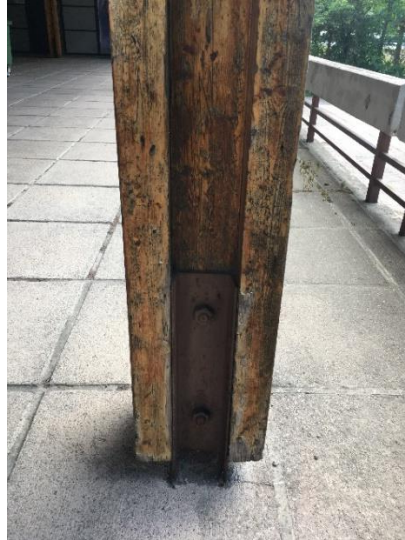
Liimapuupilarin alapään kiinnitysliitos.
