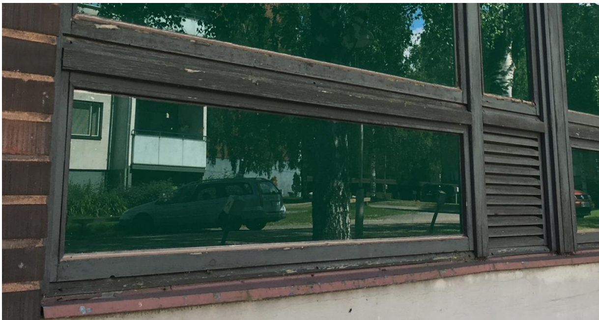
Länsijulkisivun tummanruskeat puikkunat
