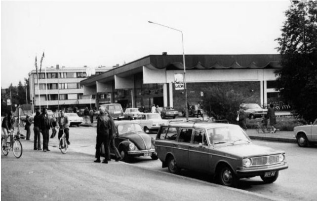
Tikkurilan Prisman tieltä purettu Sokoksen myymälärakennus, Pauli Suhonen 1970 Palkkirakenne, matala tasakatto ja tunnelimaisuus
