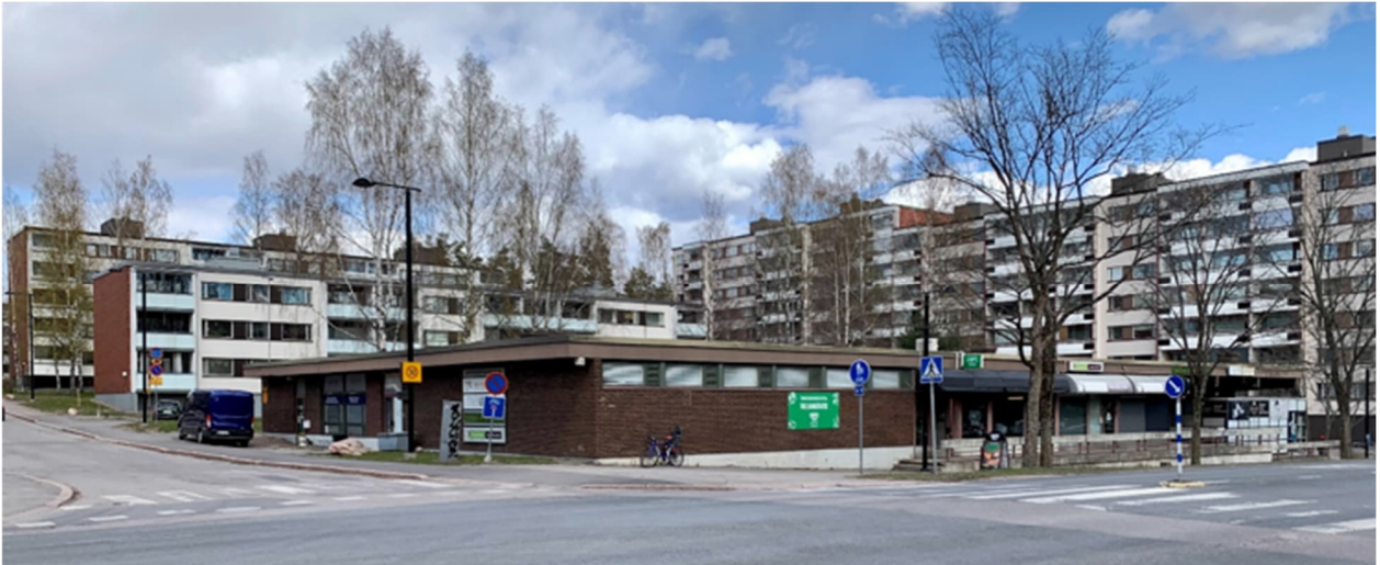
Ostoskeskus Uomatien suuntaan. Vain osa julkisivusta on avointa liiketilaa.
