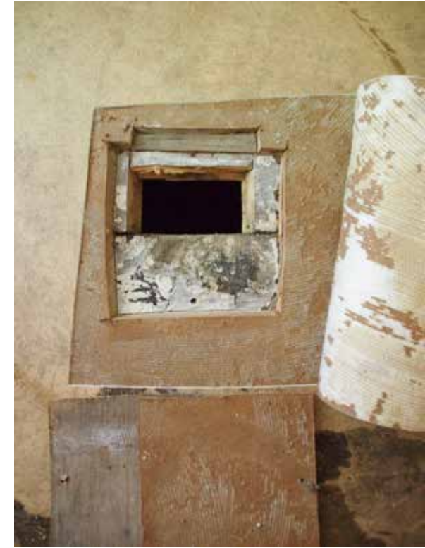
5. Kuistin lattian rakenneavaus
