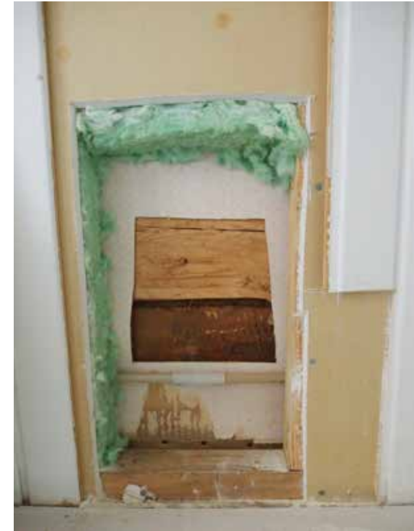
2. Alkuperäisen väliseinän rakenneavaus
