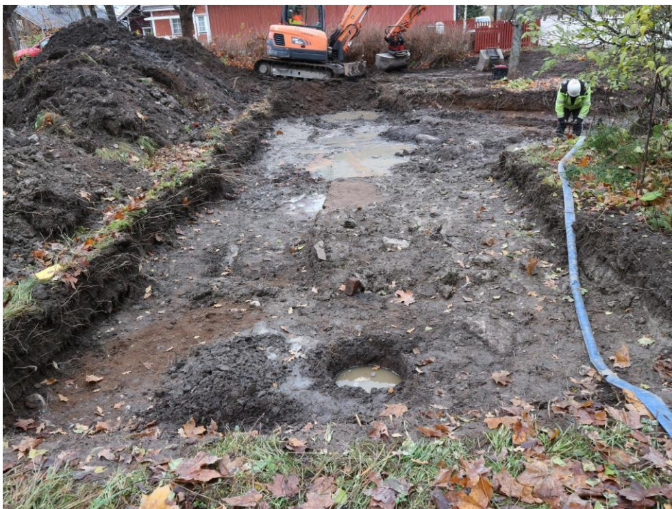
Kuva 15. ARB2020_4_22: Kaivausalueen länsipuoli ennen täyttämistä. Taustalla kone täyttää pohjoispäätä. Kuvattu etelästä. Kuvaja Elina Saloranta.
