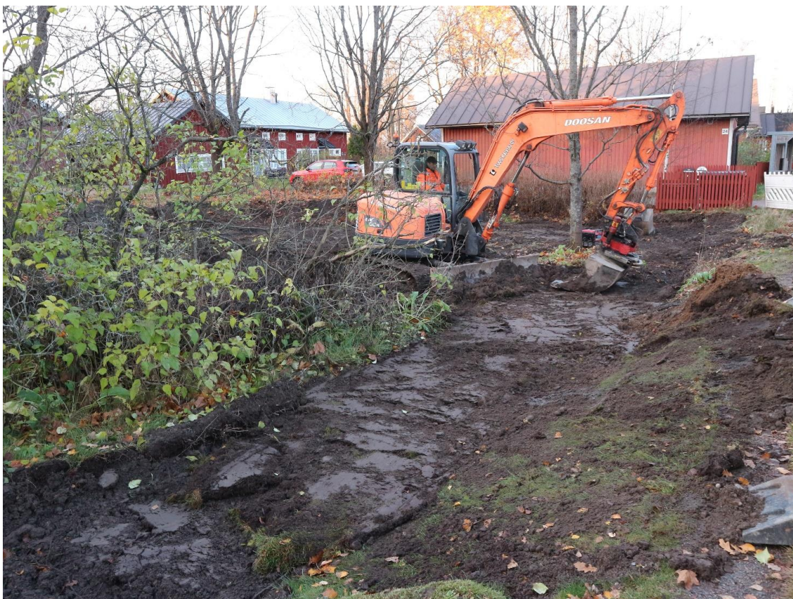
Kuva 17. ARB2020_4_28. Työkuva. Kaivinkone täyttää kaivausalueutta. Kuvaaja Elina Saloranta.
