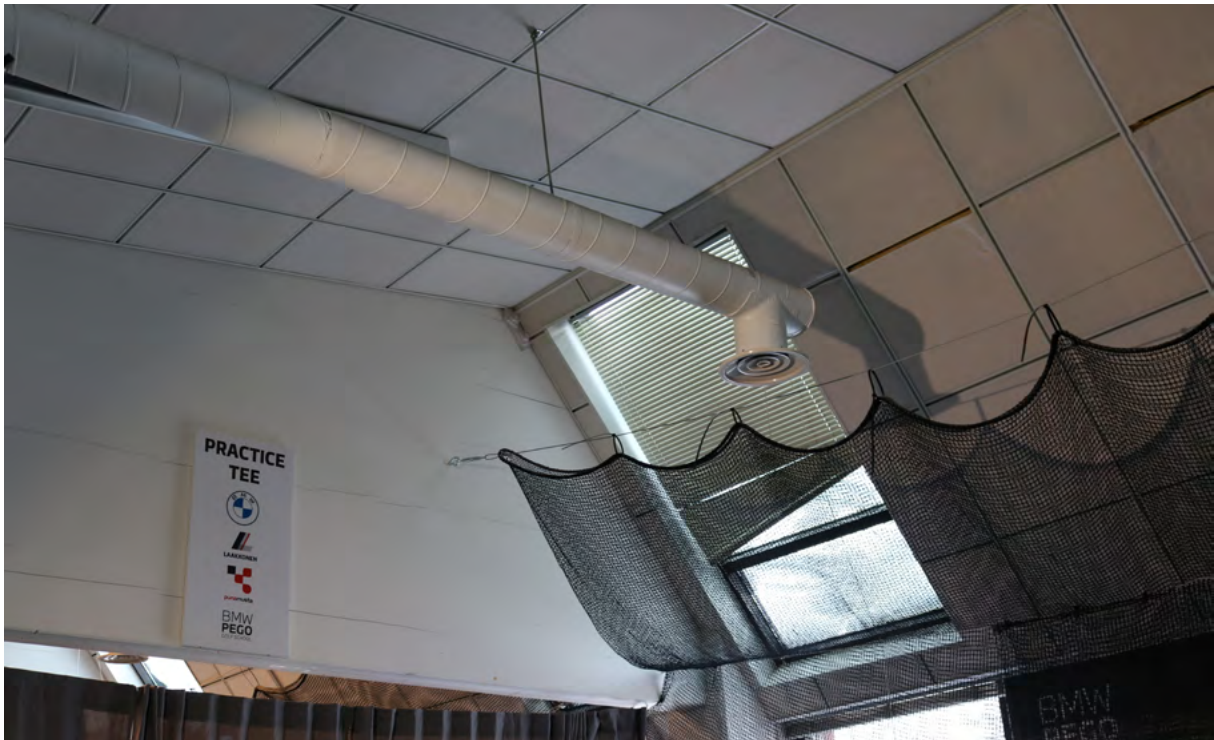
kuva 5.37 Ylimmän kerroksen toimistotilan vinoja kattopintoja.
