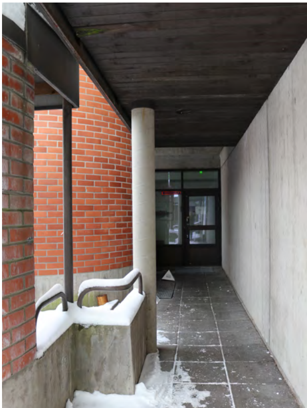
kuva 5.19 Kuva kellarikerroksesta porrastornin edustalta, luhtikäytävän alta. Ovesta on kulku yhteiskäyttöisiin sauna- ja neuvottelutiloihin.
