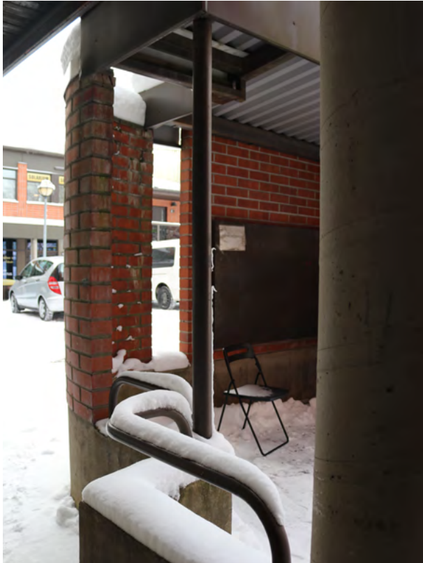
kuva 5.18 Yksityiskohta porrastornin edustalta. Pyörille tarkoitettu osa on käytössä tupakointikatoksena.
