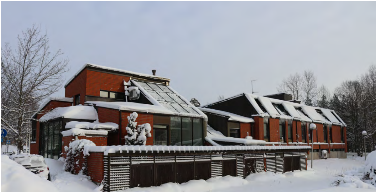
kuva 5.11 Rakennuksen lounaisjulkisivua. Asunto-osa etualalla.
