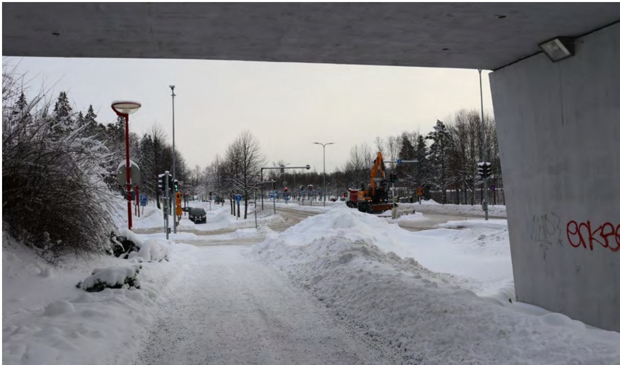
kuva 5.1 Martinlaaksontien näkymä junaradan sillan alta. Bussiaseman liittymä etualalla, taaempaan Louhelantien liittymän liikenneympyrä ja oikealla puiden takana Vihertien huoltoasema ja Vihertie 44-46 rakennus.
