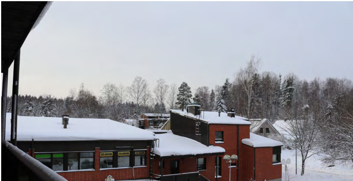
kuva 5.13 Kuva 1. kerroksen luhtikäytävältä kohti asunto-osaa.
