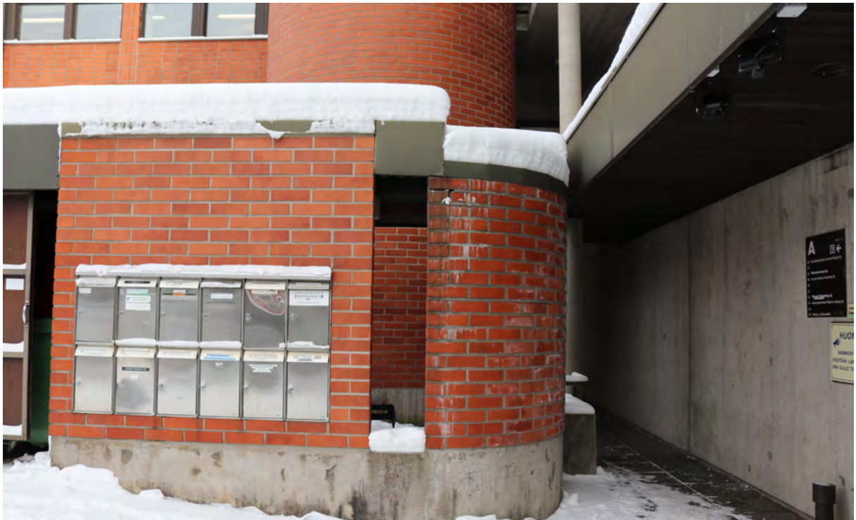
kuva 5.17 Porrastornin kyljessä on muurattu lisäosa, jossa on ollut jätetila, postilaatikot ja pyöräkatos.
