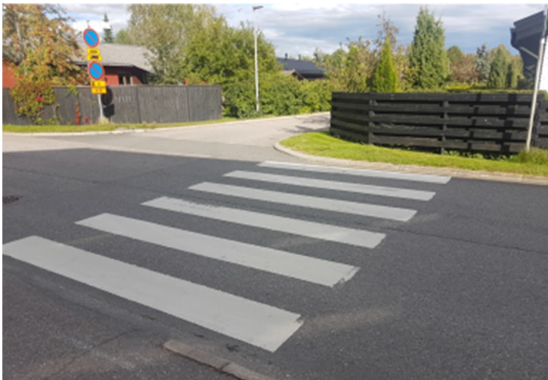
Kuva 4. Viherkummun tien suojatie päättyessä 5 m leveään Auertien asukkaiden aitaan.
