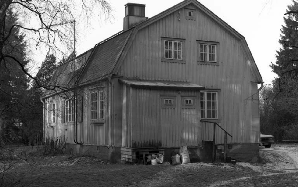
Ennen peruskorjausta itäpäädyssä oli piianporras. Kuva 12/1991 VKM Anni Lehtimäki,
