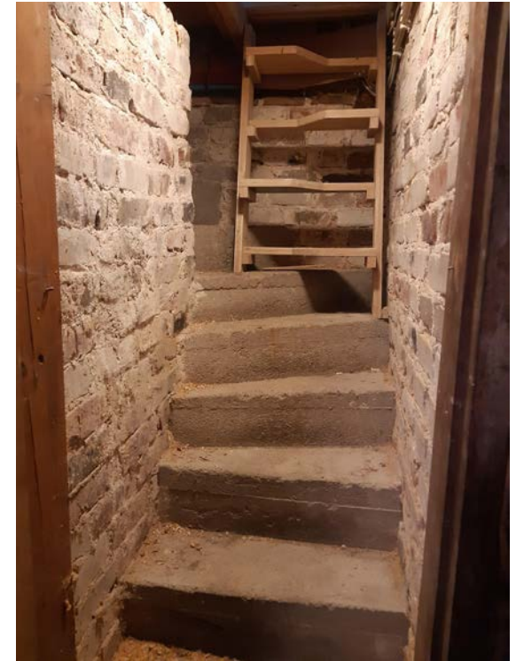
Perunakellarin betoniporras. Kellarin ovi on tummanruskeaksi kuultokäsitelty puupeiliovi. 08/2024 AK
