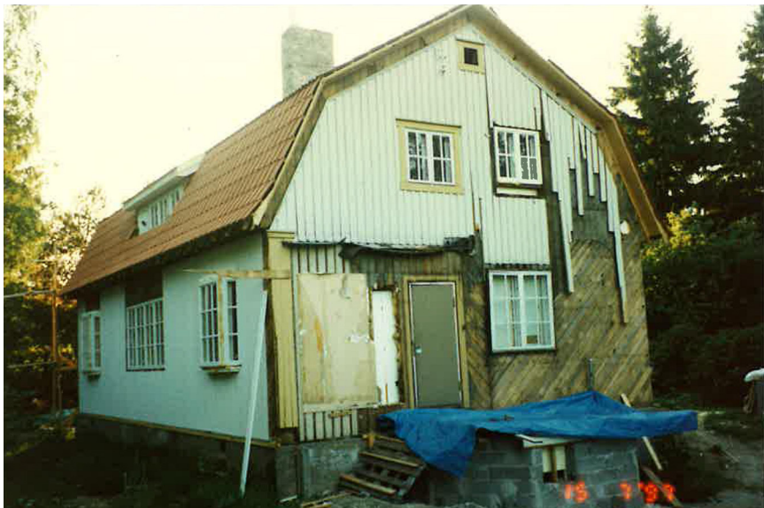
Saarelan talon itäpääty. Piianporras on purettu ja uudelle lasikuistille on muurattu perustus. Vesikate on uusittu tiilikatteena. 07/1997 EV
