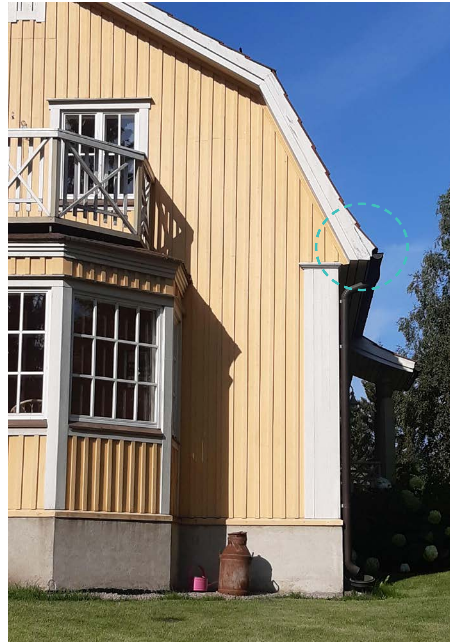
Esko Vattulainen kertoi, että peruskorjauksessa katon räystäälle lisättiin puukappale, jolla luotiin laappeeseen pääpiirustuksissa esitettyä kaarevuutta. Kuva 08/2024 AK
