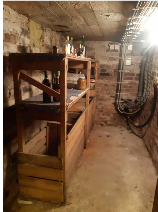
Perunakellari 1.kerroksen alla. 08/2024 AK
