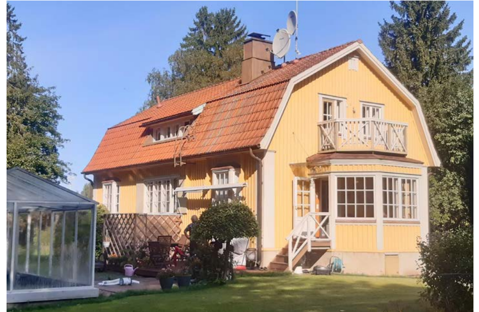
Peruskorjauksessa itäpäätyyn rakennettiin lasikuisti ja parveke. Kuva 08/2024 AK
