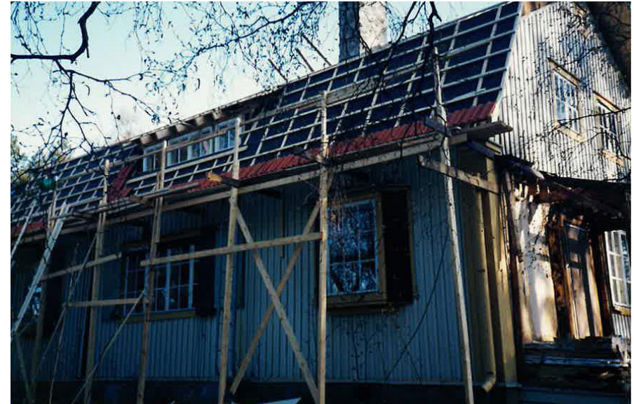
Uusi aluskate ja uudet (Domus) ikkunat asennettuna. Kuva 05/1997 EV
