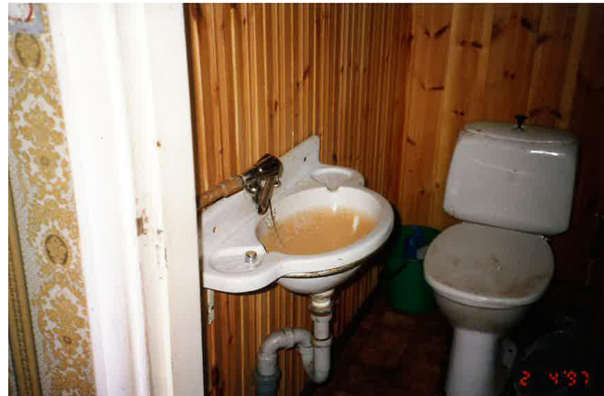
Wc oli alkuperäisellä paikallaan, pinnat oli uusittu. 04/1997 EV
