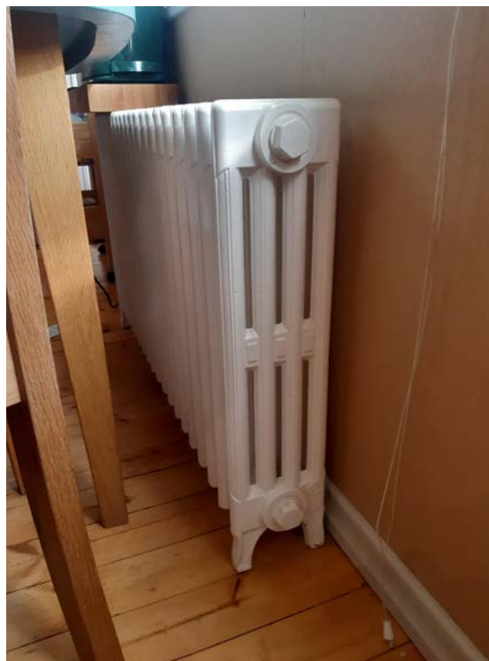
Talteenotettu ja kunnostettu radiaattori 08/2024 AK
