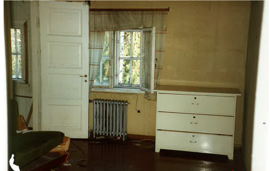
Kuva yläkerrasta itäpäädyn makuuhuoneista. Peruskorjauksessa Ikkuna purettiin ja sen paikalle tehtiin parvekkeen ovi. 04/1997 EV
