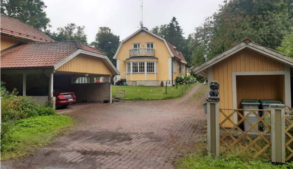
Näkymä Virnakujalta Saarelan talolle. Oikealla jätekatos (C) ja vasemmalla autotalli (B). Maasto nousee kohti päärakennusta. Kuva 08/2024
