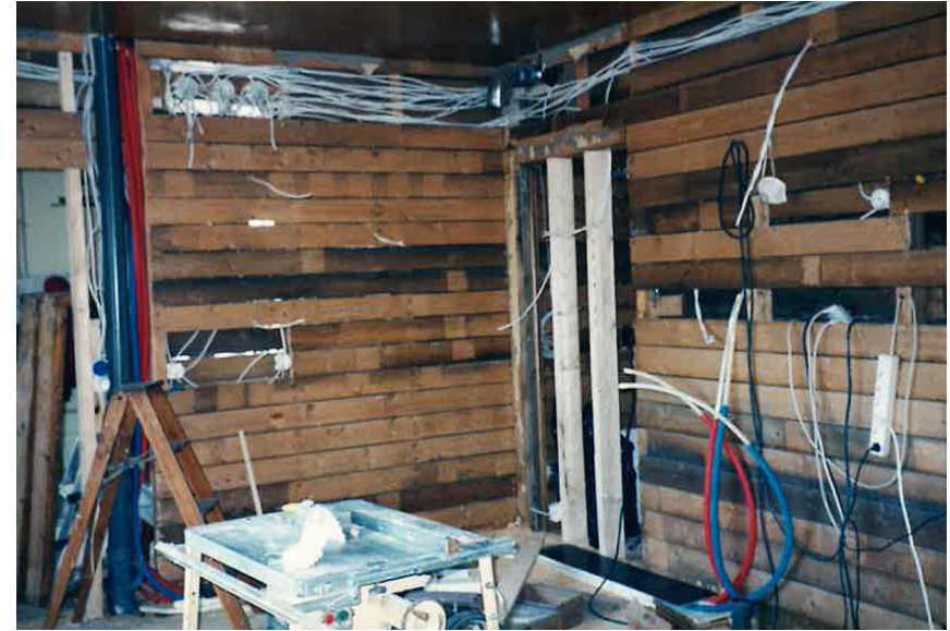
Sähkötöiden vuoksi kaikki pintarakenteet purettiin. Kuvassa on ruokasali, joka muutettiin keittiöksi. Oviaukko aulaan ummistettiin. Kuva 04/1997 EV
