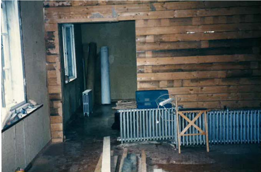
Ruokasalin itäseinä, oviaukkoa suurennettiin. Kaikki radiaattorit otettiin talteen kunnostusta varten. Kuva 04/1997 EV
