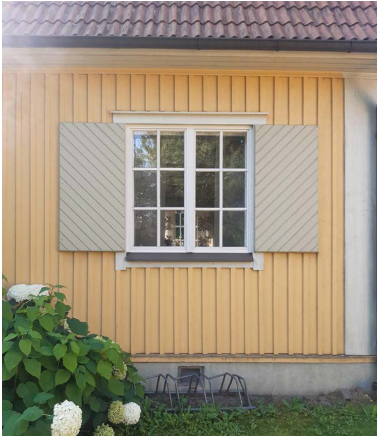
Pohjoisjulkisivun ikkuna. Kuva 08/2024 AK
