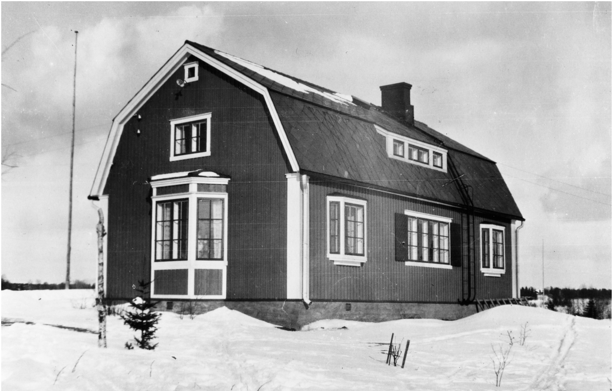
Saarelan talo 19.3.1932, kuvassa rakennus on todennäköisesti vielä alkuperäisessä asussaan. Kuva: VKM, kuvaaja tuntematon.
