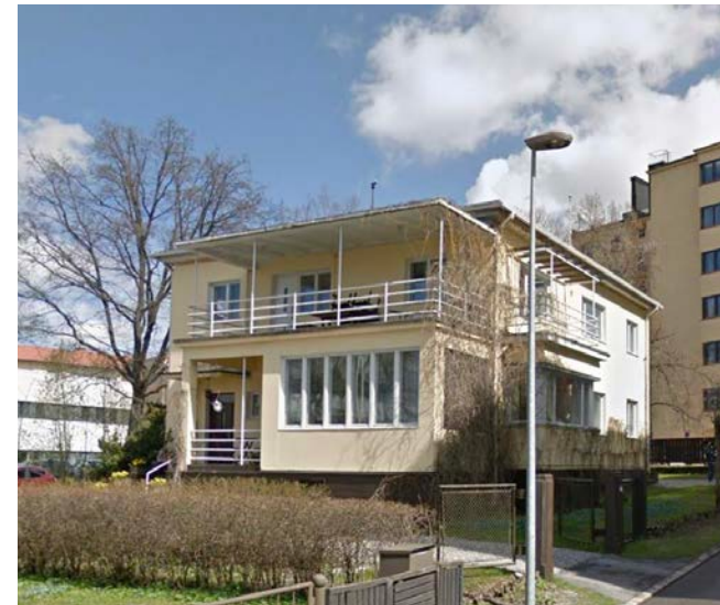
Amerikan katu 6, Kuva: Google street view toukokuu 2017
