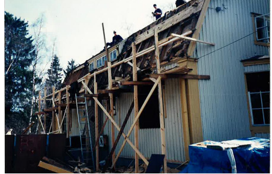
Peruskorjauksessa huopapalakate uusittiin. Kuva 05/1997 EV
