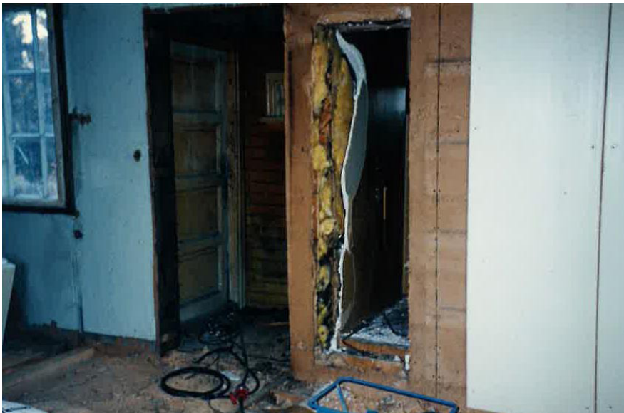
Keittiön ikkuna ja piianportaan ulko-ovi. Keittiöön aukeavat komerot ulkoseinällä ovat todennäköisesti olleet kylmäkomeroita. Kuva 05/1997 EV
