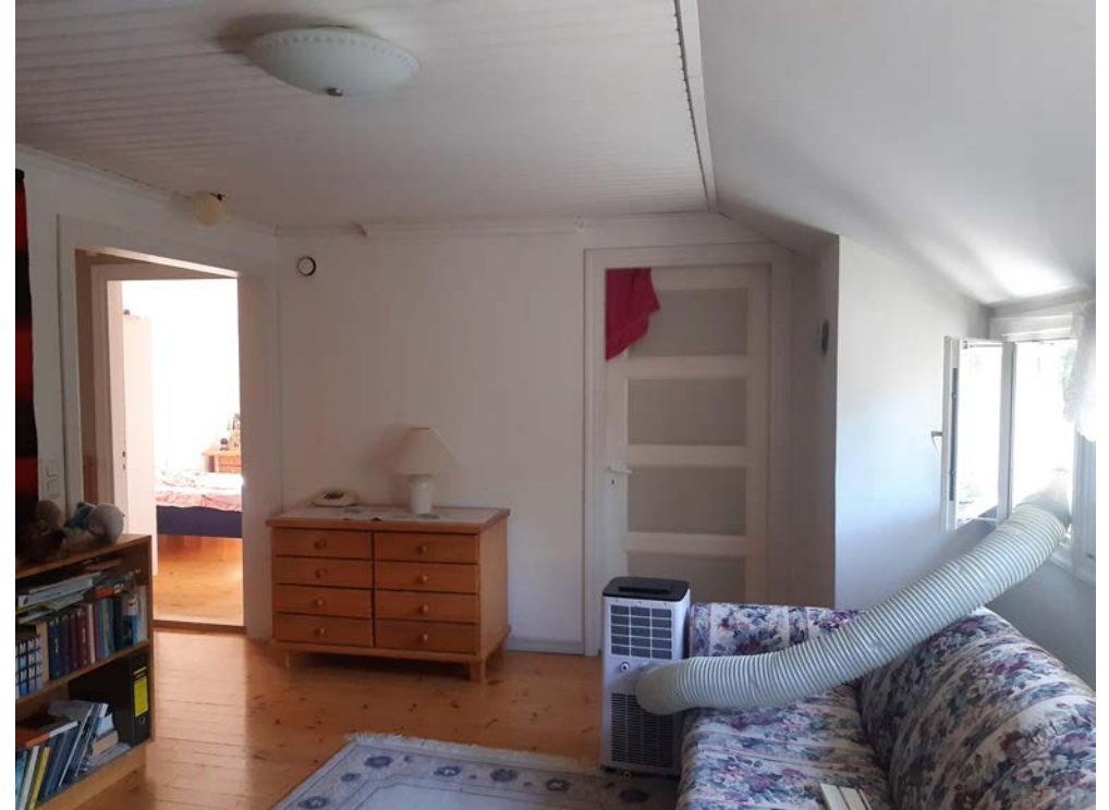
Yläkerran halli, sisäkatto uusittiin valkoiseksi maalatusta puupanelista, kuten se oli ollut ennen korjausta. Kuva 08/2024 AK.
