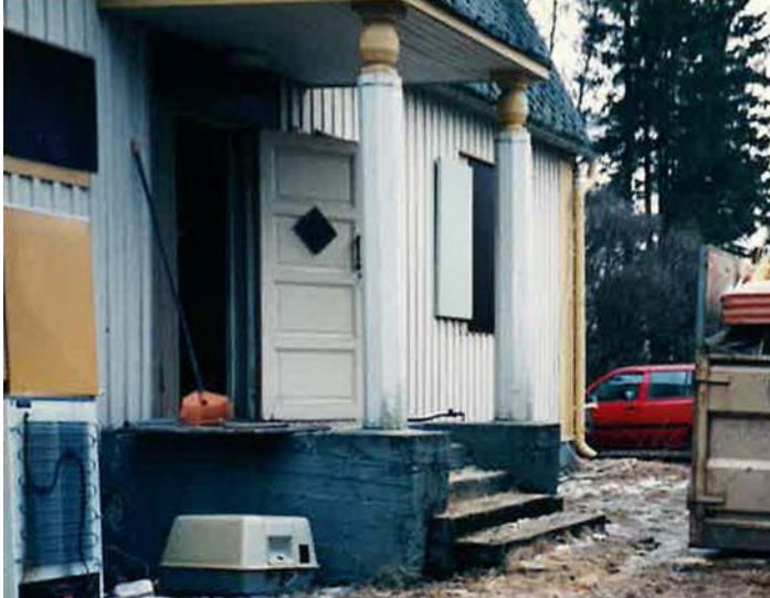
Sisäänkäynti ennen peruskorjausta. Kuva 04/1997 EV
