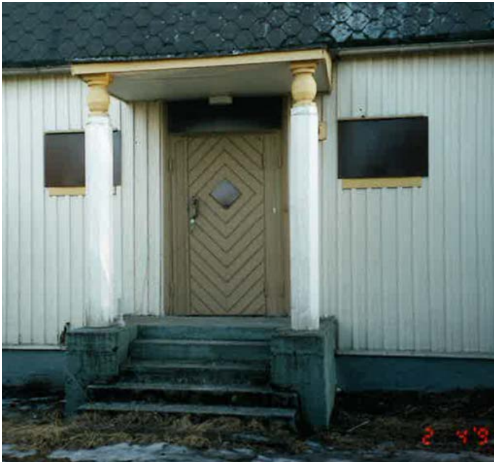
Sisäänkäynti ennen peruskorjausta. Kuva 04/1997 EV
