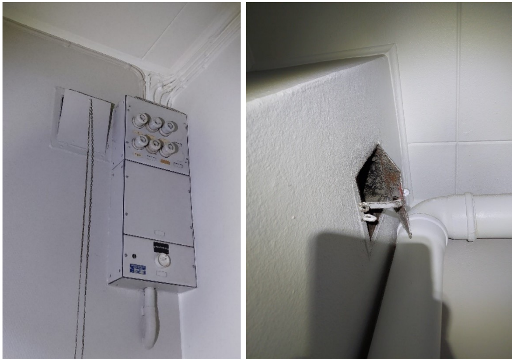
Kuva 99. Tuloilmaventtiilit olivat ketjulla avattavaa mallia. Poistoventtiilit wc-tiloissa olivat alhaalta aukeavia luukkuja.
