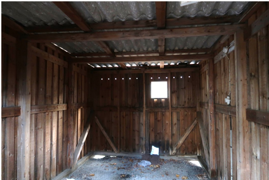
Kuva 44. Palopäällikön autotalli on lautarakenteinen, kylmä rakennus.
