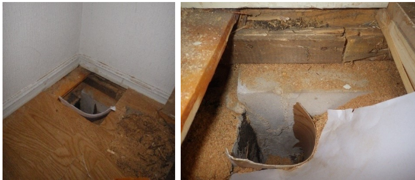
Kuva 88. Avauksesta ei havaittu poikkeavaa hajua. Avauksen kohdalla oli välipohjan betonipalkki sekä maanvastaisen seinän muurauksen yläosa.
