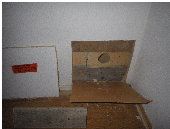
Kuva 76. Avauksesta ei havaittu poikkeavaa hajua ja vähäinen ilmavirtaus rakenteesta sisätiloihin päin. Rakenteessa oli hämähäkinseittiä.
