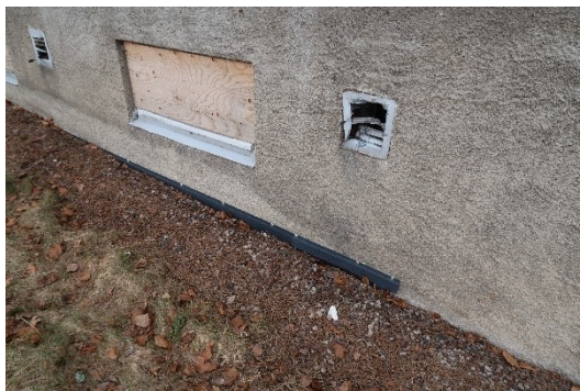
Kuva 98. Kellarikerroksen tuloilmasäleiköt oli lähes kaikki rikottu. Ensimmäisen ja toisen kerroksen säleiköt olivat kunnossa.
