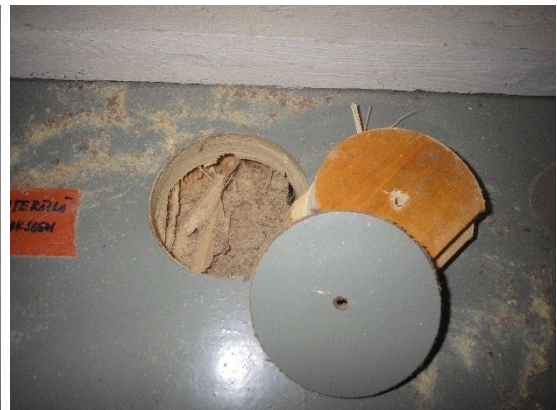
Kuva 84. Avauksesta ei havaittu poikkeavaa hajua eikä ilmavirtausta rakenteen ja sisätilojen välillä.
