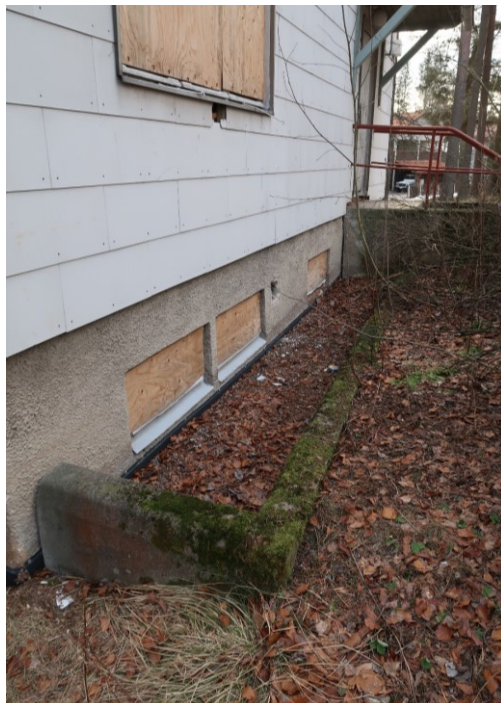
Kuva 59. Betonikaukalo länsipäädyssä ja länsipäädyn betoniporras. Betoniportaan rakenteet ovat lohkeilleet.
