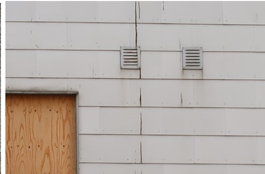
Kuva 98. Kellarikerroksen tuloilmasäleiköt oli lähes kaikki rikottu. Ensimmäisen ja toisen kerroksen säleiköt olivat kunnossa.
