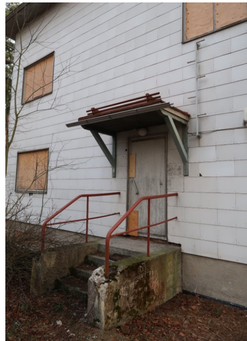
Kuva 59. Betonikaukalo länsipäädyssä ja länsipäädyn betoniporras. Betoniportaan rakenteet ovat lohkeilleet.
