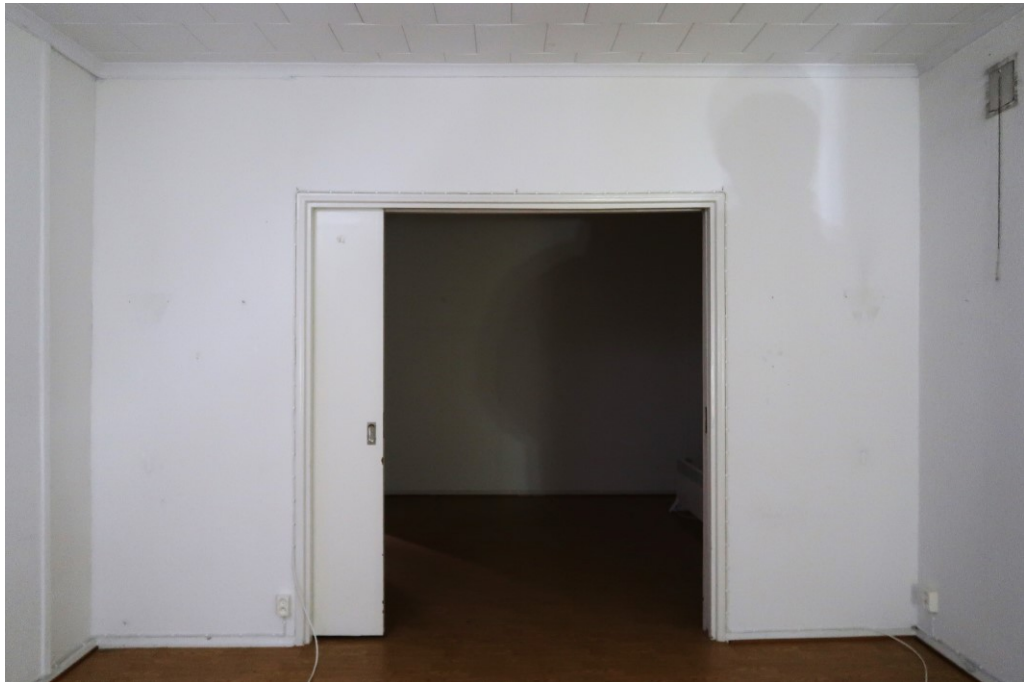
Kuva 47. Molemmissa kerroksissa on olo- ja ruokahuoneen välillä seinän sisään menevät liukuovet.
