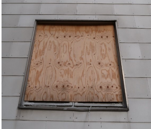
Kuva 78. Ikkunoiden ympärillä on mineriittipinnassa metallilistat ja alareunassa vesipelti.
