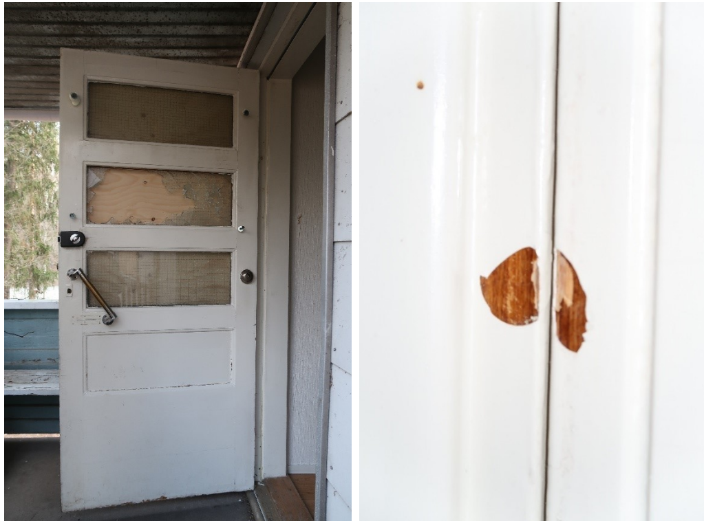
Kuva 55. Ulko-ovet ovat alkuperäisiä, samoin kahvat. Sivusisäänkäynnin ovesta on lasit, toinen ulko-ovi on umpiovi. Väliovet ja niiden listat ovat olleet petsattuja ja lakattuja.
