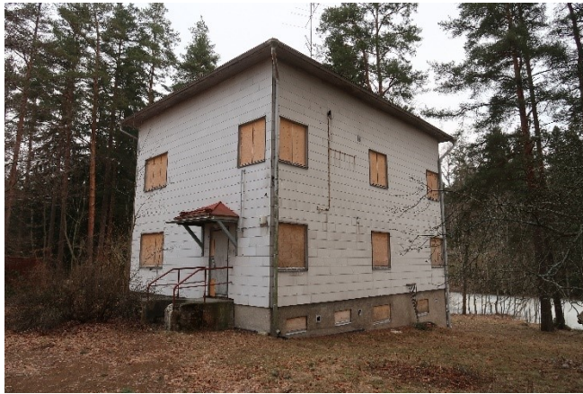
Kuva 58. Rakennus sijaitsee rinteessä ja maanpinnan kallistukset sen ympärillä ovat loivia, mutta pääosin poispäin rakennuksesta.
