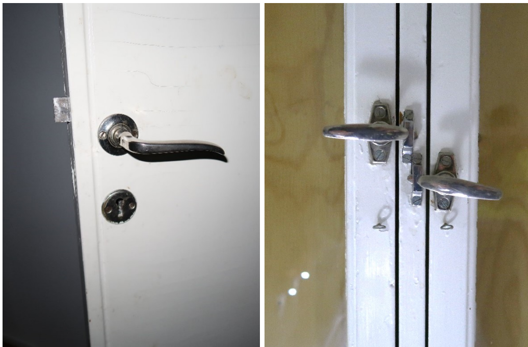
Kuva 54. Ovenkahvat ovat alkuperäisiä, niklattuja. Samoin ikkunahelat.
