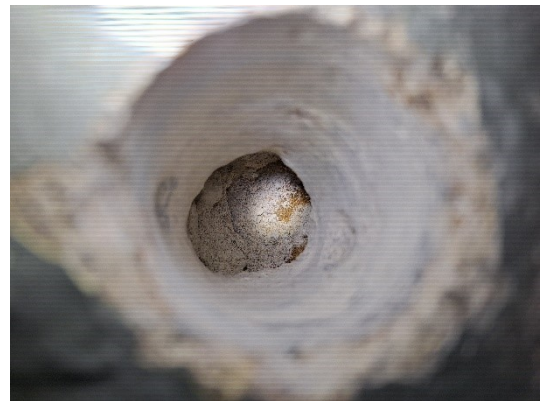
Kuva 67. Avauksesta havaittiin kostean hiekan haju ja selvä ilmavirtaus rakenteesta sisätiloihin päin.
