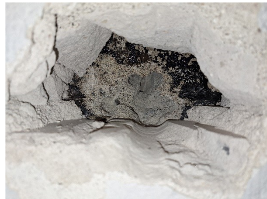
Kuva 69. Avauksesta ei havaittu poikkeavaa hajua ja ilmvirtaus oli selvästi rakenteesta sisätiloihin päin.
