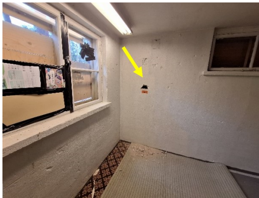
Kuva 69. Avauksesta ei havaittu poikkeavaa hajua ja ilmvirtaus oli selvästi rakenteesta sisätiloihin päin.
