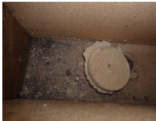
Kuva 76. Avauksesta ei havaittu poikkeavaa hajua ja vähäinen ilmavirtaus rakenteesta sisätiloihin päin. Rakenteessa oli hämähäkinseittiä.
