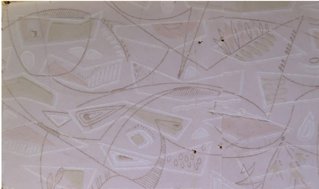
Kuva 16. Toisen kerroksen olohuoneesta esille otettua 1950-luvun tapettia. Tapetin päälle on asennettu uusi huokokuitulevykerros.
