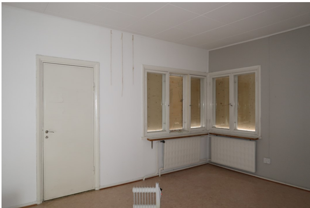
Kuva 46. Toisen kerroksen asunnon olohuoneen nurkkaikkuna ja ovi itäjulkisivun parvekkeelle.
