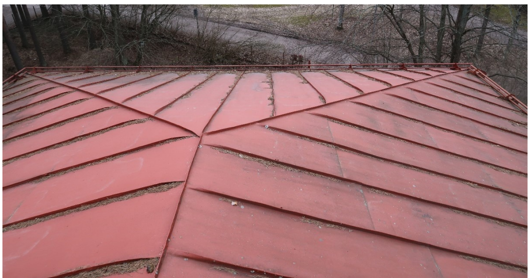
Kuva 96. Yleiskuvaa katosta länsilappeen suuntaan.
