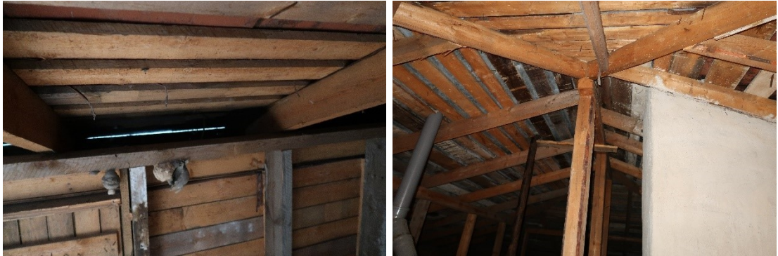
Kuva 93. Räystäällä on kauttaaltaan kapea, avoin tuuletusrako, jossa ei ole pieneläinverkkoa. Vesikaton puurakenteen ovat pääosin hyväkuntoisia. Hormin pinnassa ei havaittu valumajälkiä.
