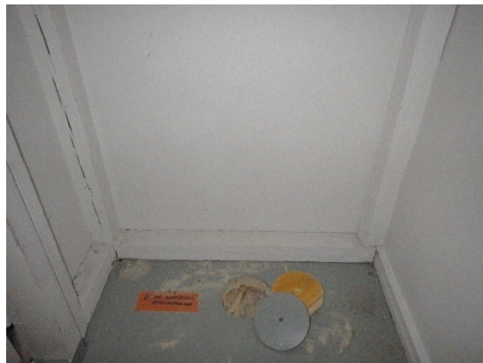
Kuva 84. Avauksesta ei havaittu poikkeavaa hajua eikä ilmavirtausta rakenteen ja sisätilojen välillä.
