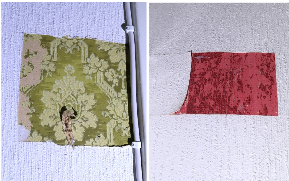
Kuva 56. Paikoin nykyisen tapetin alta on otettu esille vanhempia, todennäköisesti 1960-luvun tapetteja.
