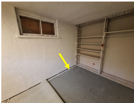
Kuva 67. Avauksesta havaittiin kostean hiekan haju ja selvä ilmavirtaus rakenteesta sisätiloihin päin.
