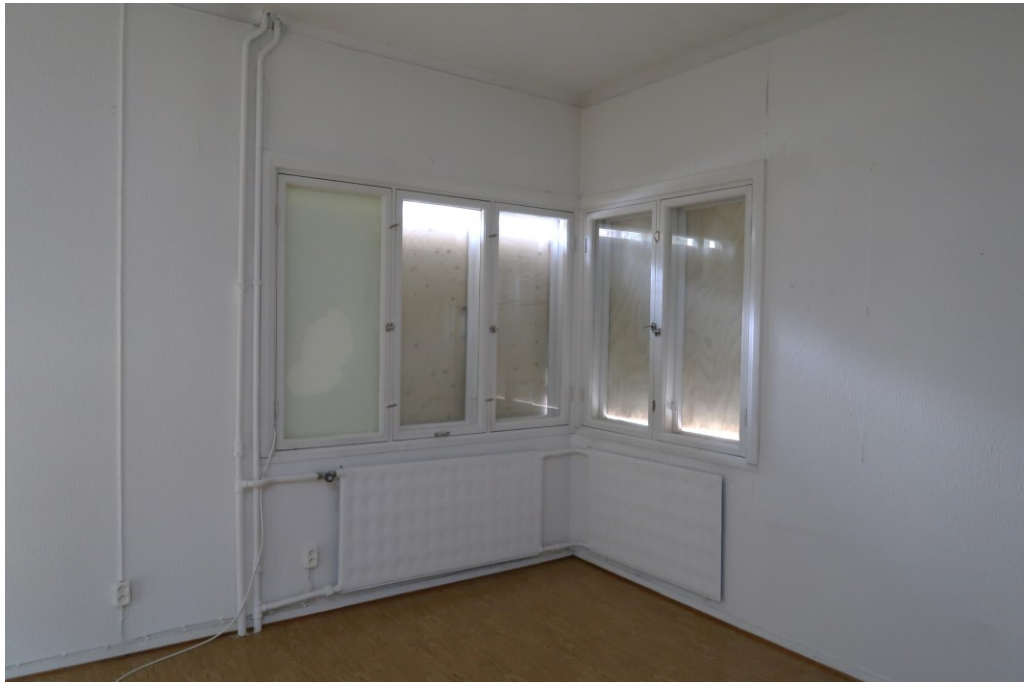
Kuva 45. Ensimmäisen kerroksen asunnon olohuoneen nurkkaikkuna.
