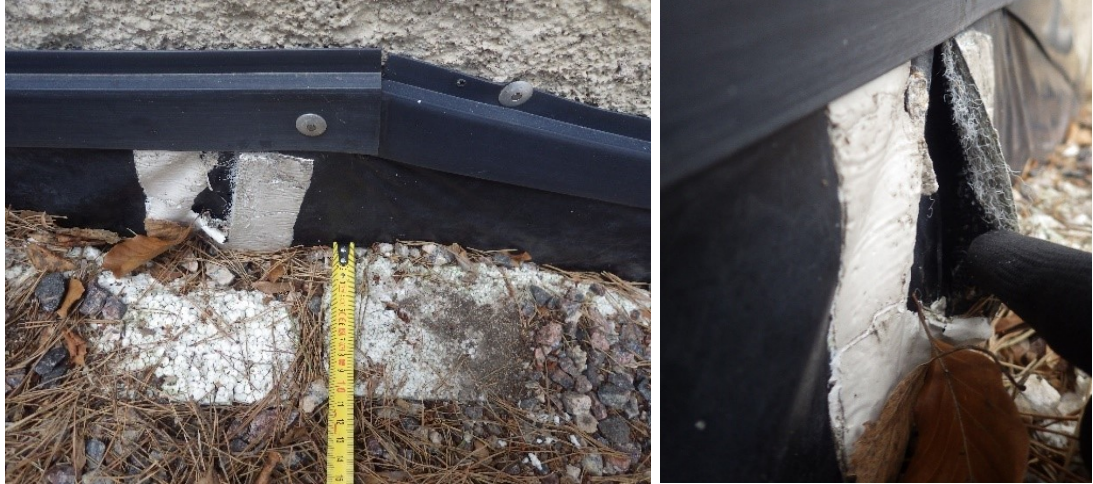
Kuva 62. Vasemmalla perusmuuria vasten kosteudeneristys ja lämmöneriste (100 mm EPS). Oikealla kosteudeneristeenä käytetyn maton rakennetta.
