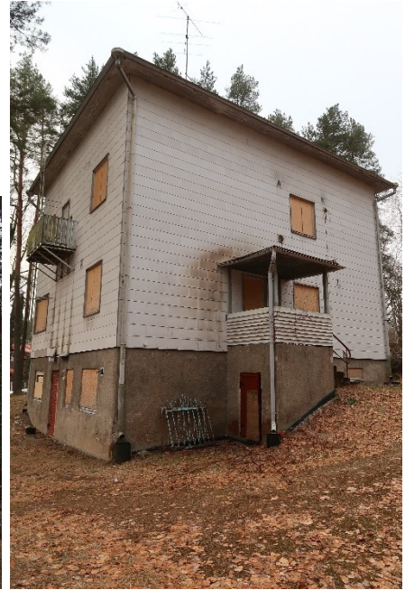
Kuva 58. Rakennus sijaitsee rinteessä ja maanpinnan kallistukset sen ympärillä ovat loivia, mutta pääosin poispäin rakennuksesta.
