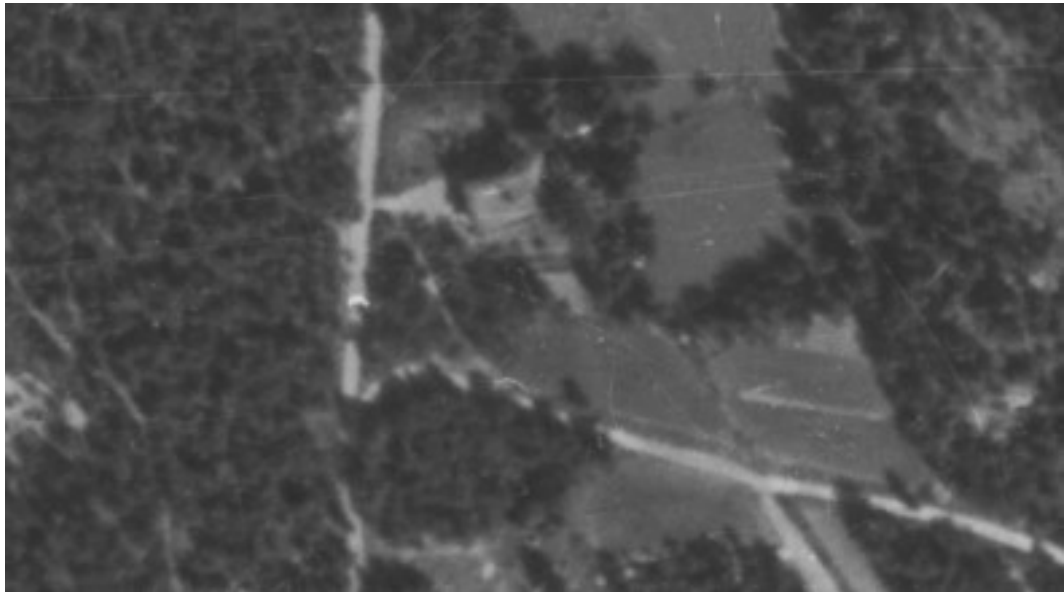
Kuva 33. Vuoden 1946 ilmakuvasa rakennuksen pihapiiri on osittain avointa, puustoa on Hiirilammen rannassa ja tietä vasten. Katto vaikuttaisi alkuperäiseltä pulpettikatolta. Liiteri on paikoillaan. Maanmittauslaitoksen historialliset ilmakuvat.
