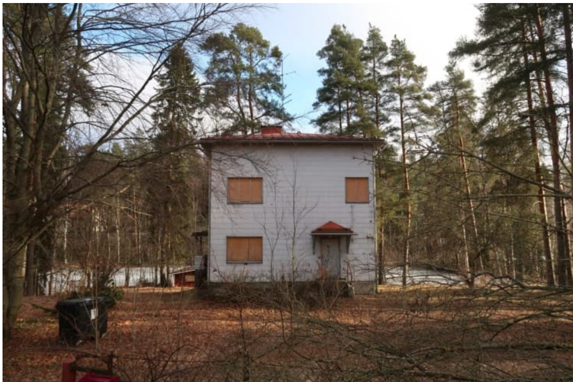
Näkymä Hiiripolulta. Valokuva Afry Oy / korjattavuusselvitys.
