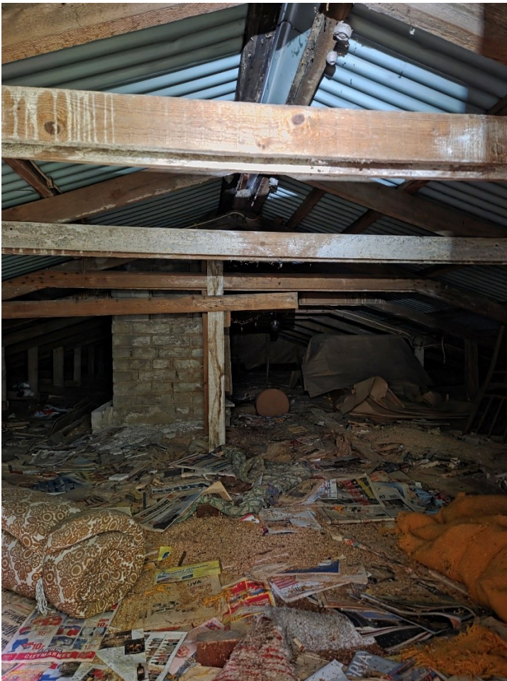
Kuva 2. Pitkäsentie 8:n yläpohjasta ei löytynyt merkkejä lepakoiden oleskelusta.
