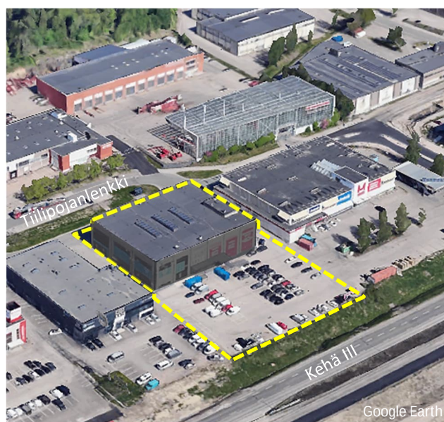
Tiilipojanlenkki 4a, johon haetaan kaupan lisäystä.
