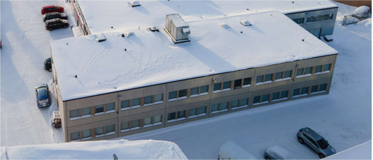
Rakennusosa E on toimistorakennus.
