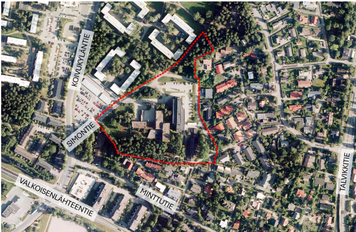
Ilmakuva kaavamuutosalueesta. Kuvassa tilanne ennen vanhustenkeskusten uudisrakentamisen aloitusta.
