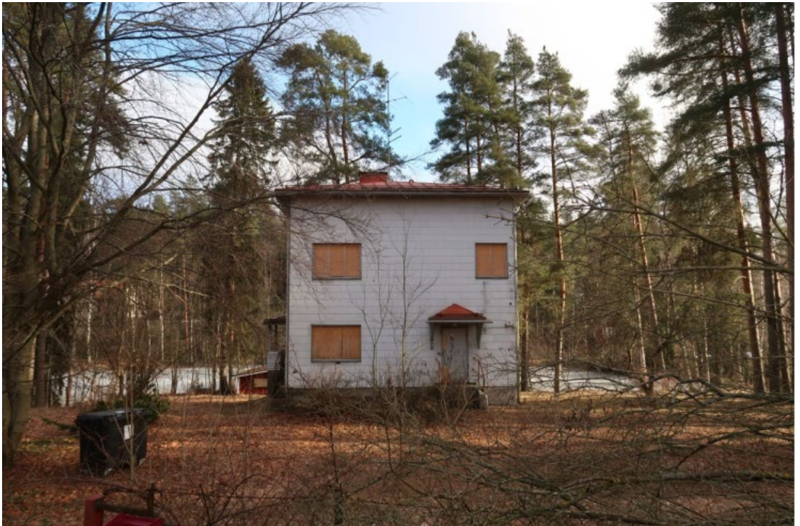
Näkymä Hiiripolulta. Valokuva Afry Oy / korjattavuusselvitys.
