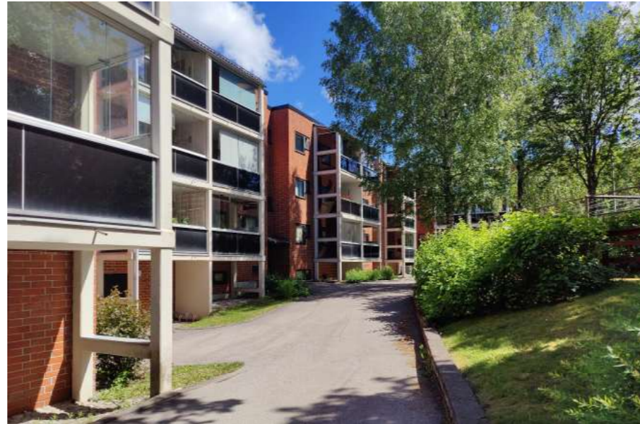
Kytötien länsipuolella rakentamisen yleisilme on matala. Julkivut tuli verhoilla punatiilellä. Kuva: Sudar Oli Gunasekaran, 2024.
