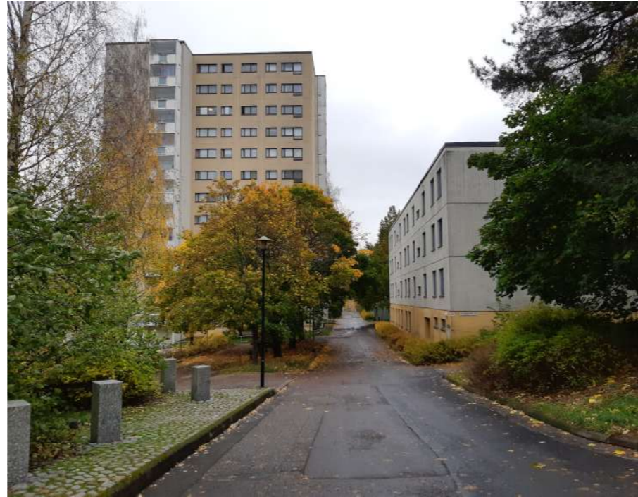
Rasinkadun kävelyraitti. Kuva: Eeva Eitsi, 2020.
