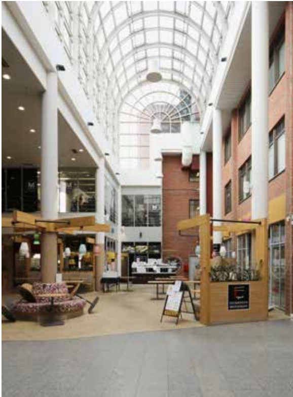
↑ Myös keskusaula on katettu holvimaisella valokatteella. Olkean puoleinen seinä on aiemmin rakennetun virastotalon vanha ulkoseinä.
